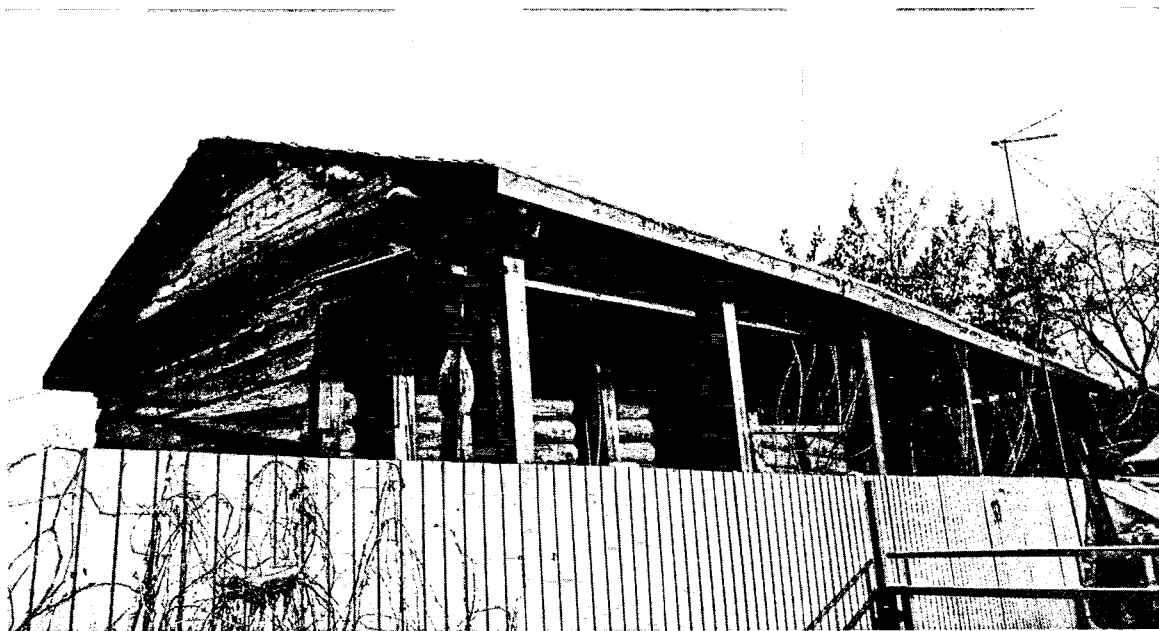
Фото 1 – Вид с запада.
