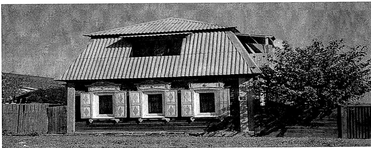
Главный лицевой (западный) фасад дома.
