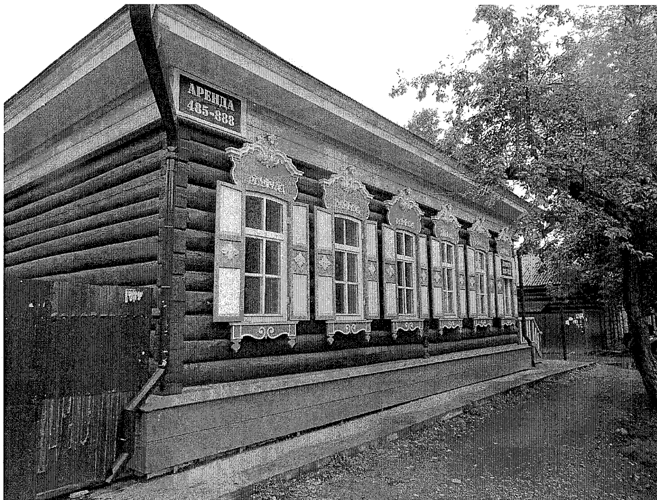
Главный (северо-восточный) и фрагмент бокового (юго-восточного) фасада основного объема.
