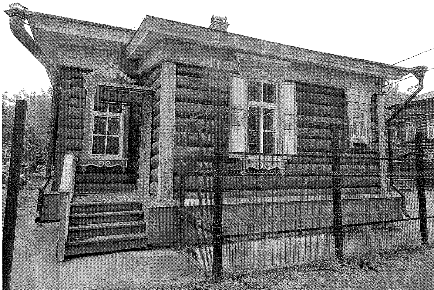
Прируб сеней со стороны бокового (северо-западного) фасада дома.
