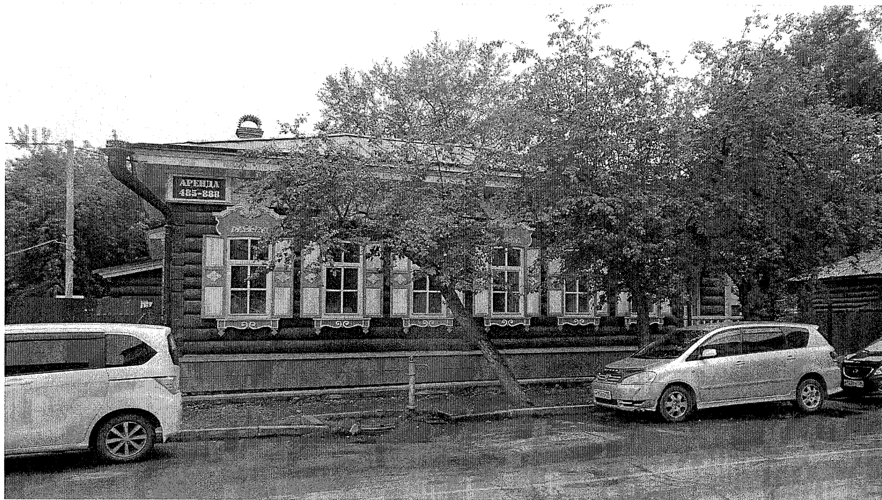
Главный (северо-восточный) фасад дома. Вид с ул. Володарского.
