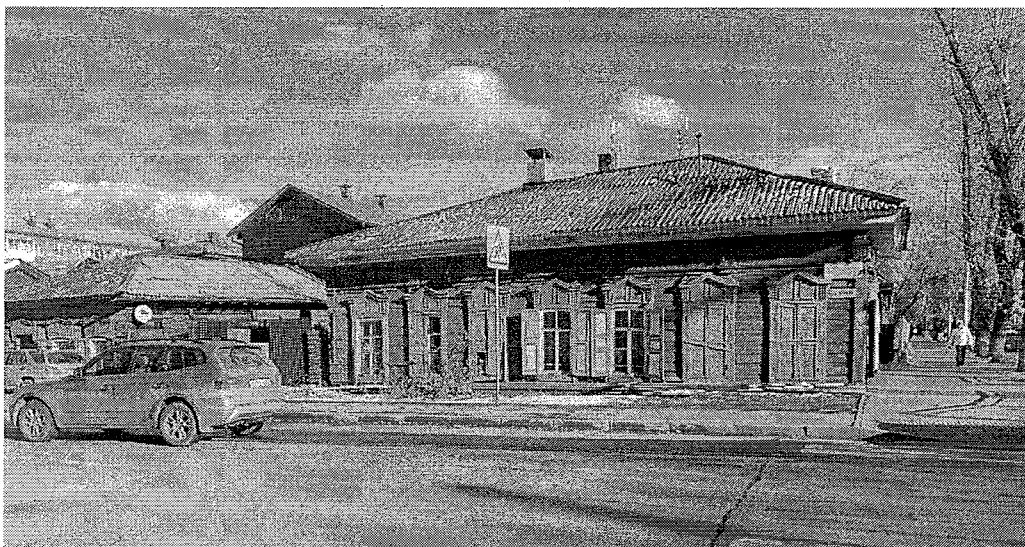
Общий вид на жилой дом (лит. Б) со стороны ул. Уткина.
