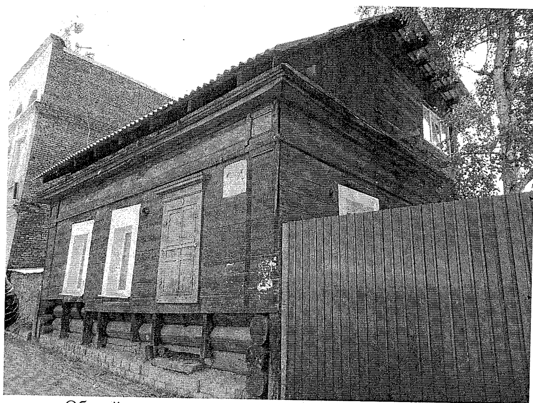
Общий вид с северного угла (ул. Б.Хмельницкого).
