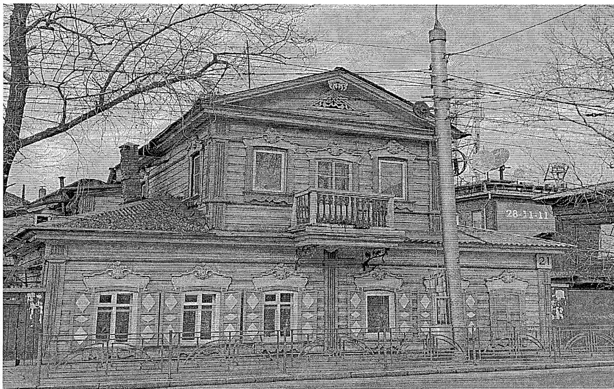
Главный (юго-восточный) фасад.
