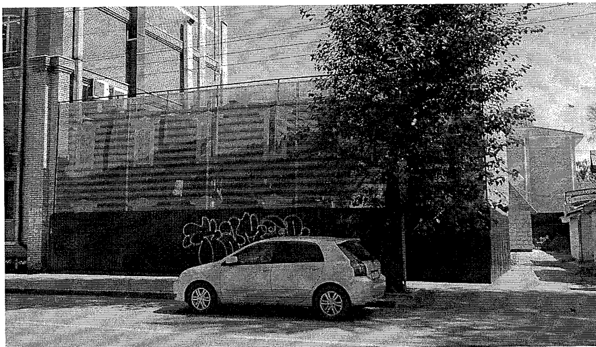
Главный (северо-западный) фасад.
