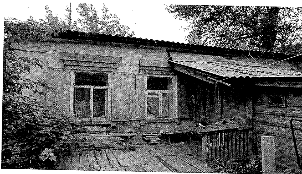
Главный (юго-восточный) фасад.
