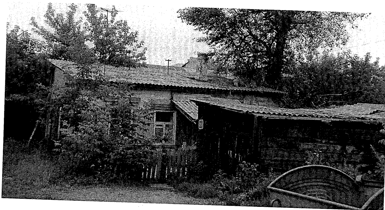
Лит. В Общий вид здания.
