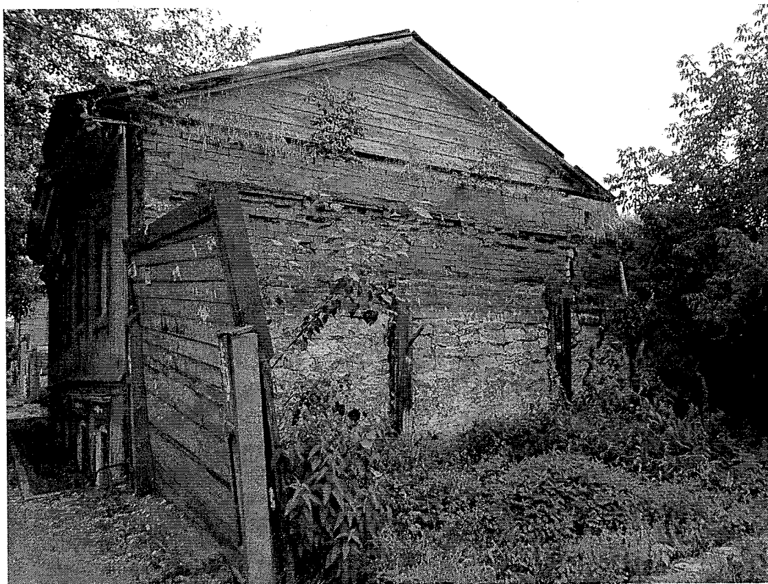
Боковой (северо-восточный) фасад. Брандмауэрная стена
