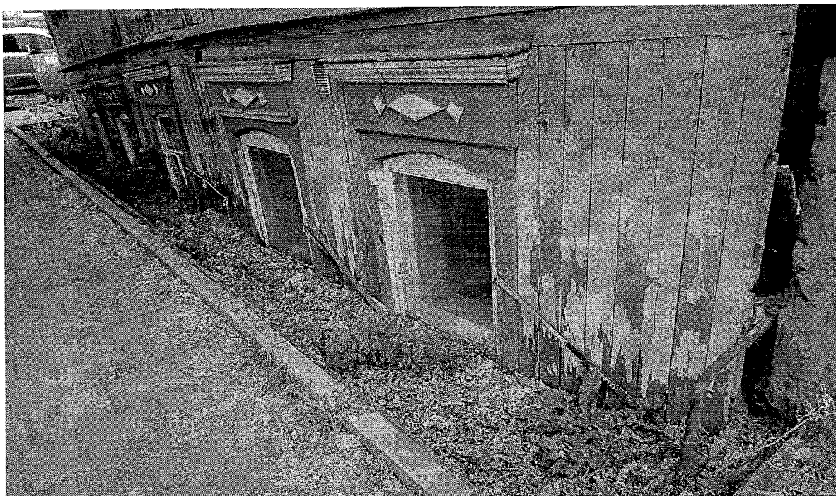
Оформление оконных проемов в уровне первого этажа главного фасада.
