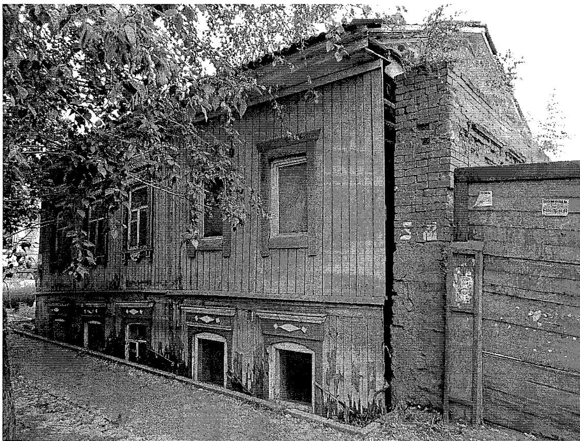
Главный (юго-восточный) фасад.
