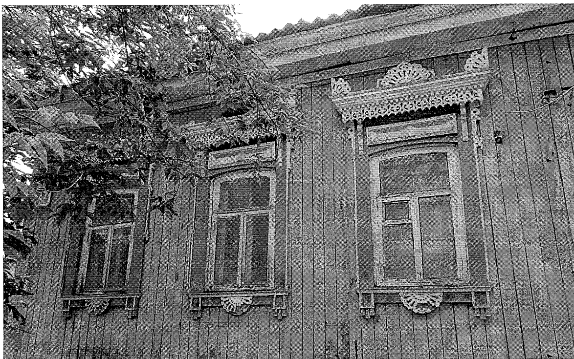
Оформление оконных проемов в уровне второго этажа главного фасада.
