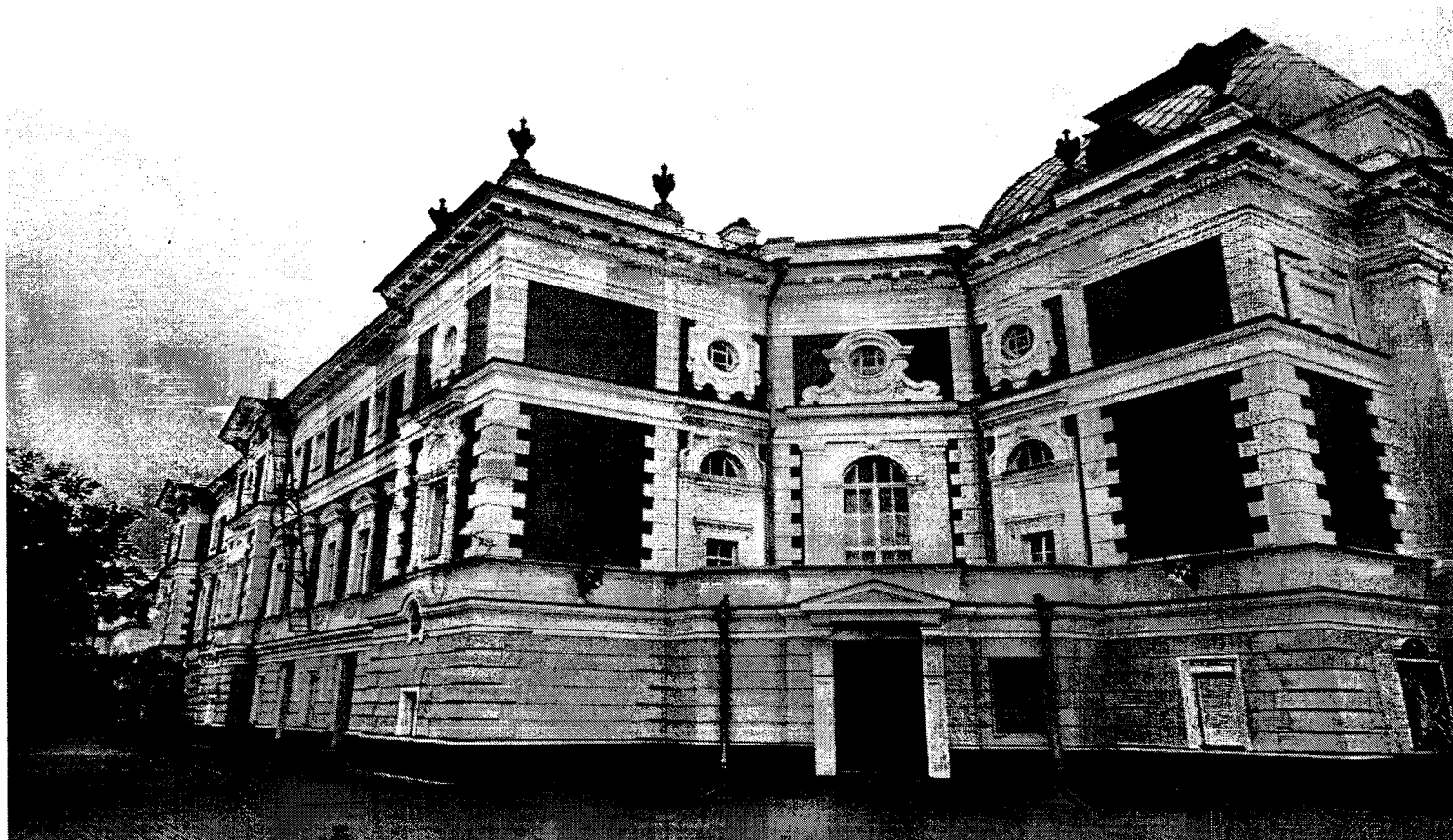
Боковой (северо-восточный) фасад и фрагмент главного (северо-западного) фасада. Боковой одноэтажный тамбур.
