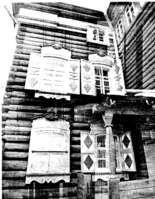
Фрагмент бокового (северо-западного) фасада.
