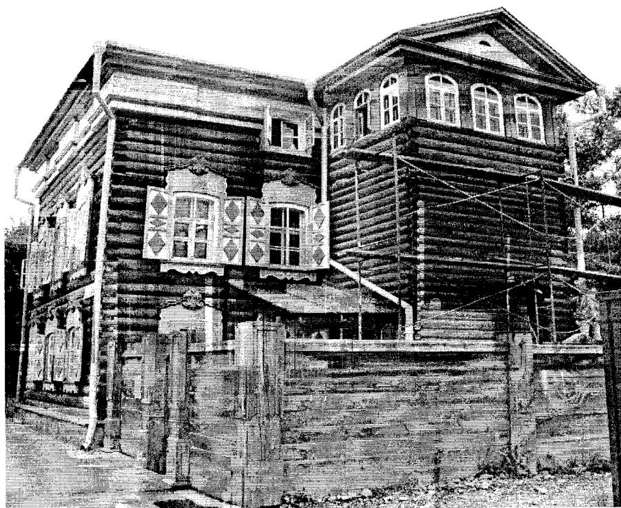
Боковой (северо-западный) фасад.
