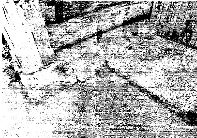
Фото 14 - Фрагмент цоколя и отмостки
