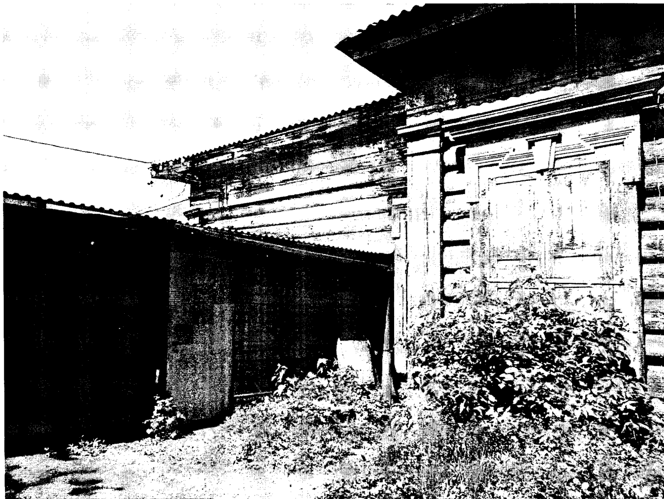
Лит. Б Фрагмент бокового (юго-восточного) фасада.
