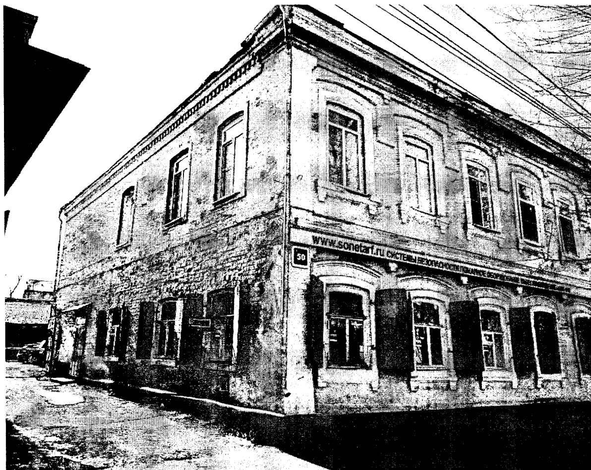
Лит. А. Боковой (юго-восточный) фасад здания.
