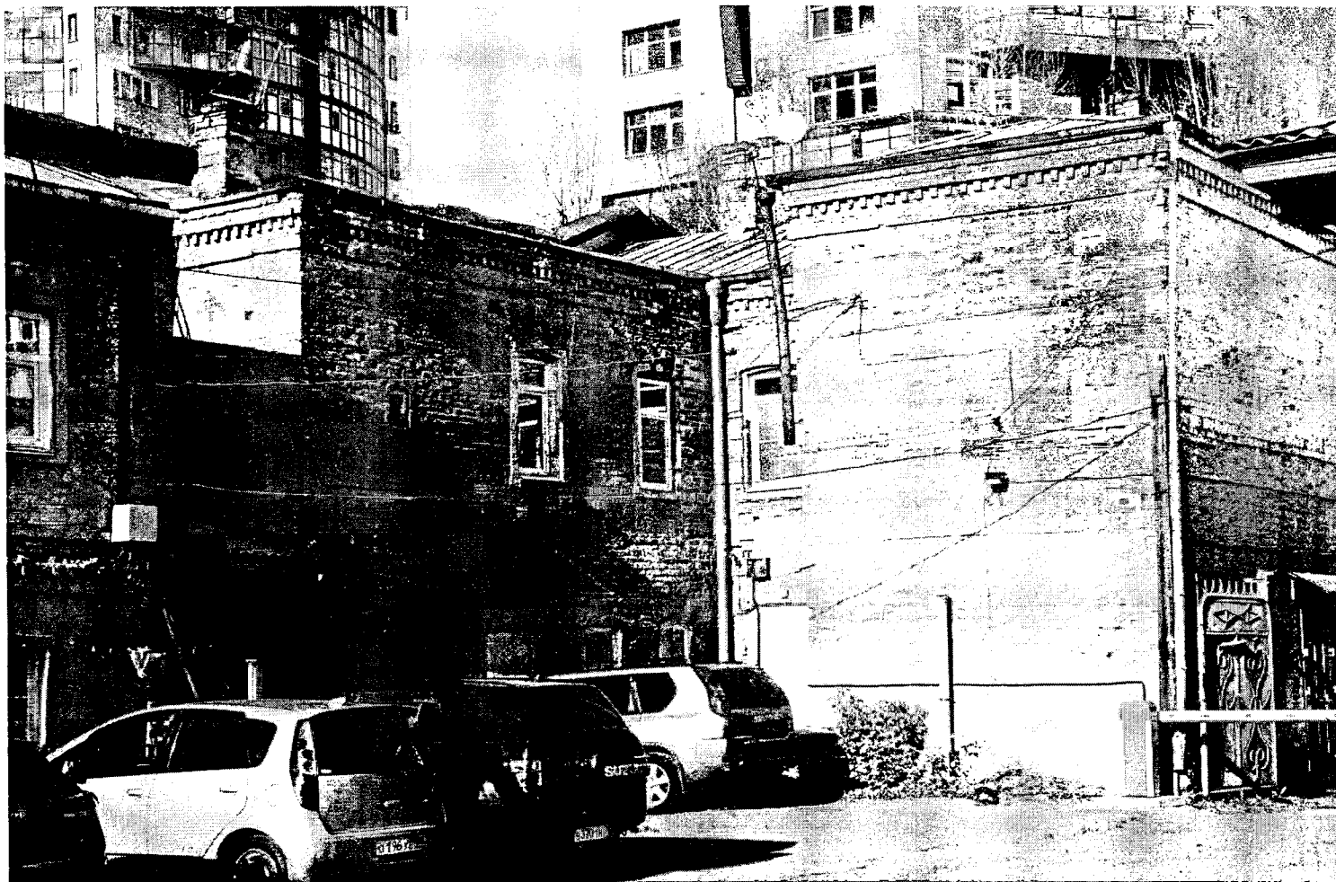
Лит. А. Дворовый (юго-западный) фасад с двумя пристроенными крыльями.
