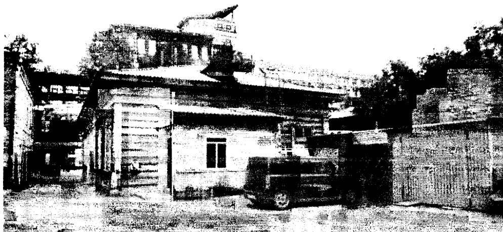
Фото 5 - Дворовый (юго-западный) фасад с поздним входным пристроем
