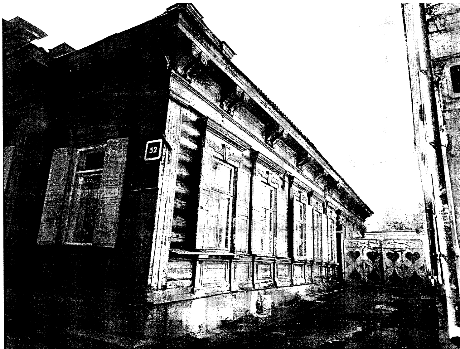
Лит. Б Фрагмент бокового (северо-западного) фасада.
