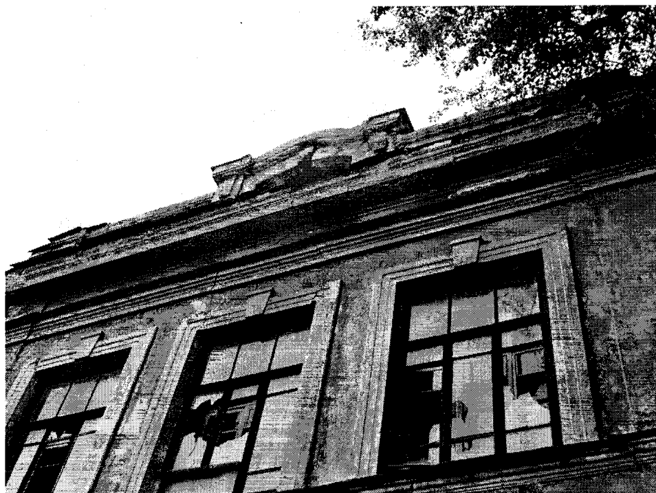
Рядовые оконные проемы 2 этажа. Аттиковая стенка по правому флангу.
