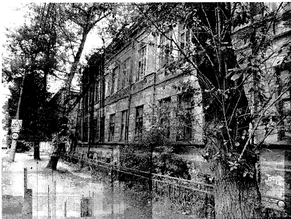
Фрагмент главного фасада. Вид с юга.
