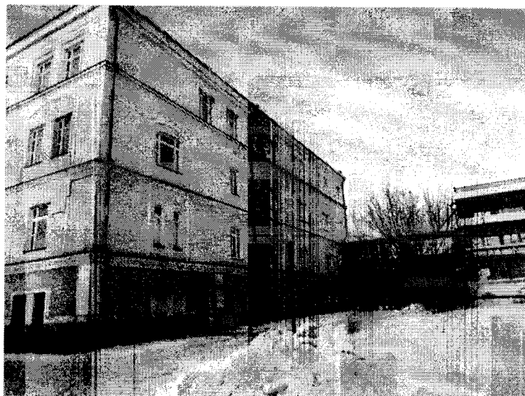
Боковой (юго-восточный) фасад Кузнецовской больницы
