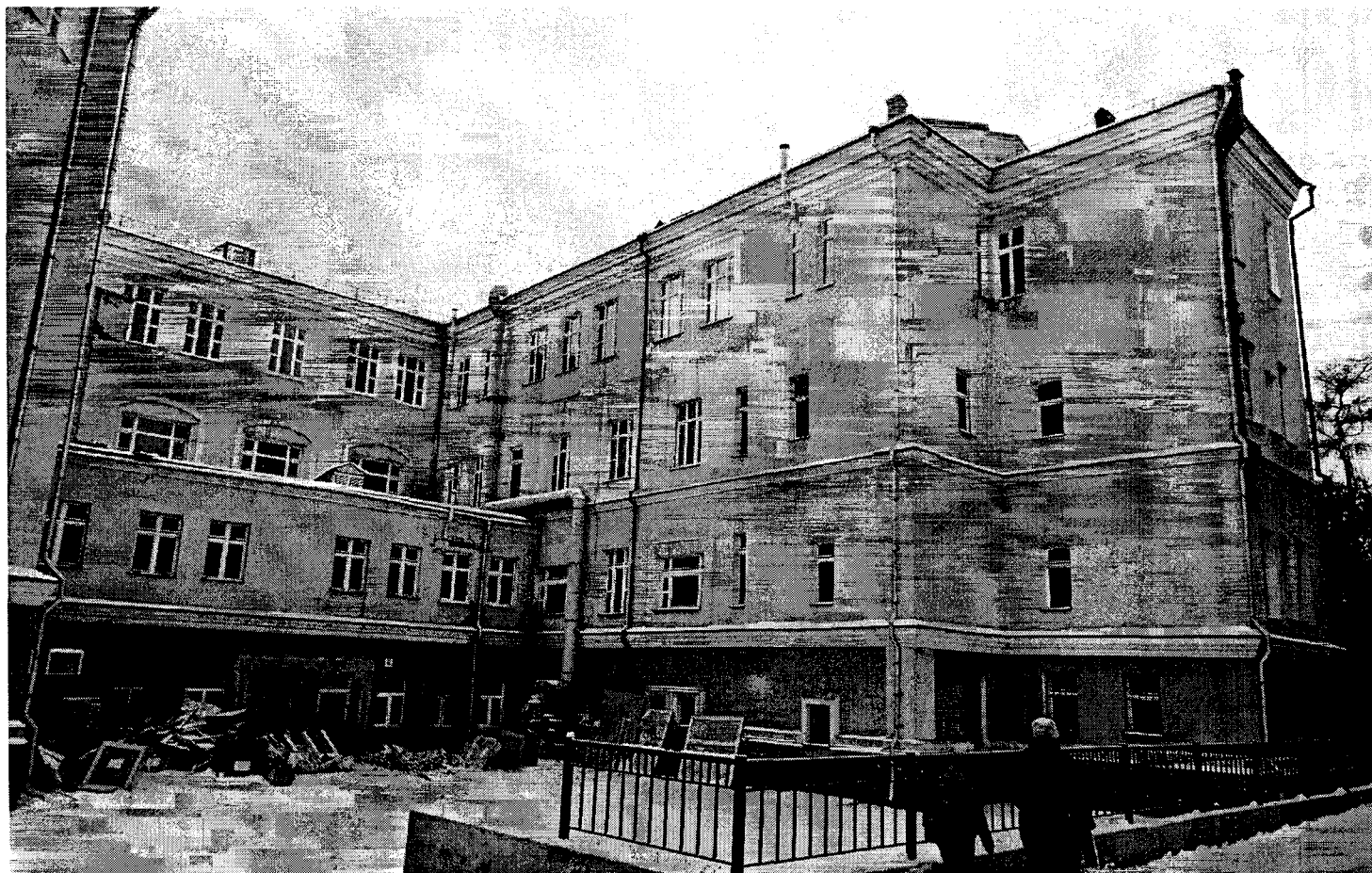
Дворовый (северо-восточный) фасад.
