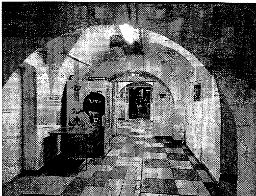
Фрагменты интерьеров подвального этажа. Крещатые своды.
