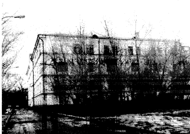
Боковой (юго-восточный) фасад, фото Хохрина Е.В., 1983г.
