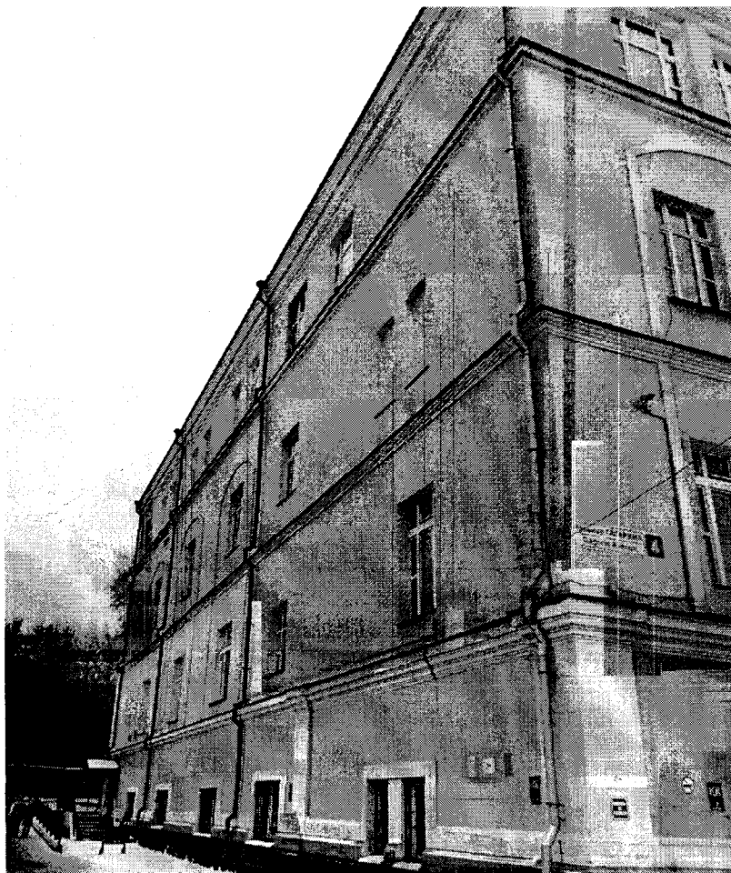
Боковой (северо-западный) фасад.
