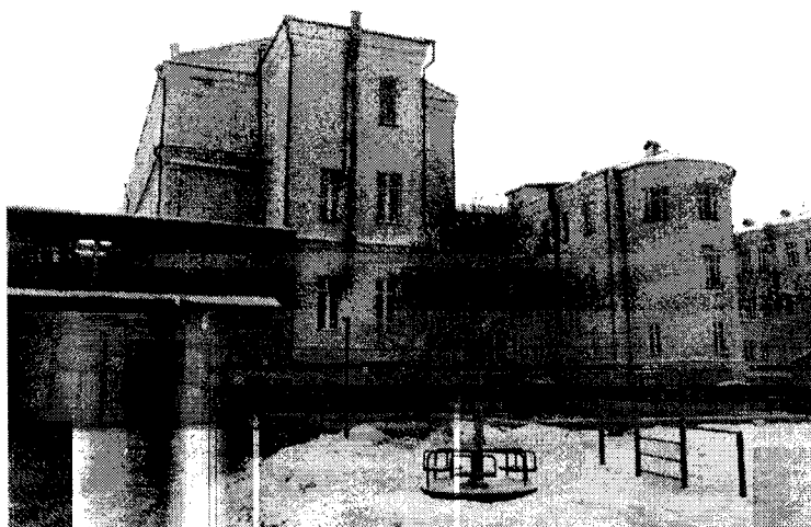
Равновысокий пристрой правого крыла дворового (северо-восточного) фасада Кузнецовской больницы
