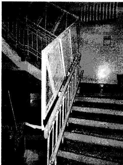
Лестница с металлическим ограждением
