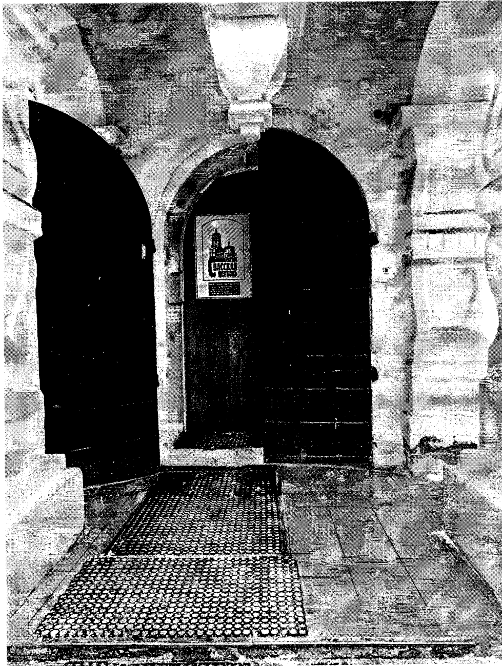
Двери главного входа в здание.
