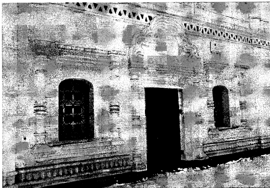
Фрагмент южного фасада в уровне 1 этажа. Придел.
