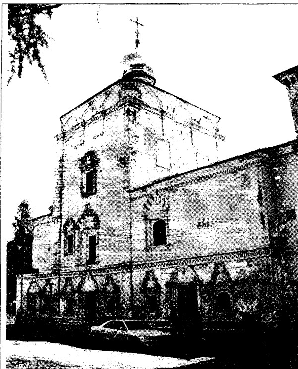
Фото 17 Северный фасад, четверик храма и трапезная
