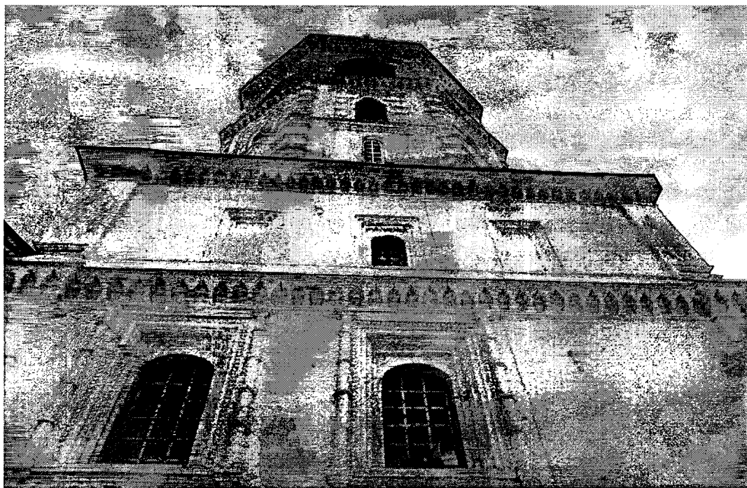
Фрагмент северного фасада. Притвор в уровне 2 этажа и второго света. Колокольня.
