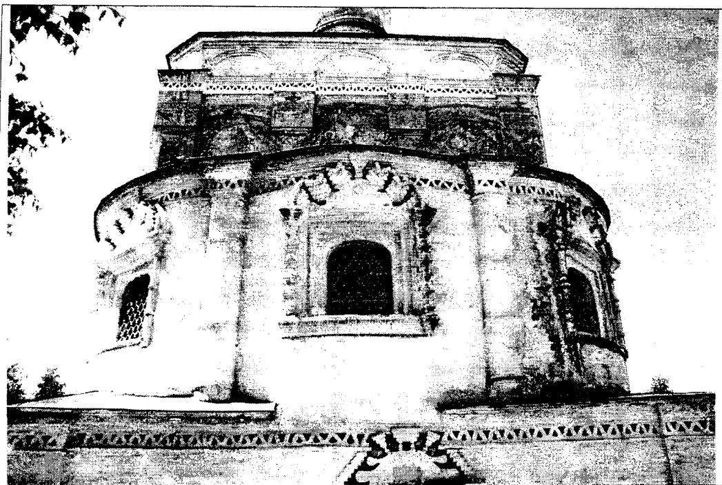
Фото 15 Восточный фасад, второй ярус апсиды
