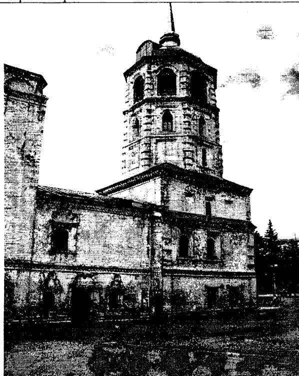
Фото 18 Северный фасад, трапезная и колокольня
