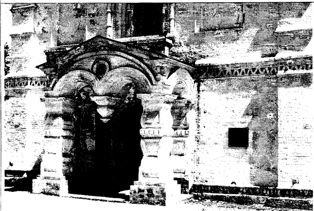
Фото 31 Западный фасад; крыльцо
