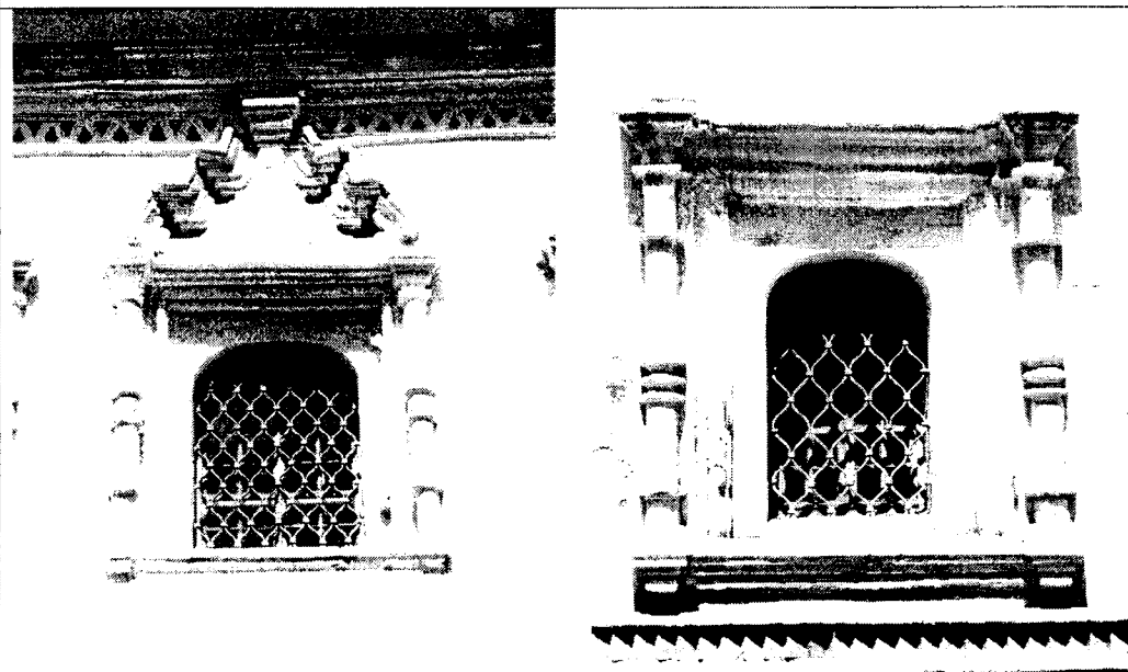
Фото 8 Окна второго и первого яруса южного фасада трапезной
