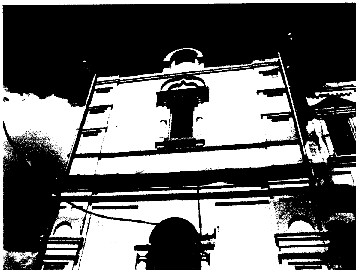
17. Фрагмент южного фасада; притвор
