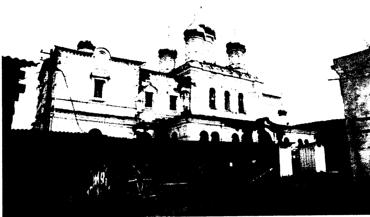
3. Южный фасад, вид юго-запада
