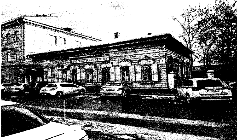
Главный (северо-западный) фасад жилого дома (лит. А).
