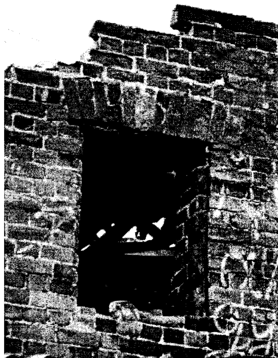
Фото 19. Ул. Грязнова, 34, лит. Б. ОКН «Застройка ул. Грязнова. Усадьба Ковалёвой: два жилых дома». Общий вид со двора. Фрагмент северо-восточного фасада. Чердачное окно. Фото 2017 г.
