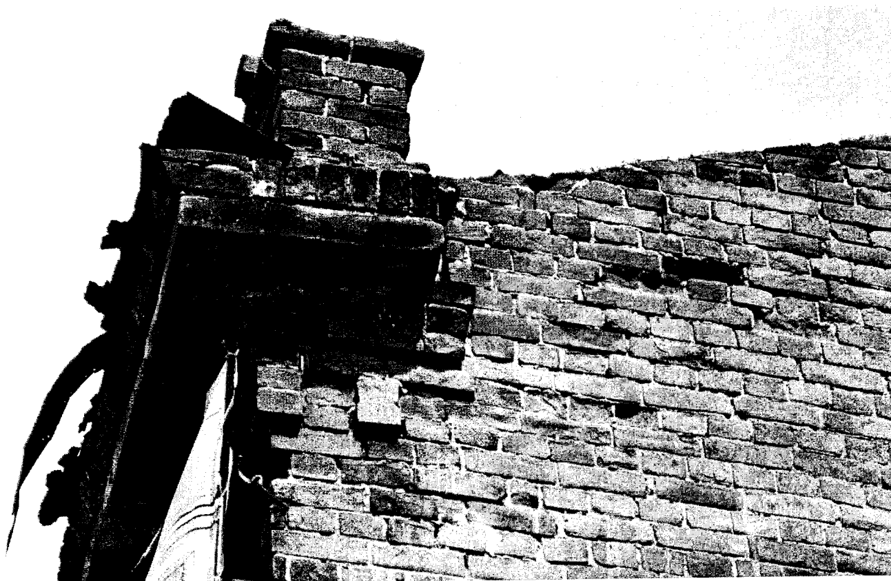
Фото 22. Ул. Грязнова, 34, лит. Б. ОКН «Застройка ул. Грязнова. Усадьба Ковалёвой: два жилых дома». Фрагмент юго-западного фасада. Фриз, карниз, парапетный столбик. Фото 2017 г.
