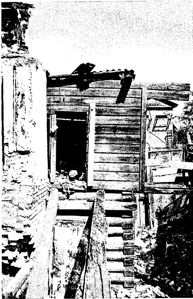
Фото 7. Ул. Грязнова, 34, лит. А. ОКН «Застройка ул. Грязнова. Усадьба Ковалёвой: два жилых дома». Фрагмент юго-западного фасада. Фото 2017 г.
