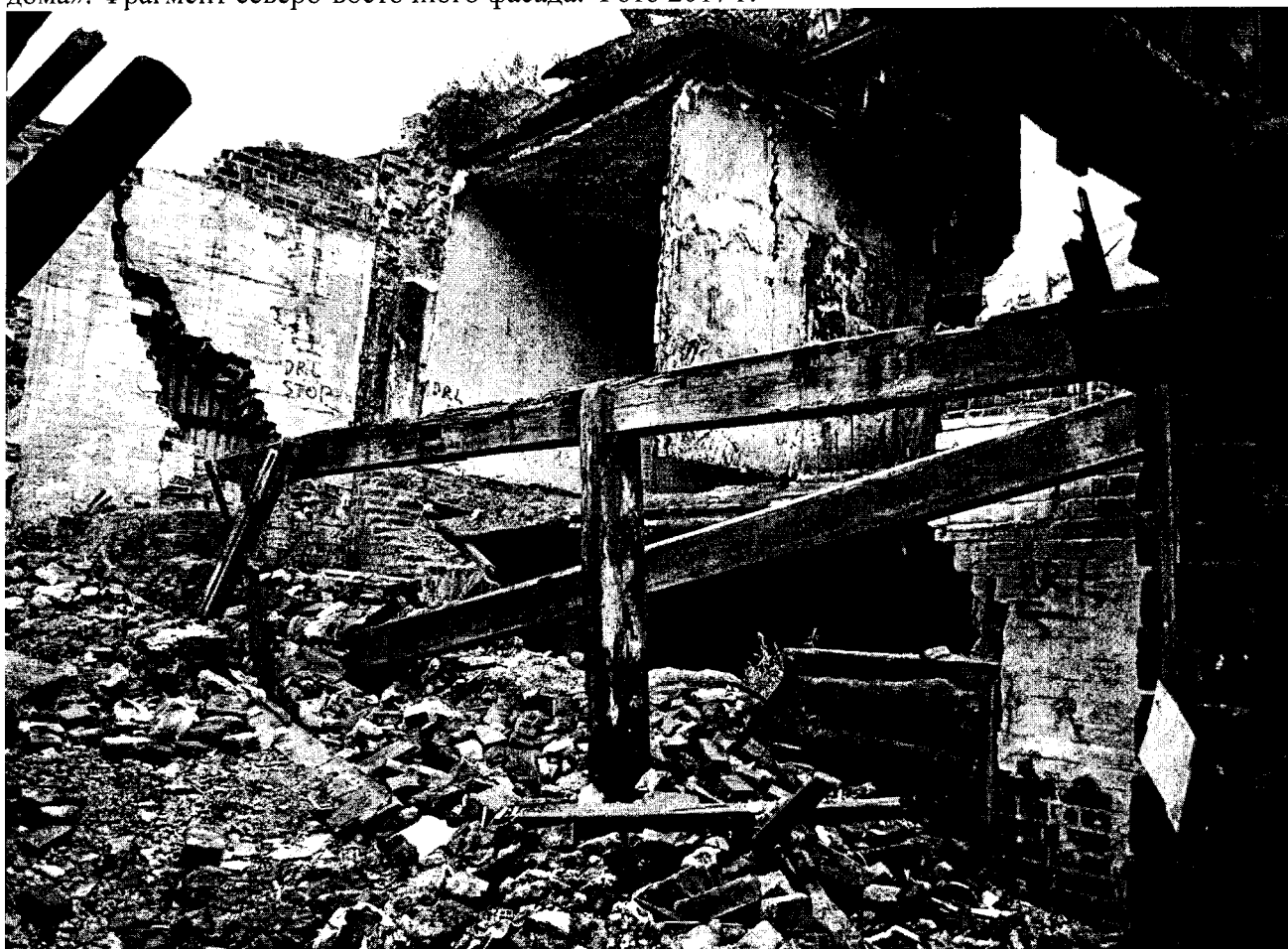
Фото 13. Ул. Грязнова, 34, лит. Б. ОКН «Застройка ул. Грязнова. Усадьба Ковалёвой: два жилых дома». Общий вид со двора. Разрушенные галерея, юго-восточная стена основного объёма и лестничная клетка. Фото 2017 г.
