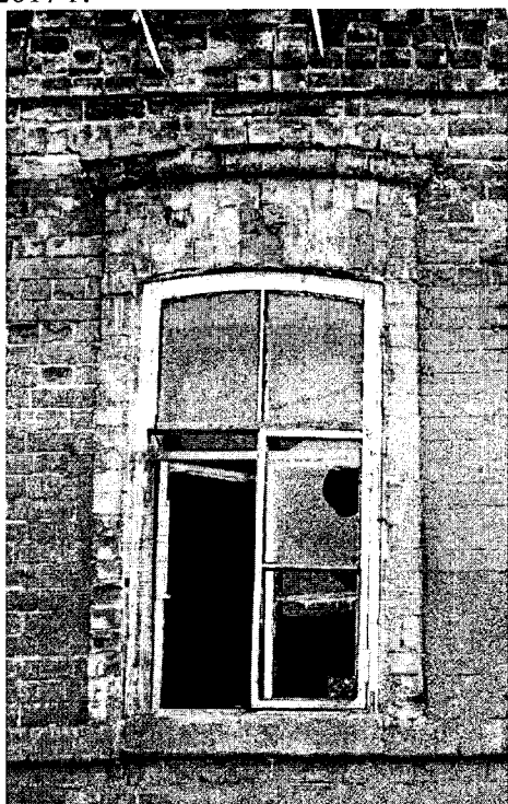
Фото 18. Ул. Грязнова, 34, лит. Б. ОКН «Застройка ул. Грязнова. Усадьба Ковалёвой: два жилых дома». Общий вид со двора. Фрагмент северо-западного фасада. Оконный проём второго этажа, межэтажный пояс. Фото 2017 г.
