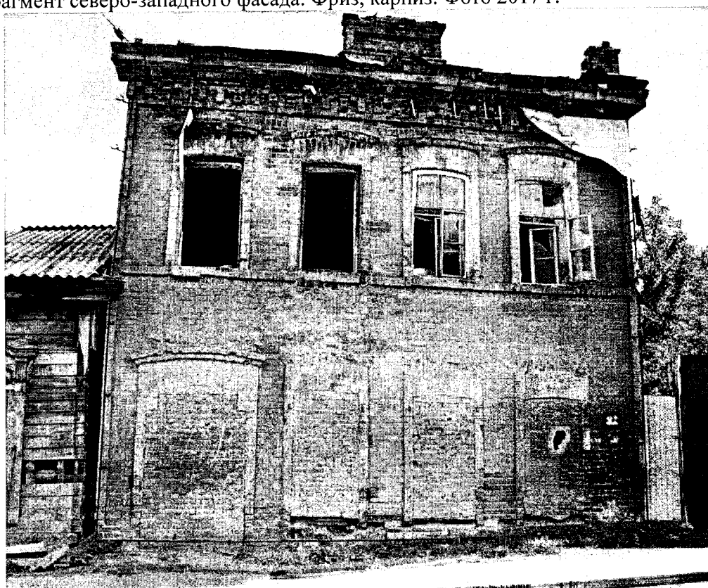
Фото 11. Ул. Грязнова, 34, лит. Б. ОКН «Застройка ул. Грязнова. Усадьба Ковалёвой: два жилых дома». Северо-западный фасад. Фото 2017 г.
