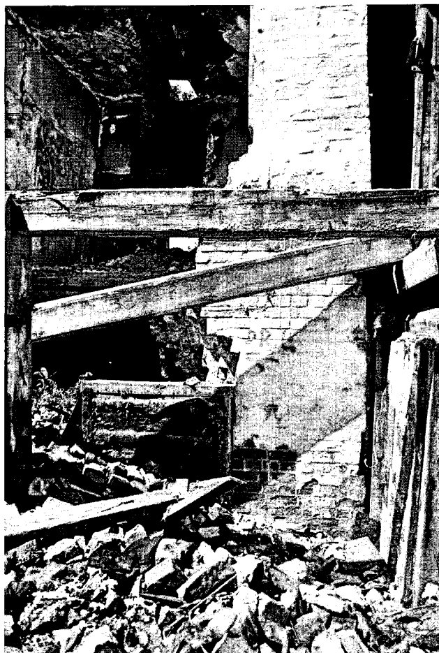
Фото 20. Ул. Грязнова, 34, лит. Б. ОКН «Застройка ул. Грязнова. Усадьба Ковалёвой: два жилых дома». Общий вид со двора. Фрагмент юго-восточного фасада. Дверной проём первого этажа, остатки дворовой галереи. Фото 2017 г.
