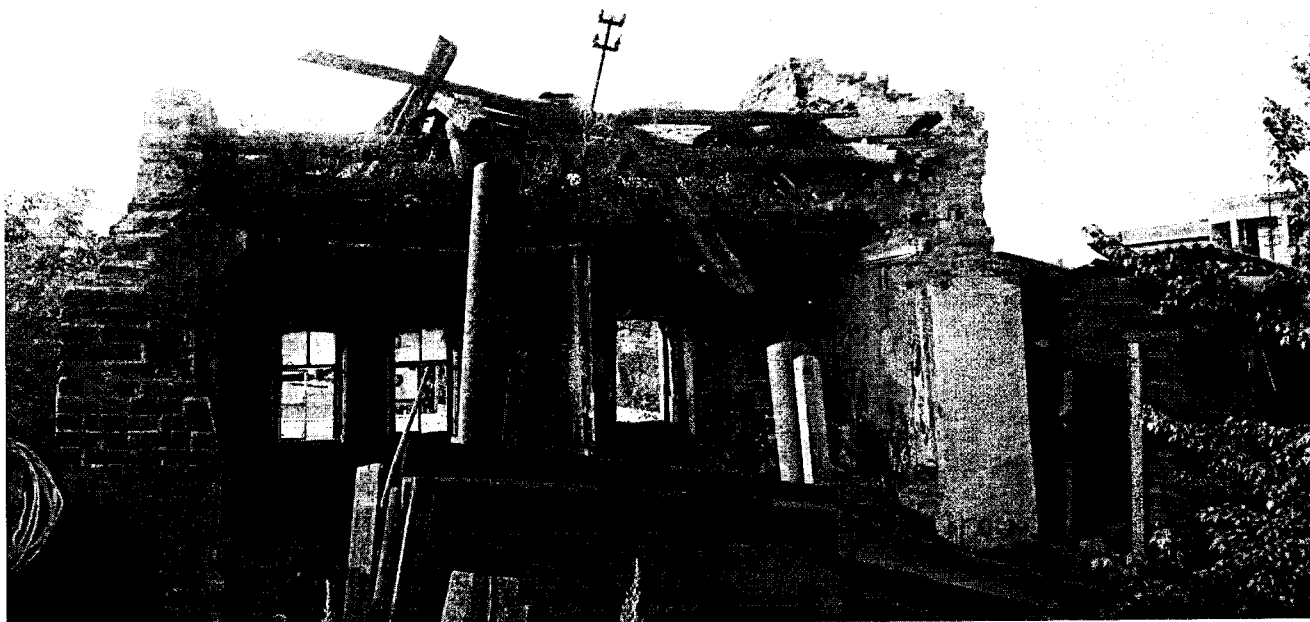
Фото 14. Ул. Грязнова, 34, лит. Б. ОКН «Застройка ул. Грязнова. Усадьба Ковалёвой: два жилых дома». Общий вид со двора. Фрагмент юго-восточного фасада. Фото 2017 г.
