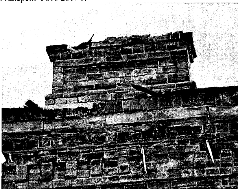
Фото 21. Ул. Грязнова, 34, лит. Б. ОКН «Застройка ул. Грязнова. Усадьба Ковалёвой: два жилых дома». Фрагмент северо-западного фасада. Фриз, карниз, аттик. Фото 2017 г.
