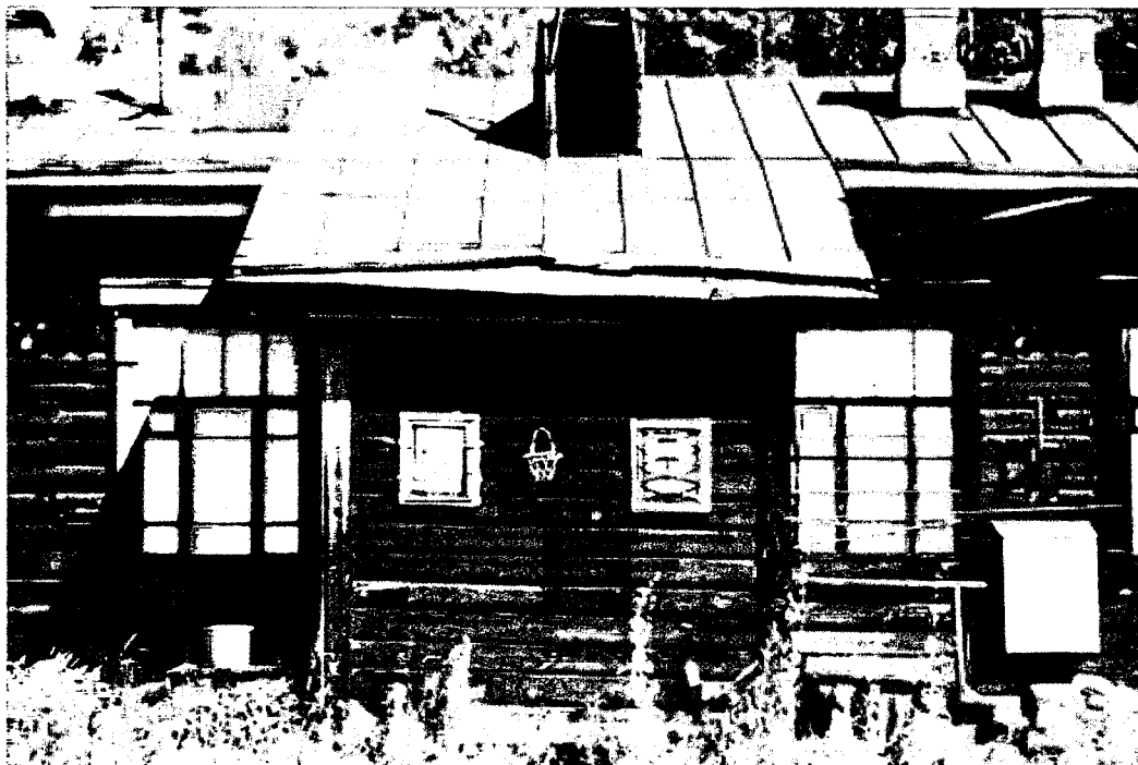
Фото 5. Прируб сени южного фасада Фото Коровкина С.Ю., 2016г
