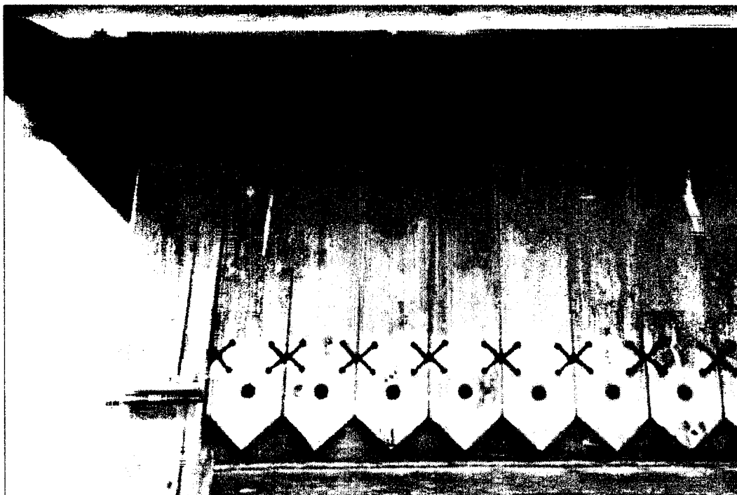
Фото 13. Фриз и навершие угловой лопатки основного сруба. Фото Коровкина С.Ю.. 2015г.
