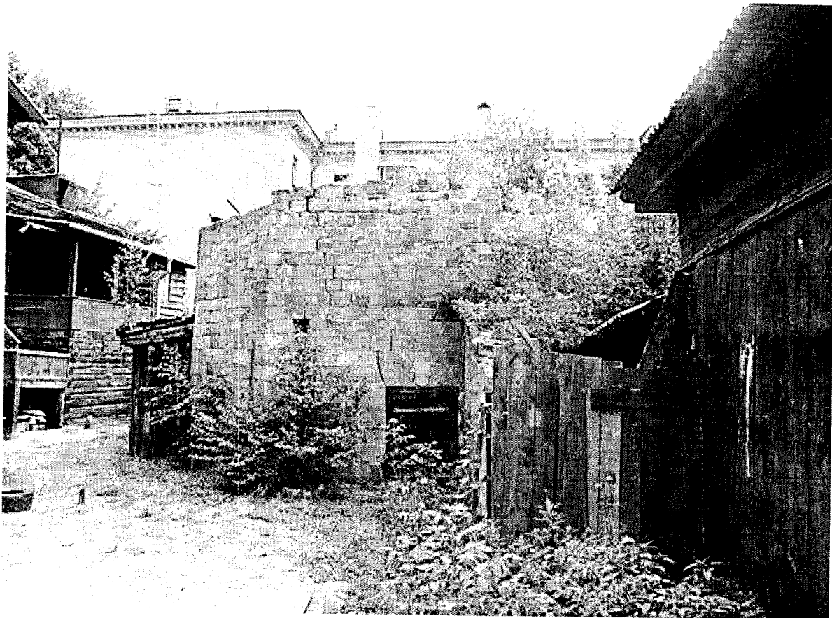
Фото 11 - Боковой (юго-западный) фасад амбара (выезда). Вход в подвальное помещение
