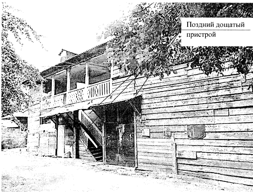
Фото 14 - Фрагмент продольного, дворового (северо-восточного) фасада жилого дома (лит. А)
