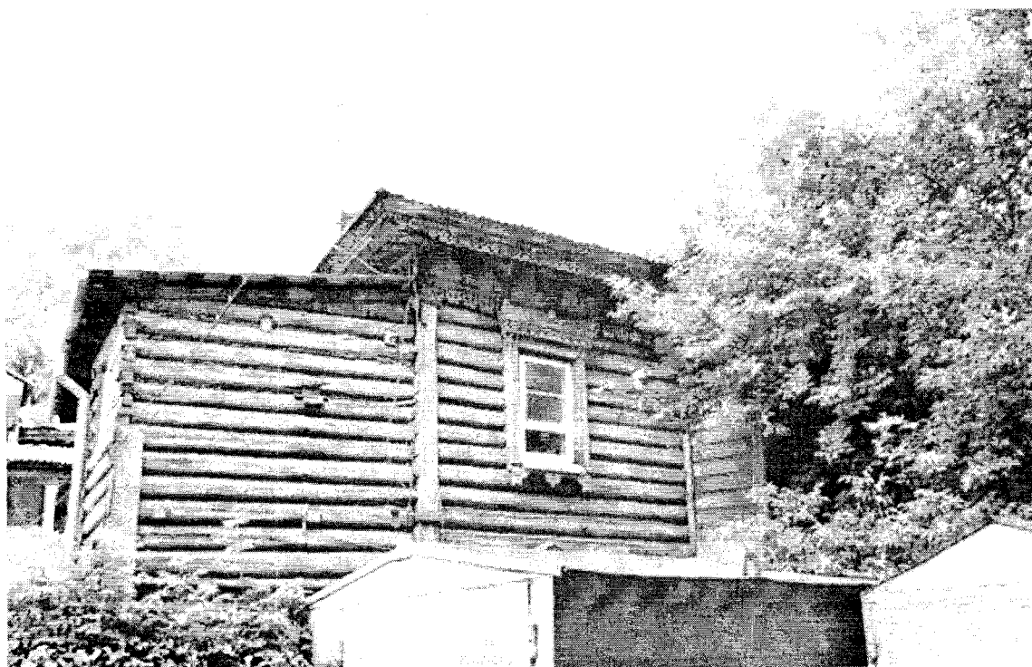
Фото 12. Фрагменты продольных северо-восточных фасадов основного объема и пониженного прируба туалета со стороны торцового фасада
