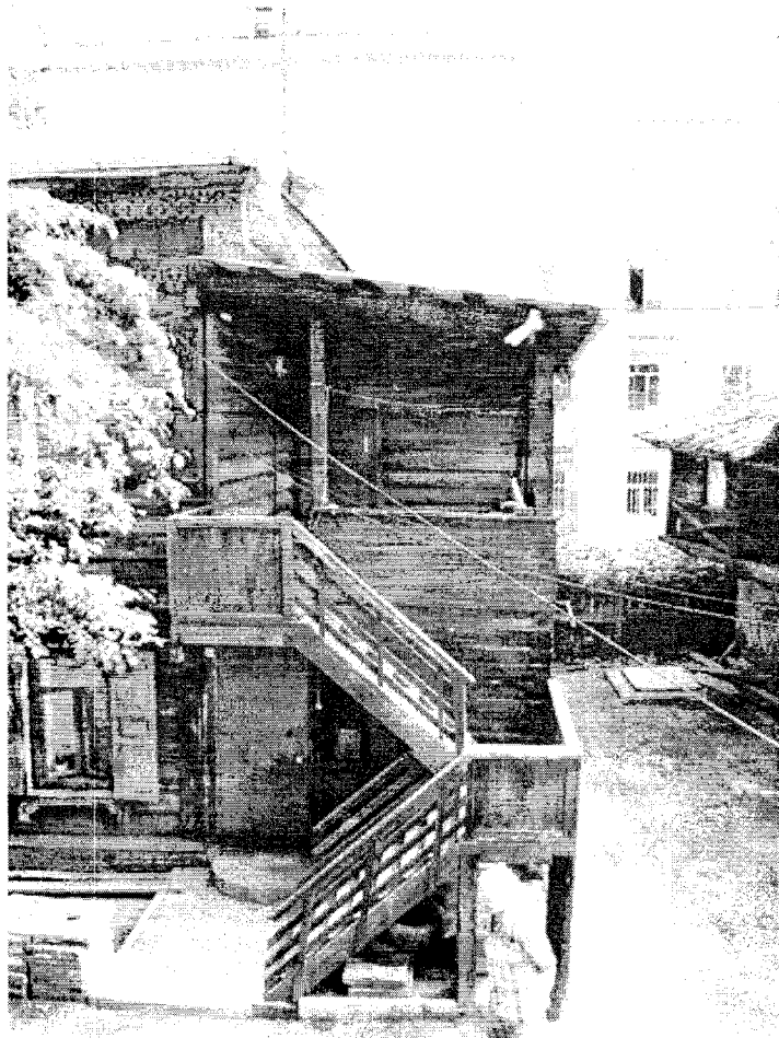
Фото 9 - Торцевой юго-восточный фасад. Перестроенная открытая лестница и поздний пристрой к прирубу туалета
