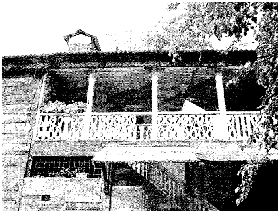
Фото 17 - Фрагмент продольного, дворового (северо-восточного) фасада открытой галереи. Балкон открытой галереи. Поздний входной пристрой под лестницей под навесом
