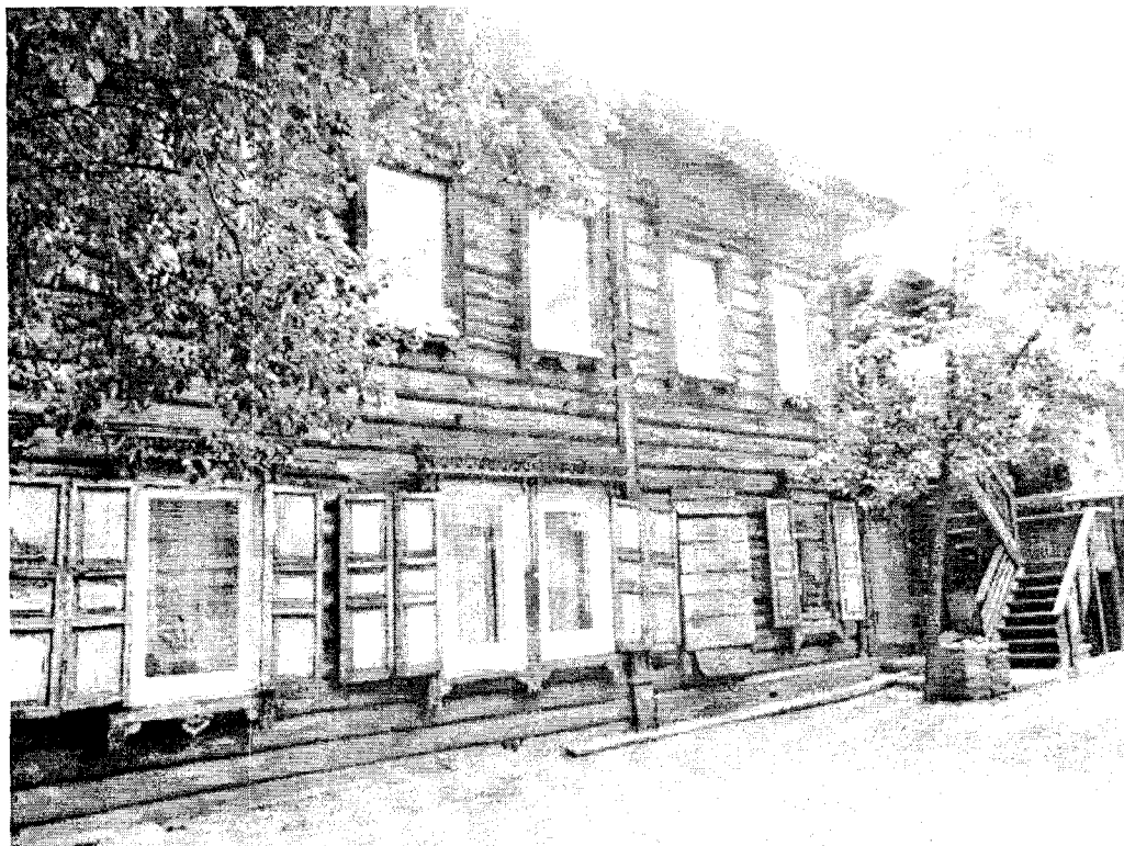
Фото 8 - Продольный юго-западный фасад. Перестроенная открытая лестница со стороны дворового торцевого фасада
