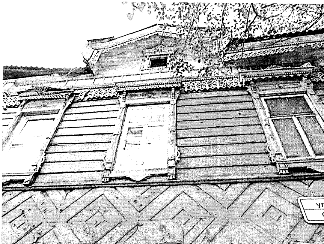
Фото 3 - Фрагмент торцевого (северо-западного) фасада жилого дома (лит. А). Щипцовый на плечиках фронтон по центральной оси фасада
