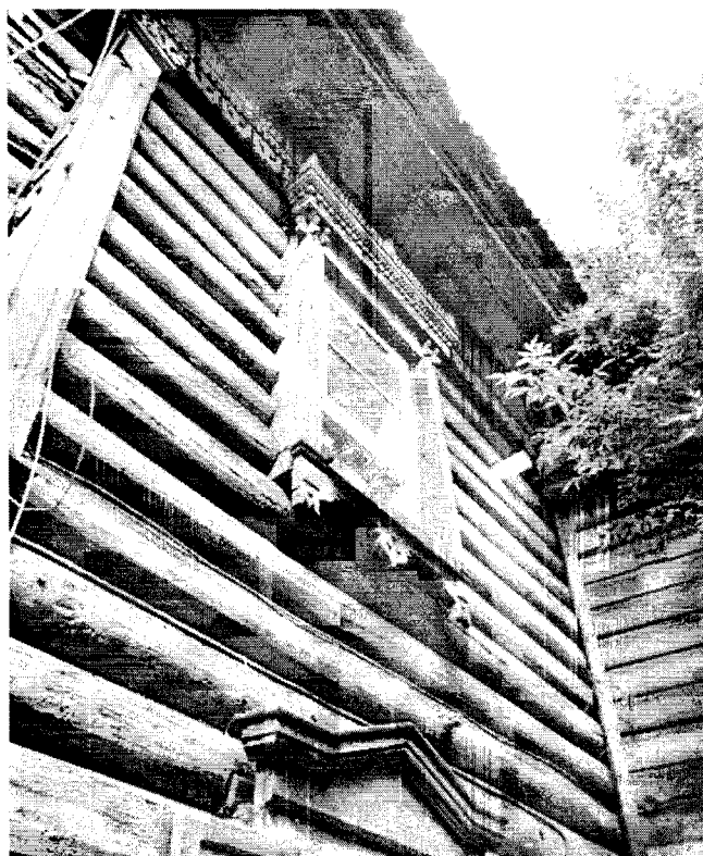
Фото 14 - Фрагмент продольного северо-восточного фасада основного объема. Наличник оконного проема 2-го этажа. Лопатка
