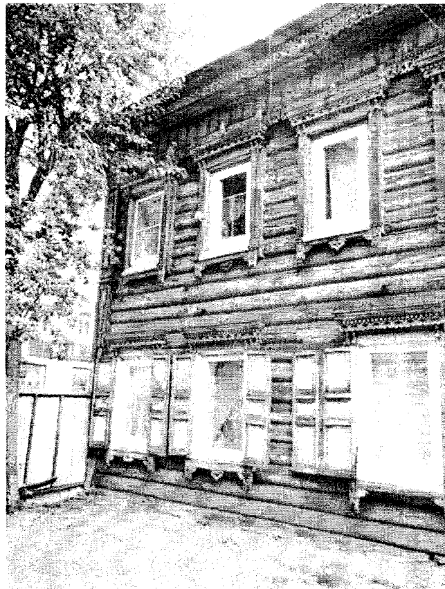
Фото 7 - Фрагмент продольного юго-западного фасада. Фриз, карниз, наличники оконных проемов
