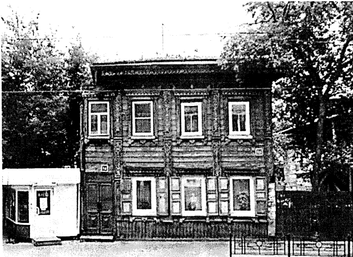
Фото 2 - Жилой дом (лит. Б.), главный торцевой фасад
