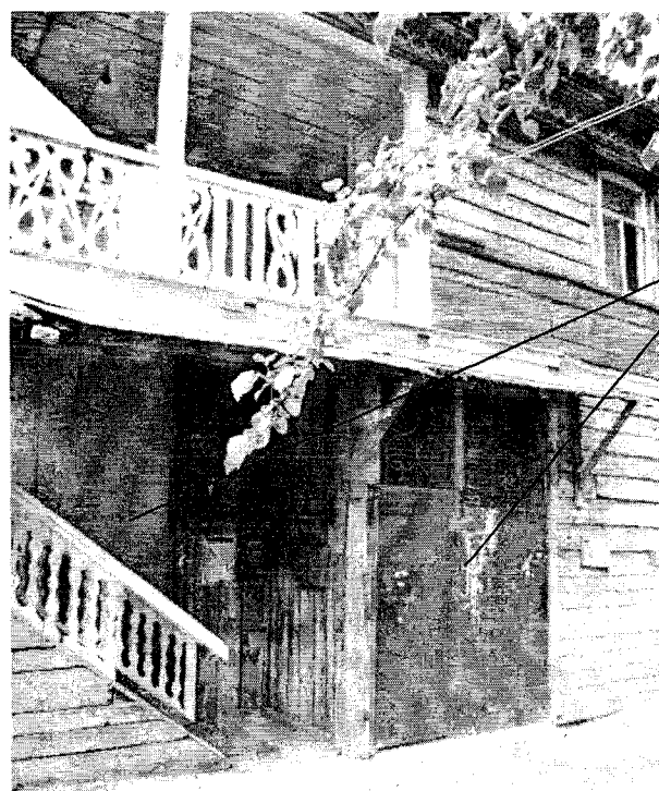
Фото 18. Фрагмент продольного, дворового (северо-восточного) фасада прируба сений. Поздний дощатый пристрой входа в открытой галерее в уровне 1-го этажа
