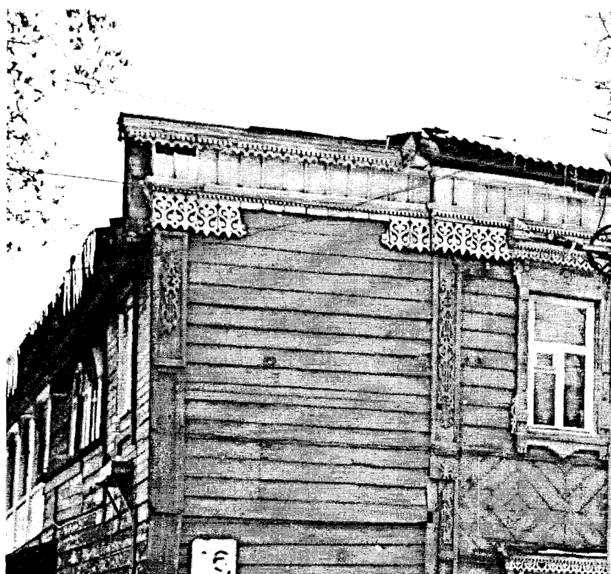
Фото 4 - Фрагмент торцевого (северо-западного) фасада жилого дома (лит. А). Огибающие лопатки, фриз, карниз
