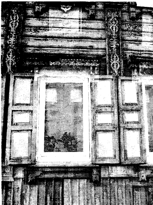
Фото 5 - Фрагмент главного, торцевого фасада. Наличник оконного проема 1-го этажа
