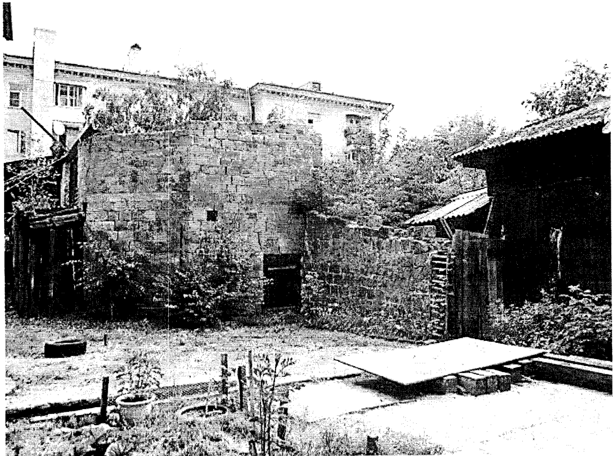
Фото 16 - Элементы усадьбы: фрагмент брандмауэрной стены, расположенной по юго-восточной меже усадьбы
