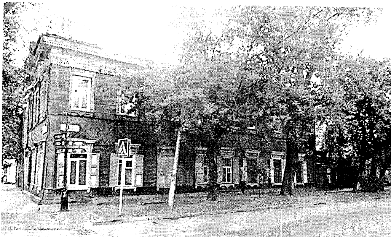
Фото 9 - Продольный (юго-западный) фасад жилого дома (лит. А), вид по ул. Марата
