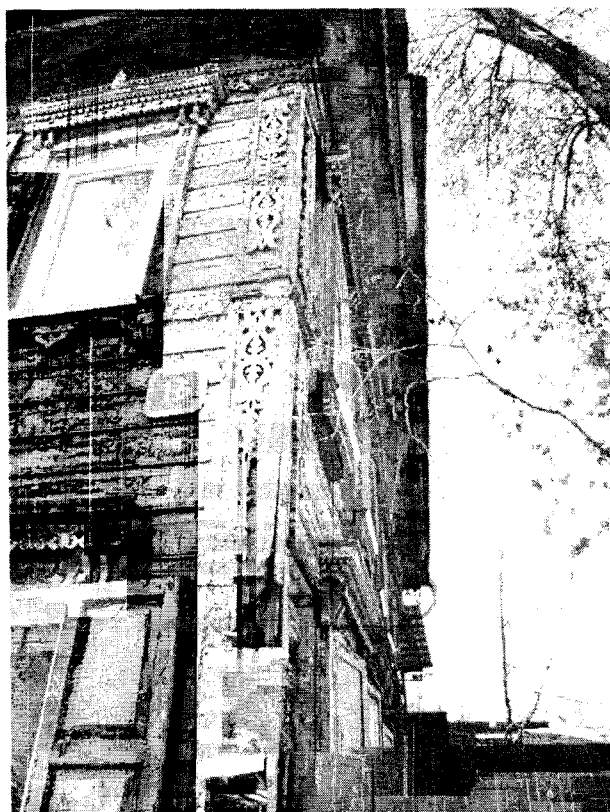
Фото 6 - Фрагмент главного, торцевого фасада. Лопатка, декорированная пропиленным декором
