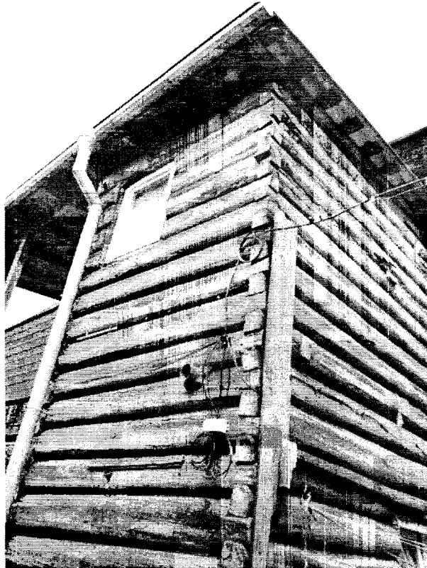
Фото 16 - Прируб туалета. Фрагменты северо-восточного и юго-восточного фасадов, 2-ой этаж
