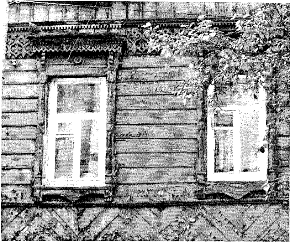
Фото 5 - Фрагмент торцевого (северо-западного) фасада жилого дома (лит. А). Оконный проем 2-го этажа (архив ЦСН, 2011 г.)
