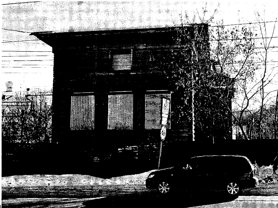
Главный (северо-западный) фасад.
