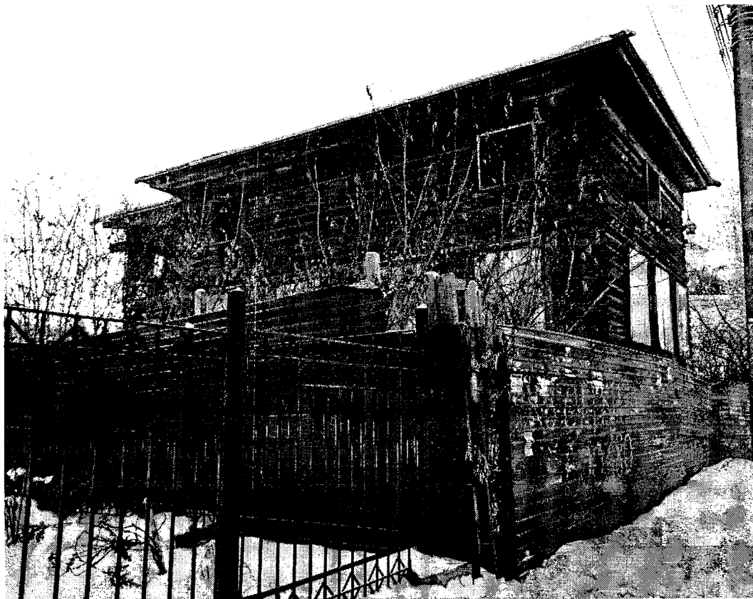
Боковой (северо-восточный) фасад.
