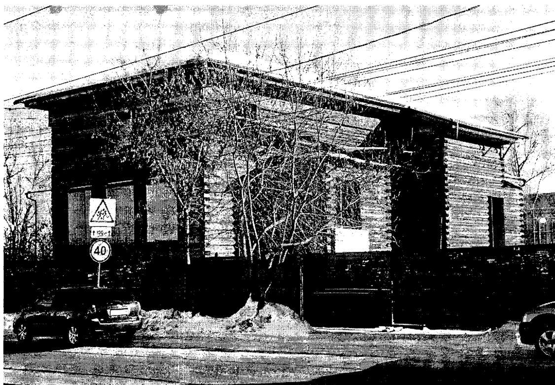
Общий вид здания с ул.Тимирязева.
