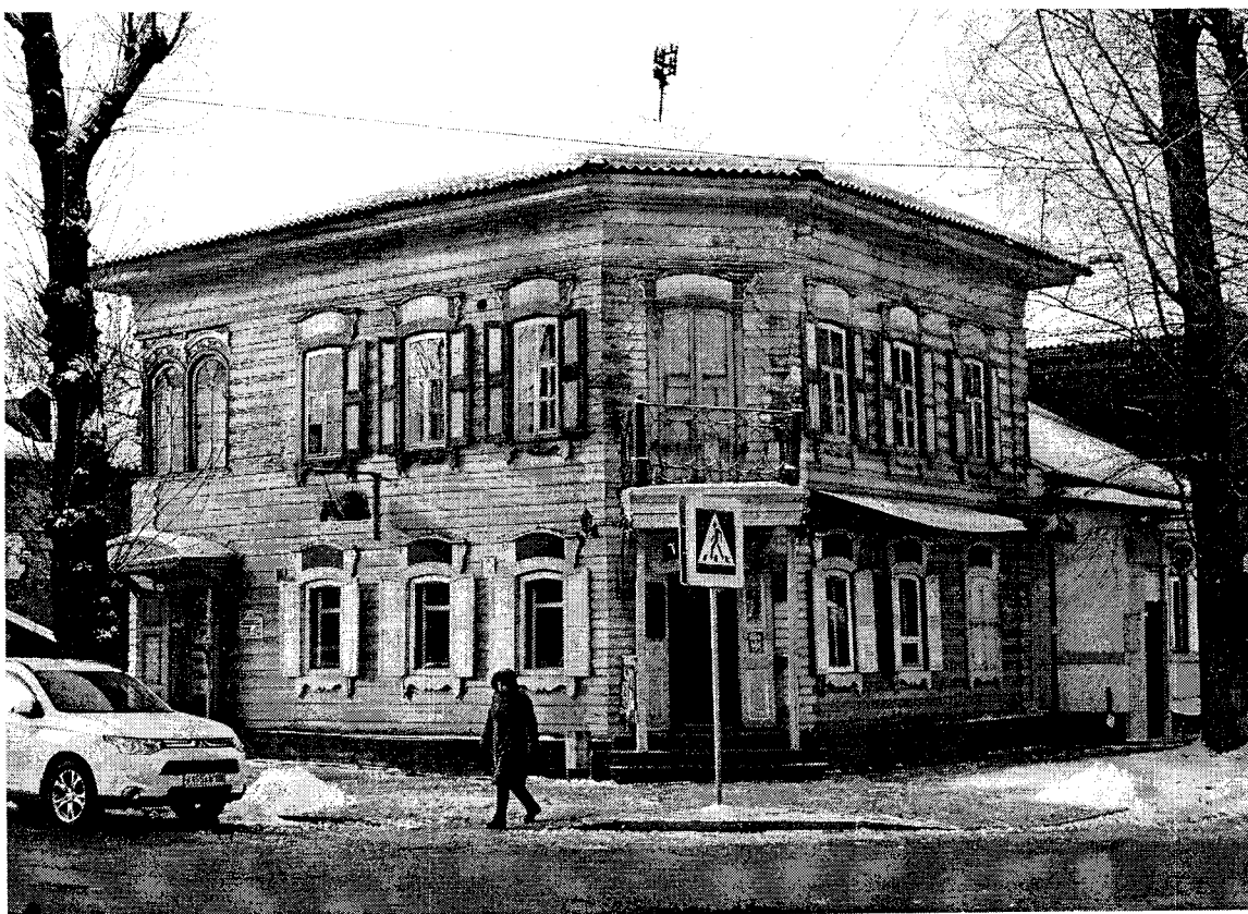
Общий вид здания с перекрестка ул. Грязнова и ул. Дзержинского.
