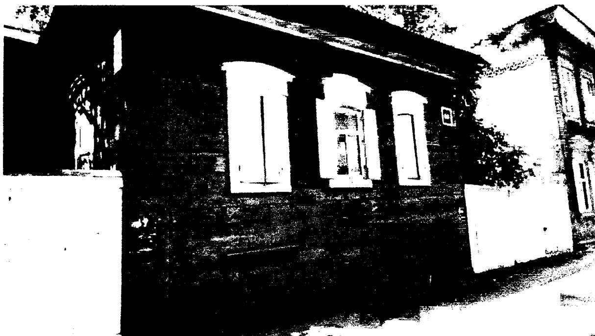
Фото 3 - Северо-восточный фасад главного дома (лит. А)
