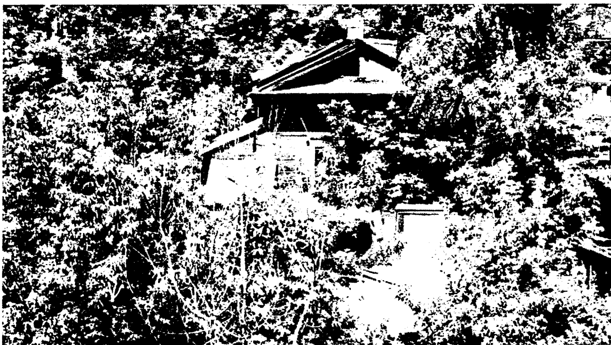
Фото 4 - Юго-восточный фасад здания лит. А. Пристрои лит. а, а1
