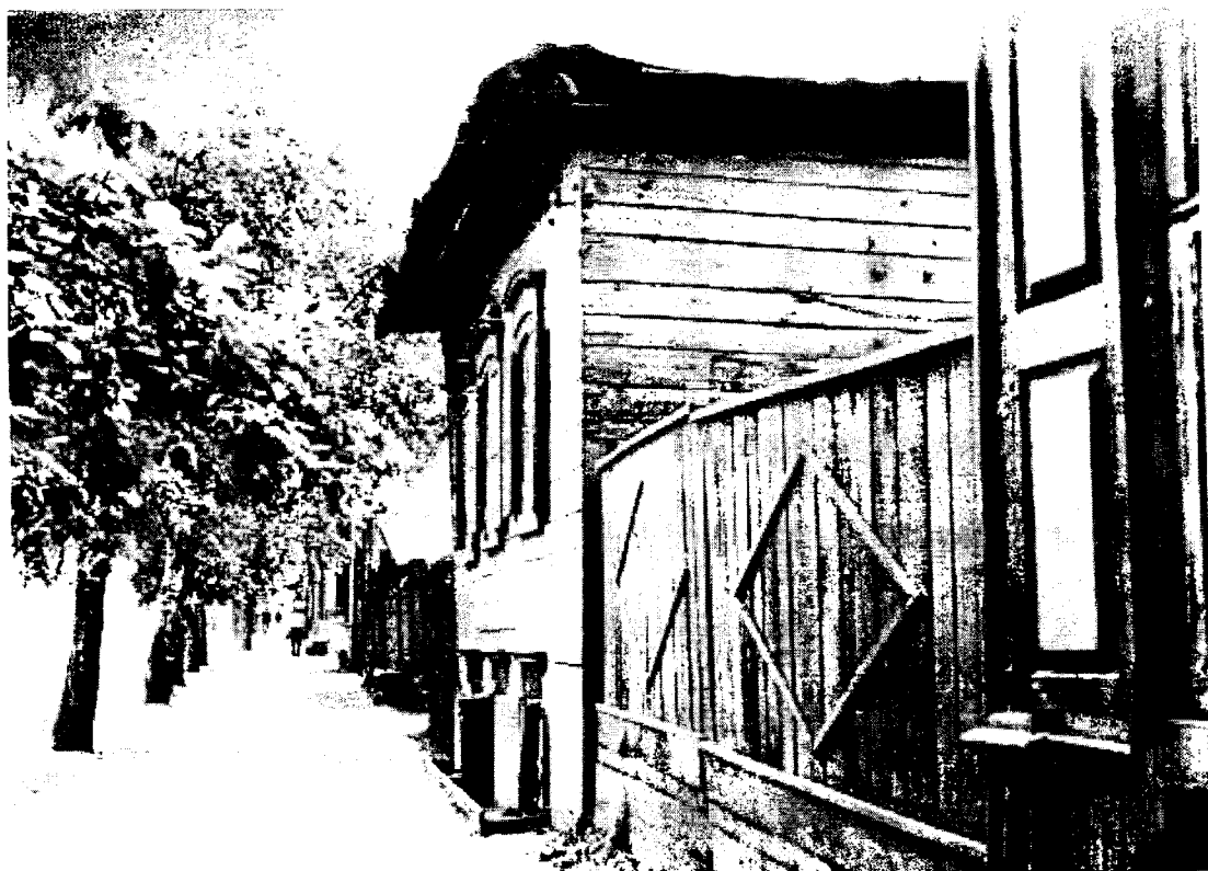
Фото IV - Главный фасад дома лит. А, вид по ул. Декабрьских Событий, с северо-запада
