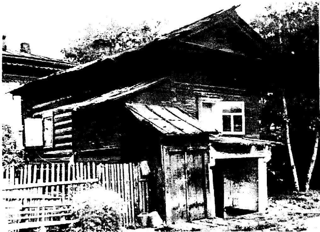
Фото V - Вид на дом со двора, южный угол здания. Пристрои лит. а, а1
