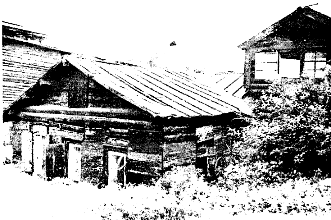
Фото VIII - Юго-западный фасад строения лит. Б. На переднем плане – прачечная . Справа на заднем плане – строение амбара
