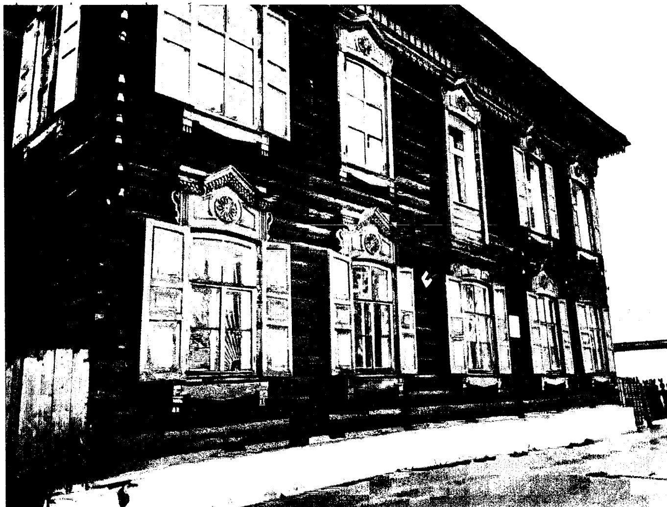
Фото 1. Главный (северный) фасад по адресу: г. Киренск, ул. Ленских Рабочих, 30.
