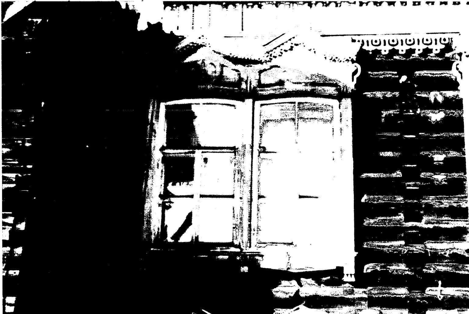
Фото 6. Сдвоенное окно со сдвоенным наличником, со стороны дворового (южного) фасада по адресу: г. Киренск, ул. Ленских Рабочих, 30
