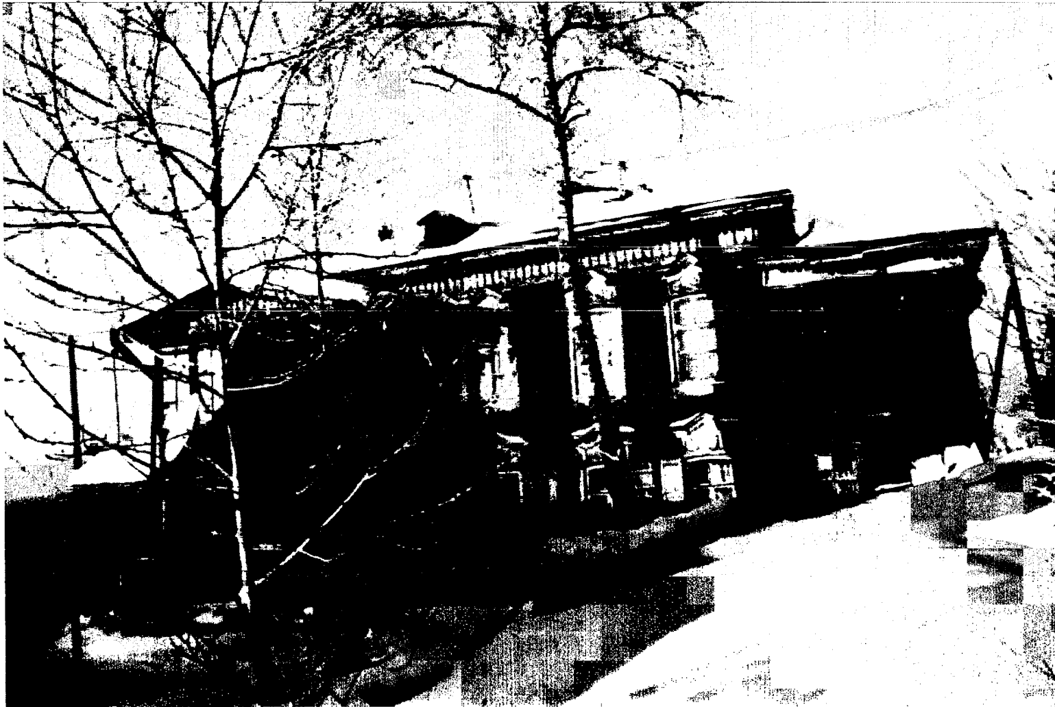
Фото 5. Дворовый (южный) фасад с пристроем со стороны восточного фасада по адресу: г. Киренск, ул. Ленских Рабочих, 30.
