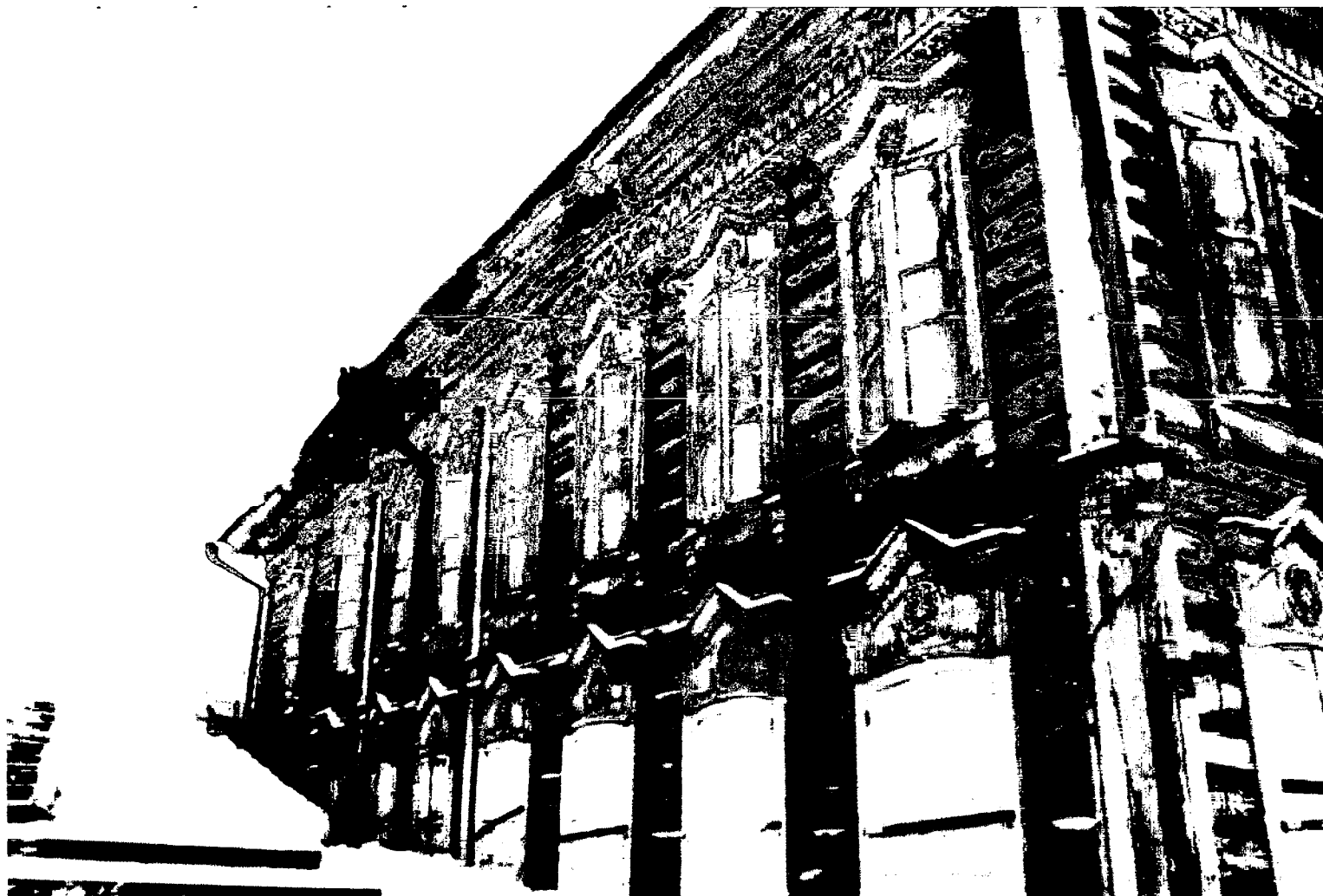
Фото 11. Боковой (восточный) фасад по адресу: г. Киренск, ул. Ленских Рабочих,31.
