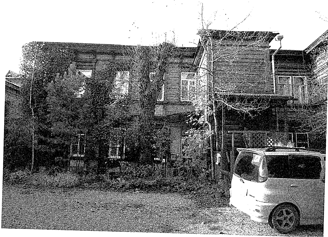
Дворовой северо-восточный фасад.
