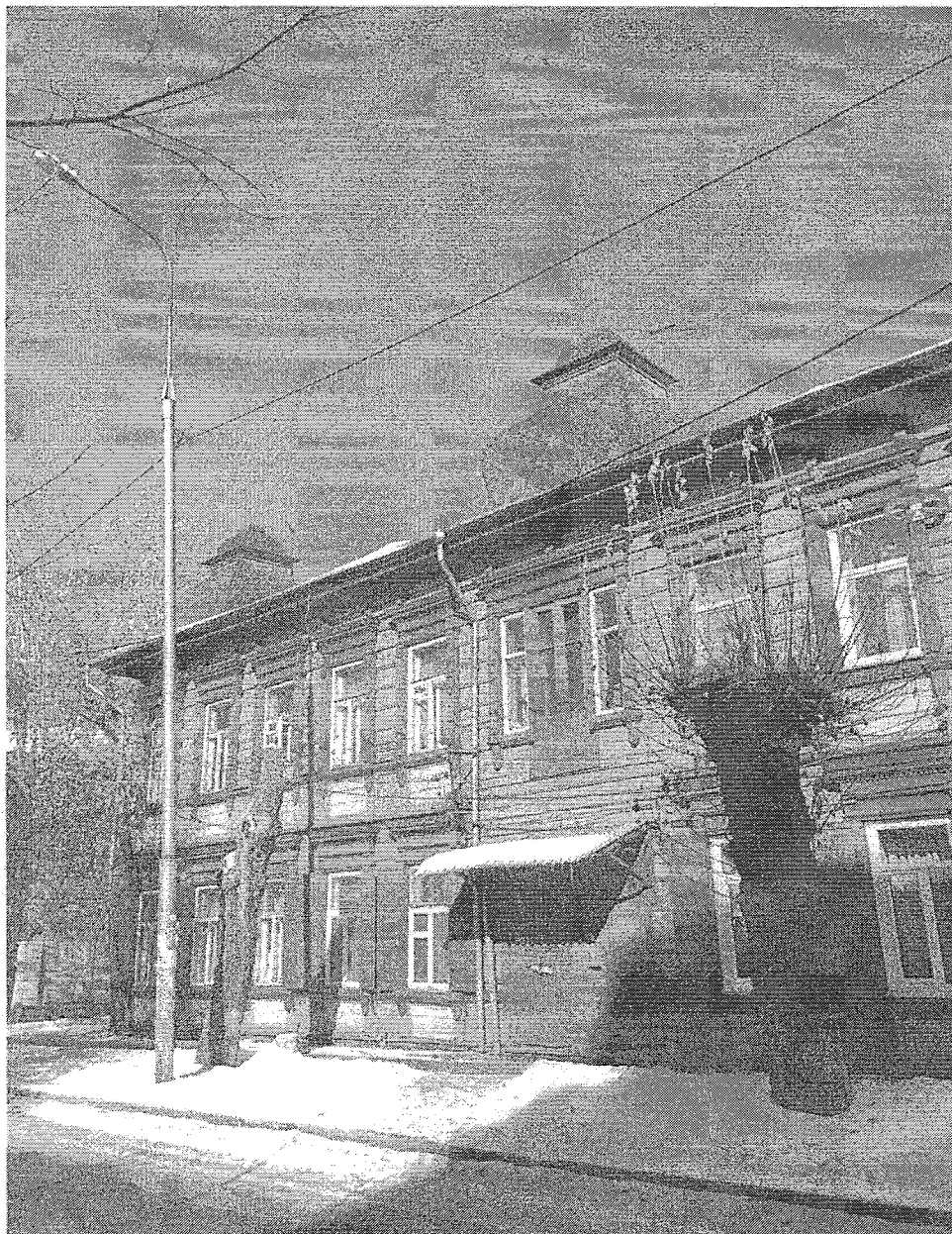
Фото 1. Главный юго-западный фасад лит. А
