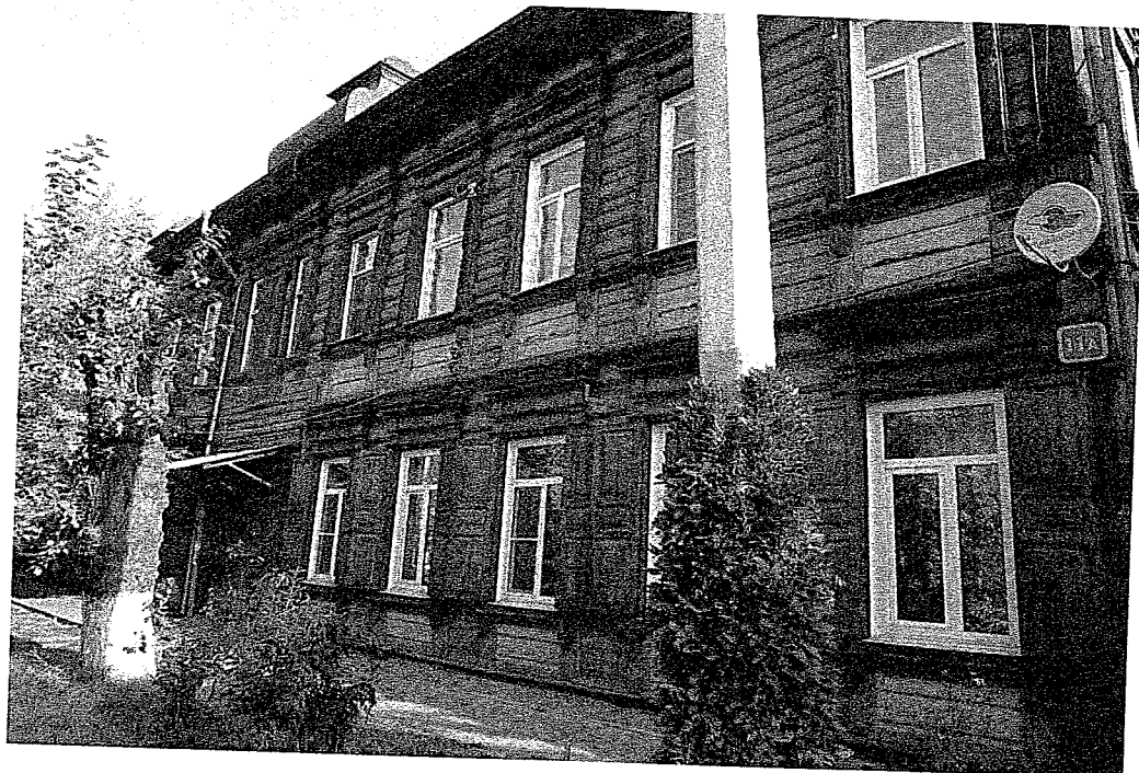
Главный юго-западный фасад.
