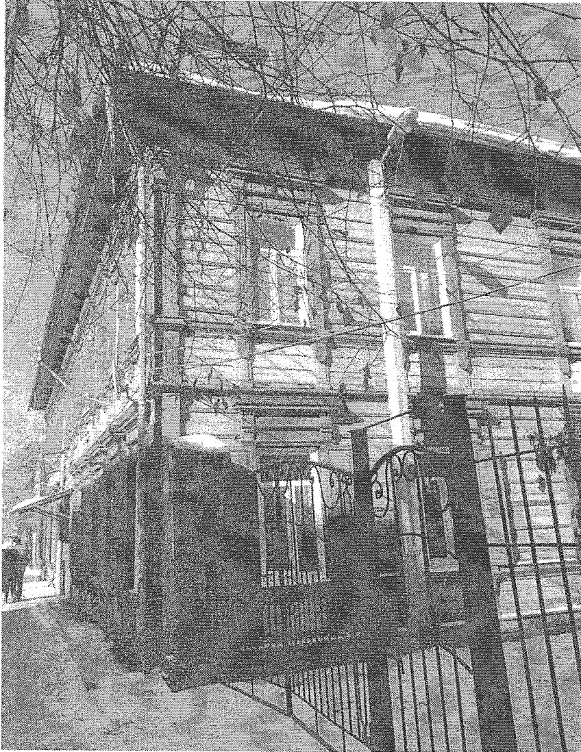
Фото 8. Торцевой юго-восточный фасад лит. А
