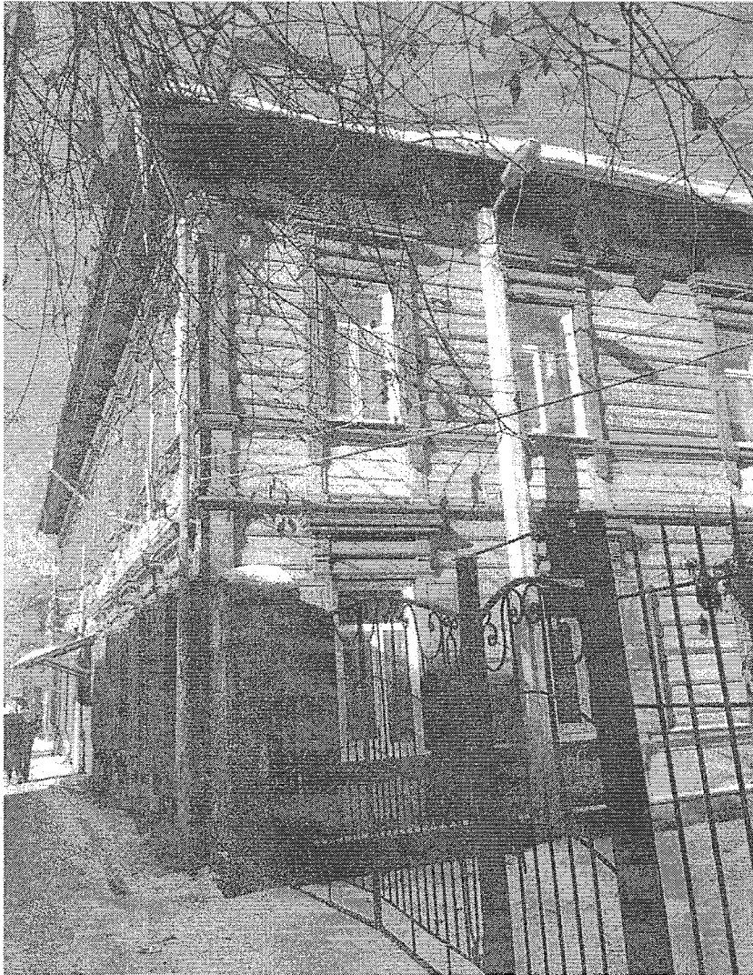
Фото 8. Торцевой юго-восточный фасад лит. А
