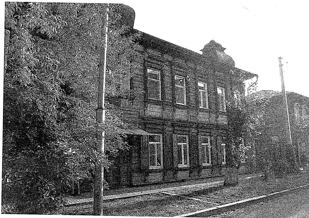
Главный юго-западный фасад.
