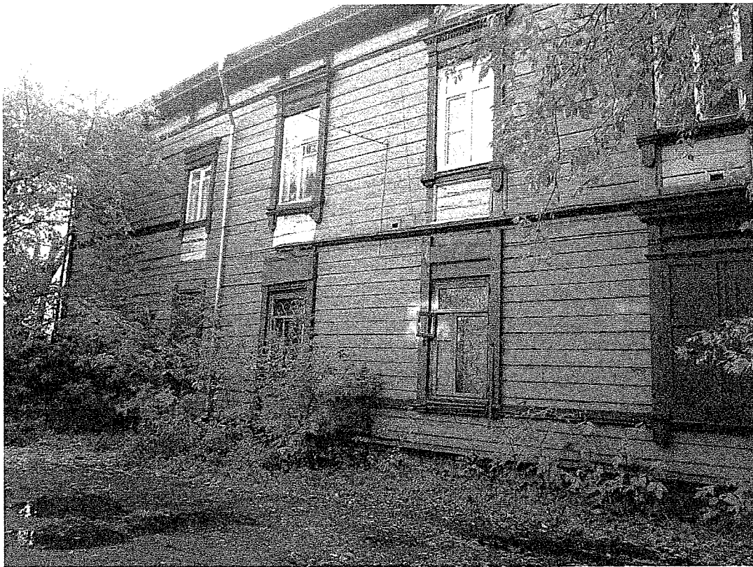
Фрагмент бокового северо-западного фасада.
