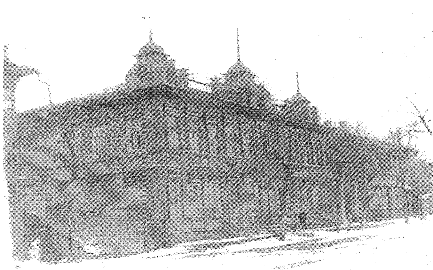
Фото 2. Архивное фото. Главный юго-западный фасад лит. А
