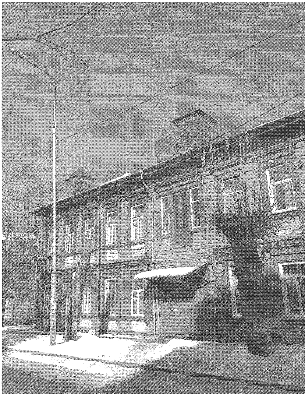
Фото 1. Главный юго-западный фасад лит. А
