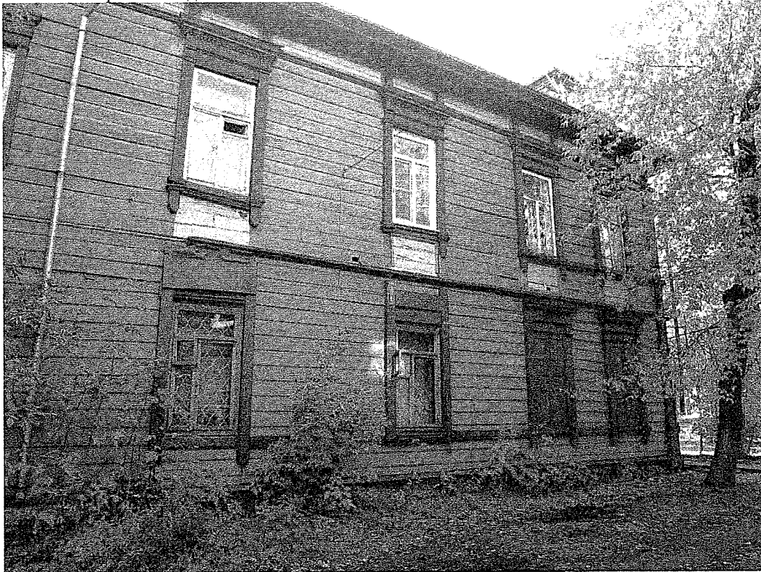
Фрагмент бокового северо-западного фасада.
