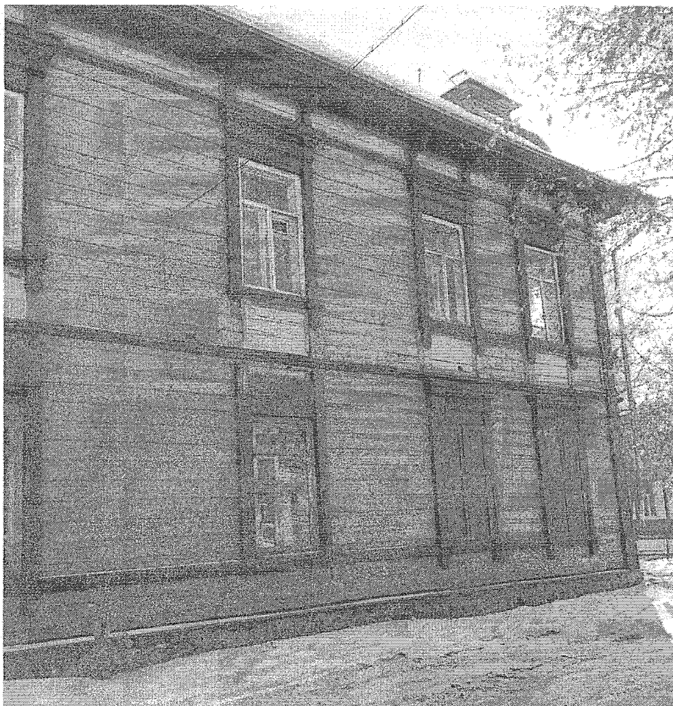
Фото 10. Торцевой северо-западный фасад лит. А
