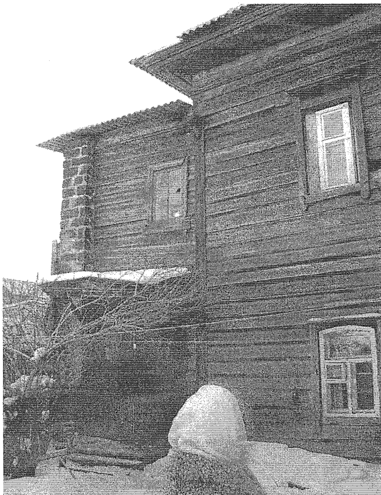
Фото 14. Дворовой фасад лит. Б
