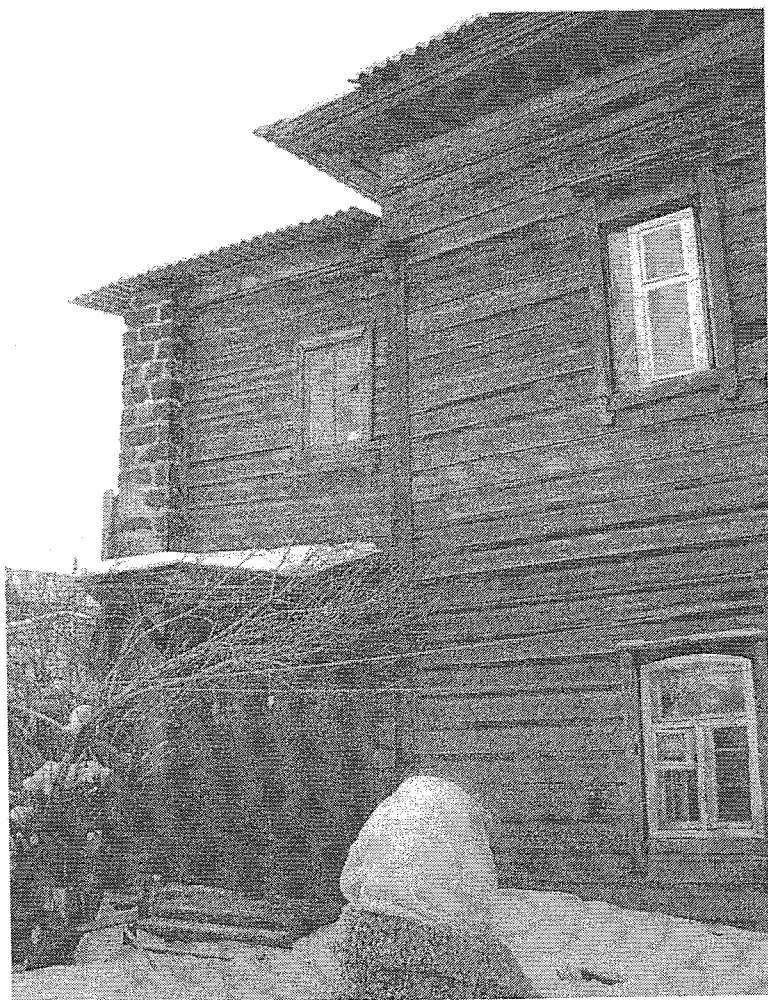
Фото 14. Дворовой фасад лит. Б
