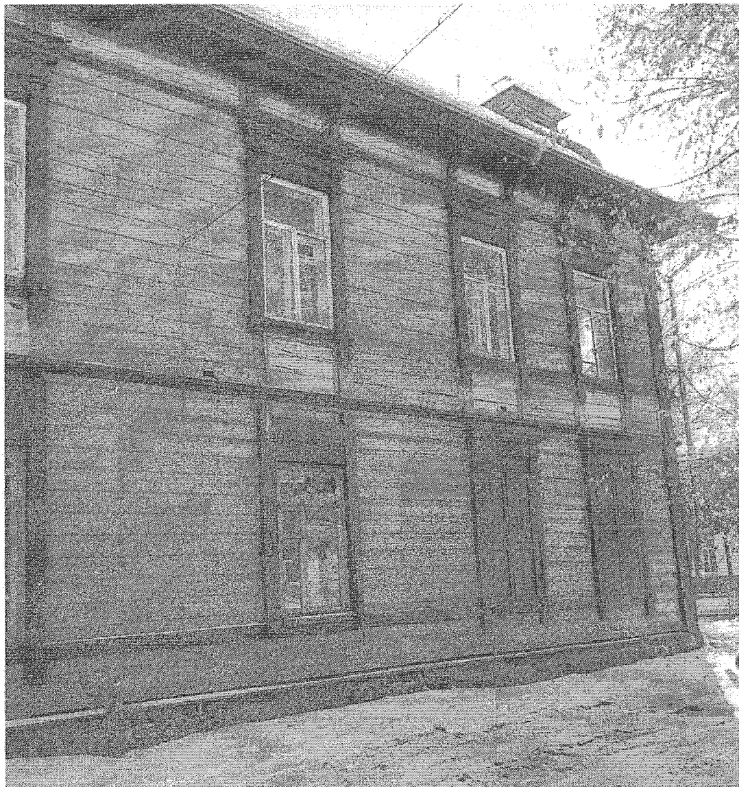
Фото 10. Торцевой северо-западный фасад лит. А
