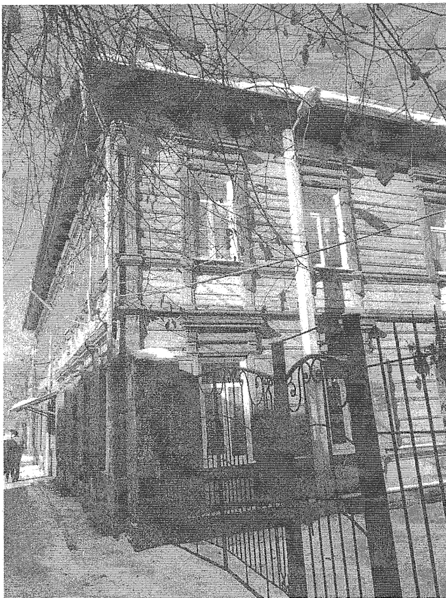
Фото 8. Торцевой юго-восточный фасад лит. А
