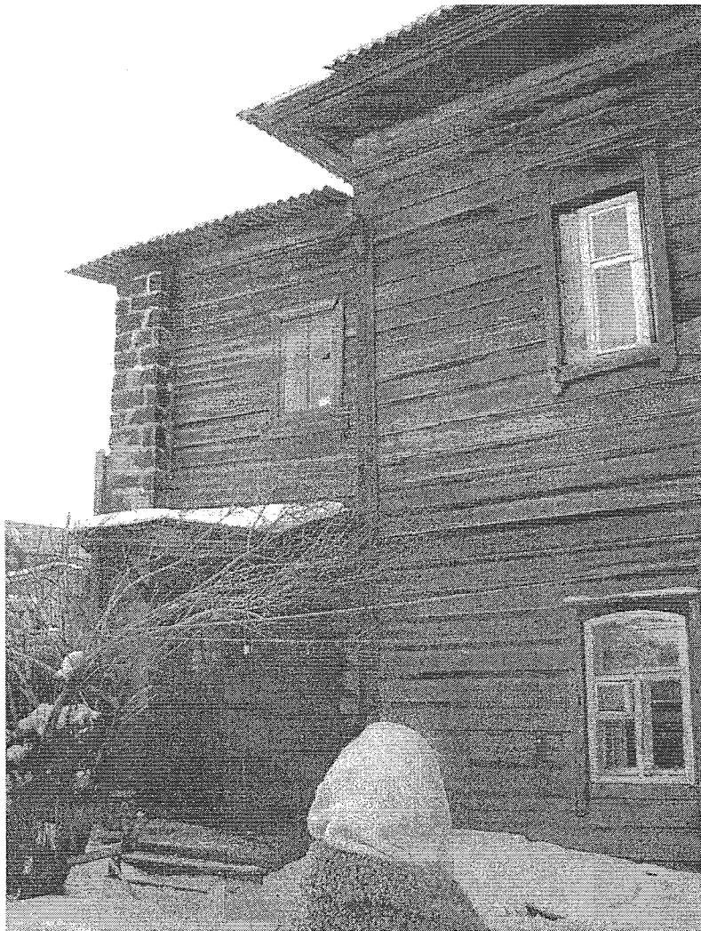
Фото 14. Дворовой фасад лит. Б
