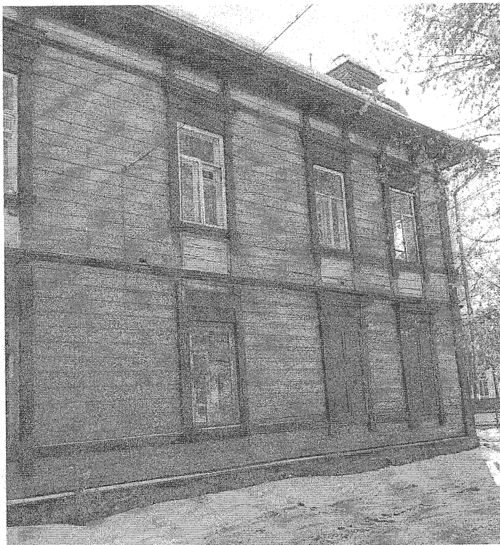
Фото 10. Торцевой северо-западный фасад лит. А
