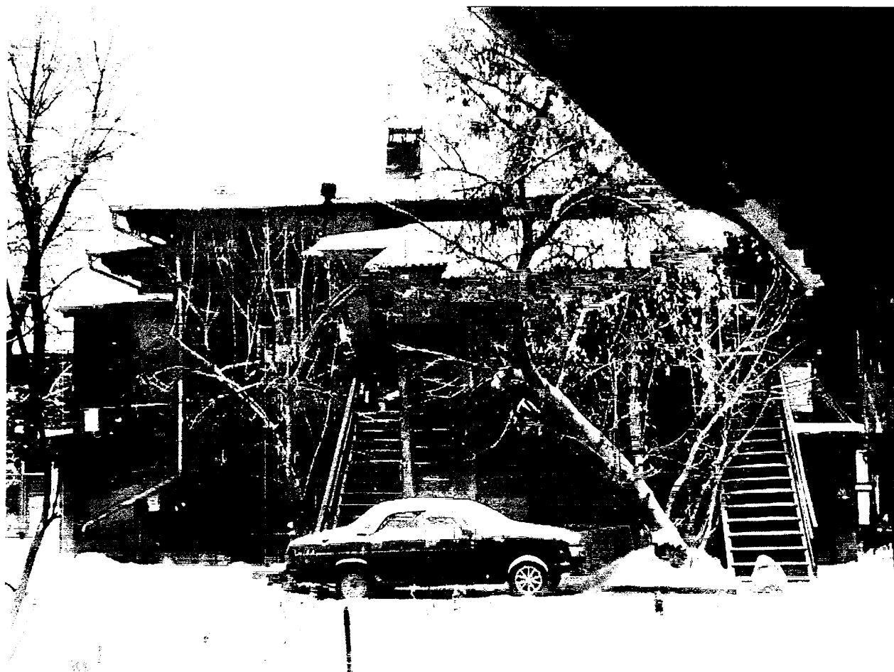
Фото 6 - Дворовый (юго-восточный) фасад
