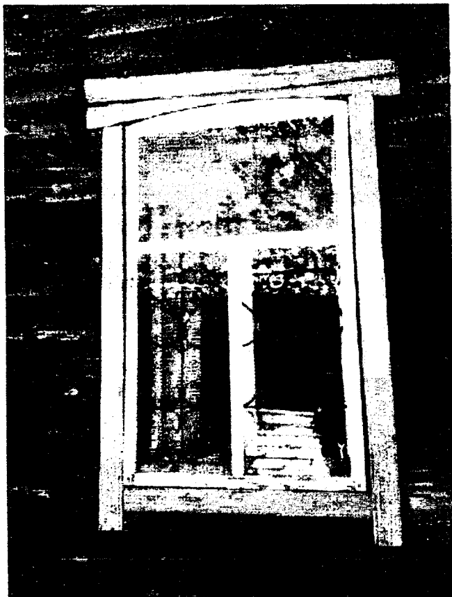
11. Вид на фрагмент юго-западного фасада здания. Окно.
