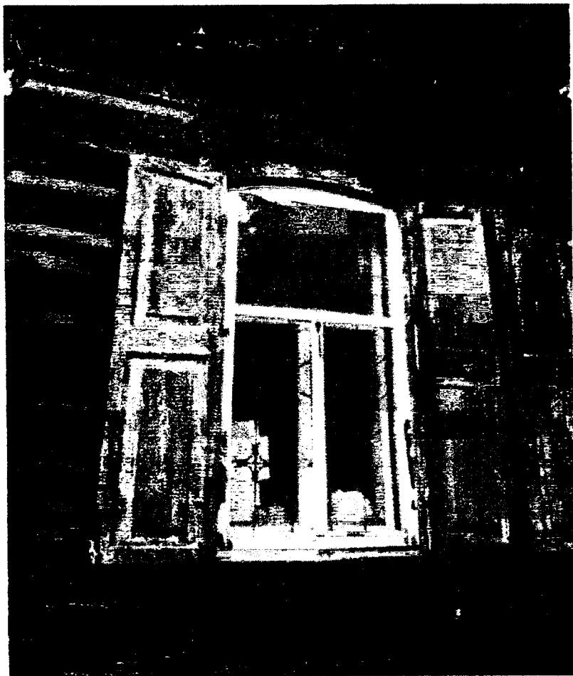
2.Фрагмент юго-восточного фасада. Окно, обшивка.
