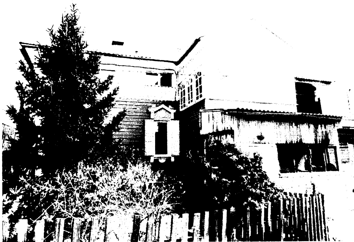
Фото 7 - Вид со двора на юго-западный фасад
