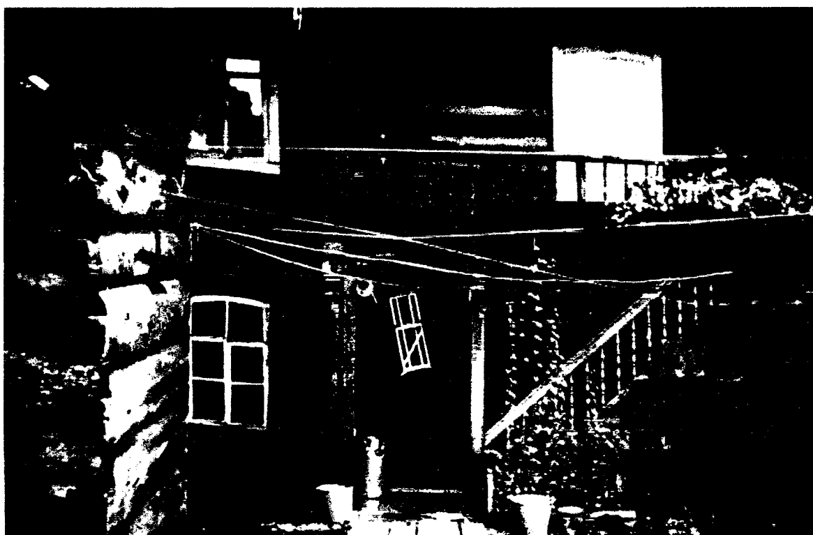
Фото 8. Фрагмент юго-восточного (дворового) фасада. Г-образный дворовой прируб с галереей. Слева – утраченный прируб люфт-клозета. Фото В.Т. Щербина, 1980-е гг. Архив Службы по охране ОКН Иркутской области
