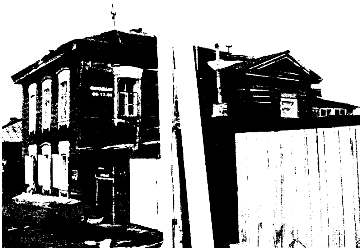
Фото 4. Общий вид здания с юга. Фото 2019 г.
