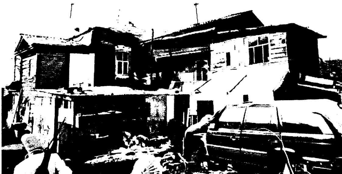
Фото 10. Общий вид с востока. Фото 2019 г.
