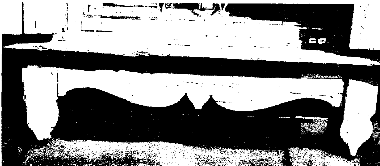
Фото 16. Фрагмент оконного наличника 1-го этажа. Фигурный фартук. Фото 2019 г.
