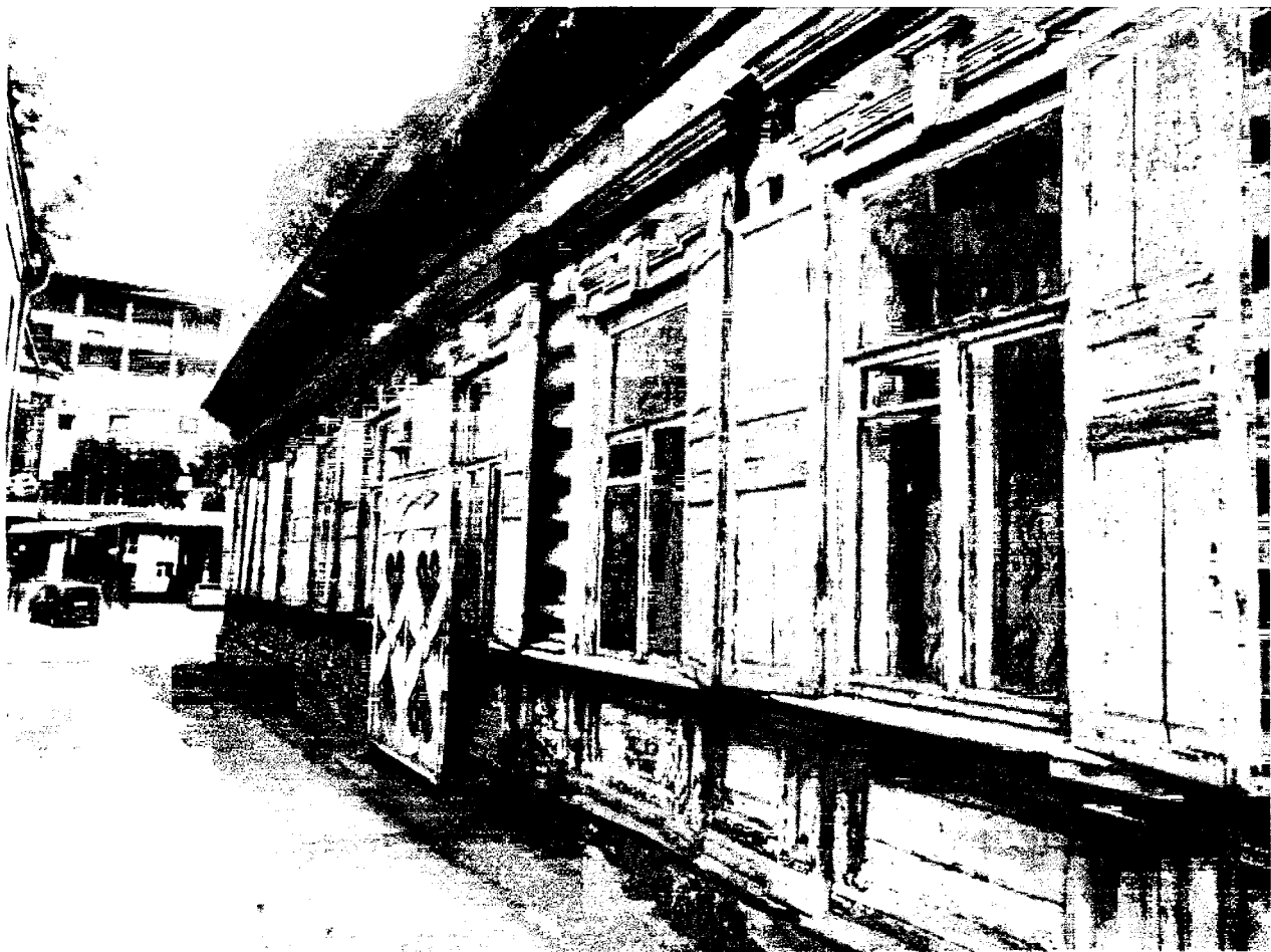
Фото 7 - Вид на боковой (северо-западный) фасад со двора
