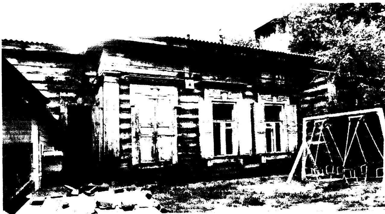
Фото 4 - Вид на боковой (юго-восточный) фасад со стороны двора
