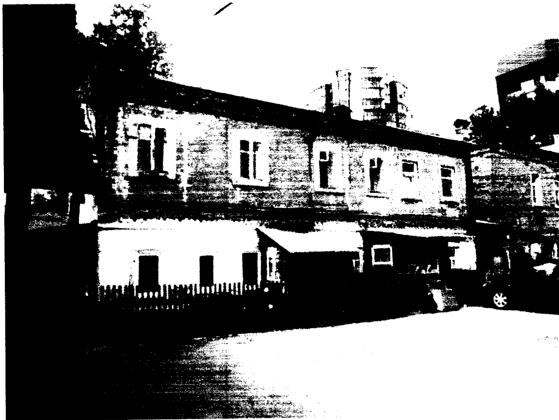
Фото 6 - Вид на боковой (юго-восточный) правого и левого пристроев
