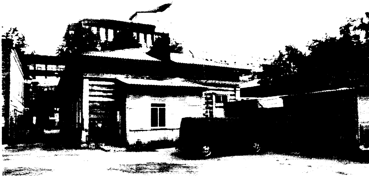
Фото 5 - Дворовый (юго-западный) фасад с поздним входным пристроем
