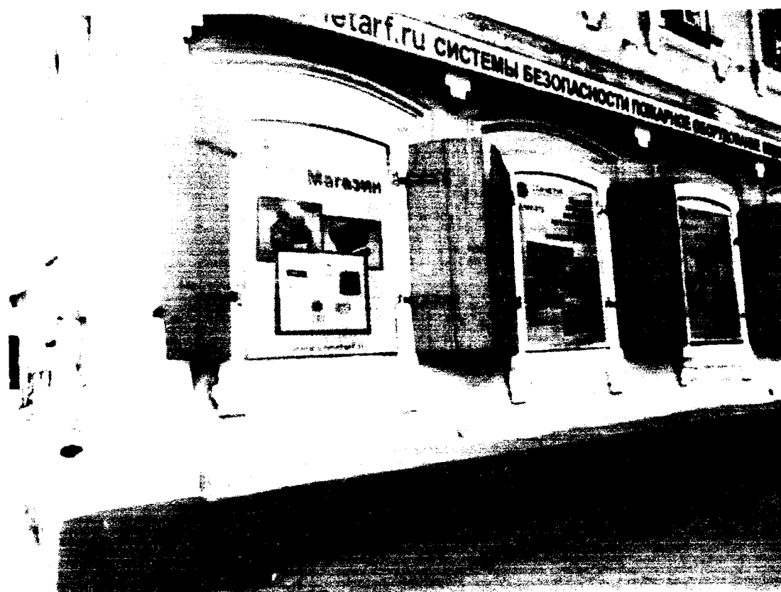
Фото 14 - Наличники окон со стороны главного (северо-восточного) фасада основного объема
