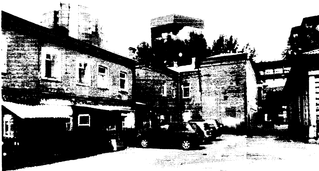
Фото 7 - Вид на боковой (юго-восточный) правого и левого пристроев, дворовый (юго-западный) фасад основного объема
