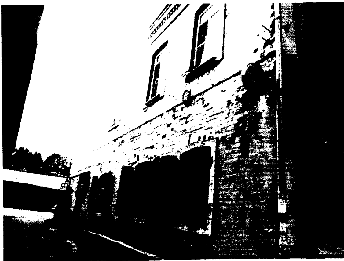
Фото 4 - Вид на боковой (юго-восточный) фасад основного объема
