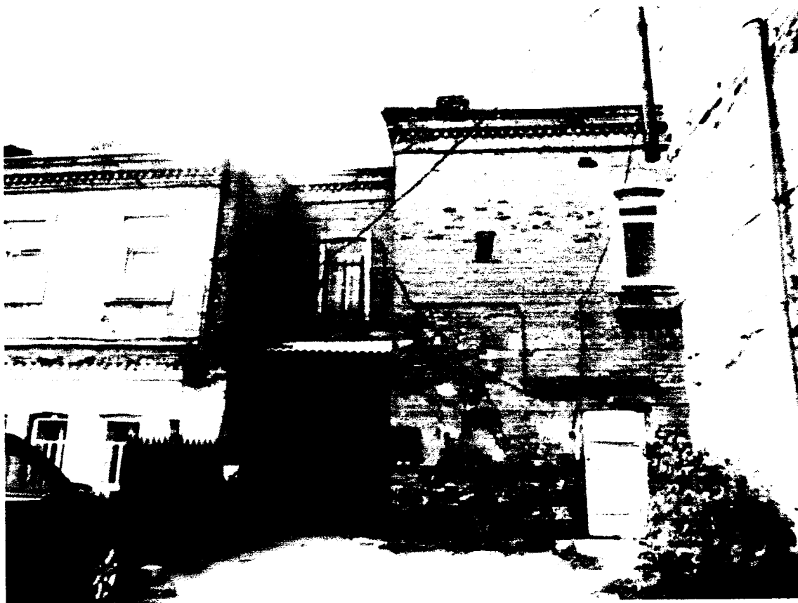
Фото 5 - Вид на боковой (юго-восточный) правого и левого пристроев
