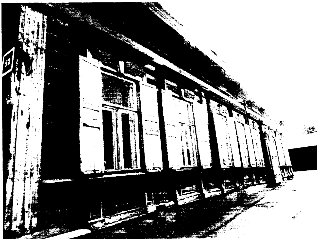
Фото 6 - Вид на боковой (северо-западный) фасад с улицы
