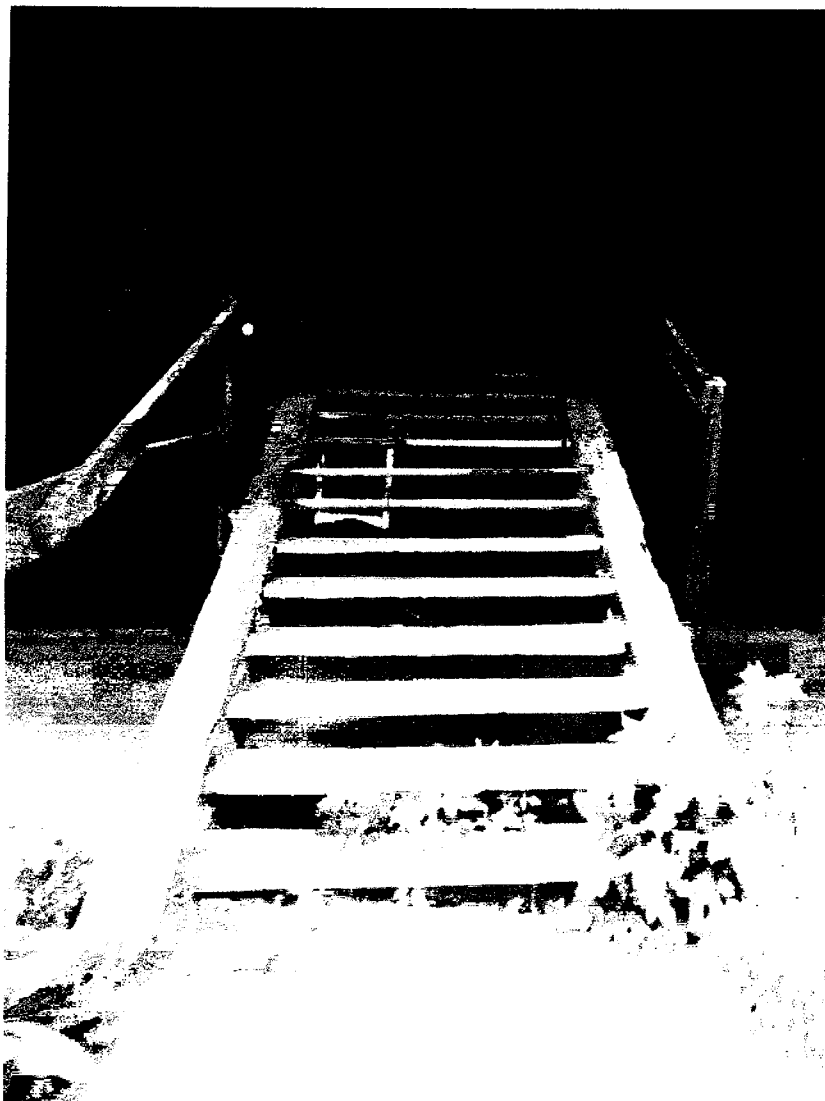
Фото 11 - Деревянная лестница, ведущая на галерею второго этажа
