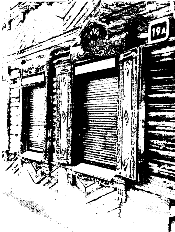
Фото 8 - Наличник окна первого этажа со стороны главного (юго-западного) фасада
