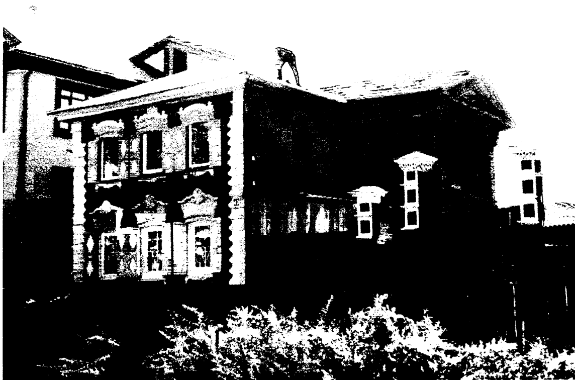
Фото 1 - Общий вид здания с северного угла
