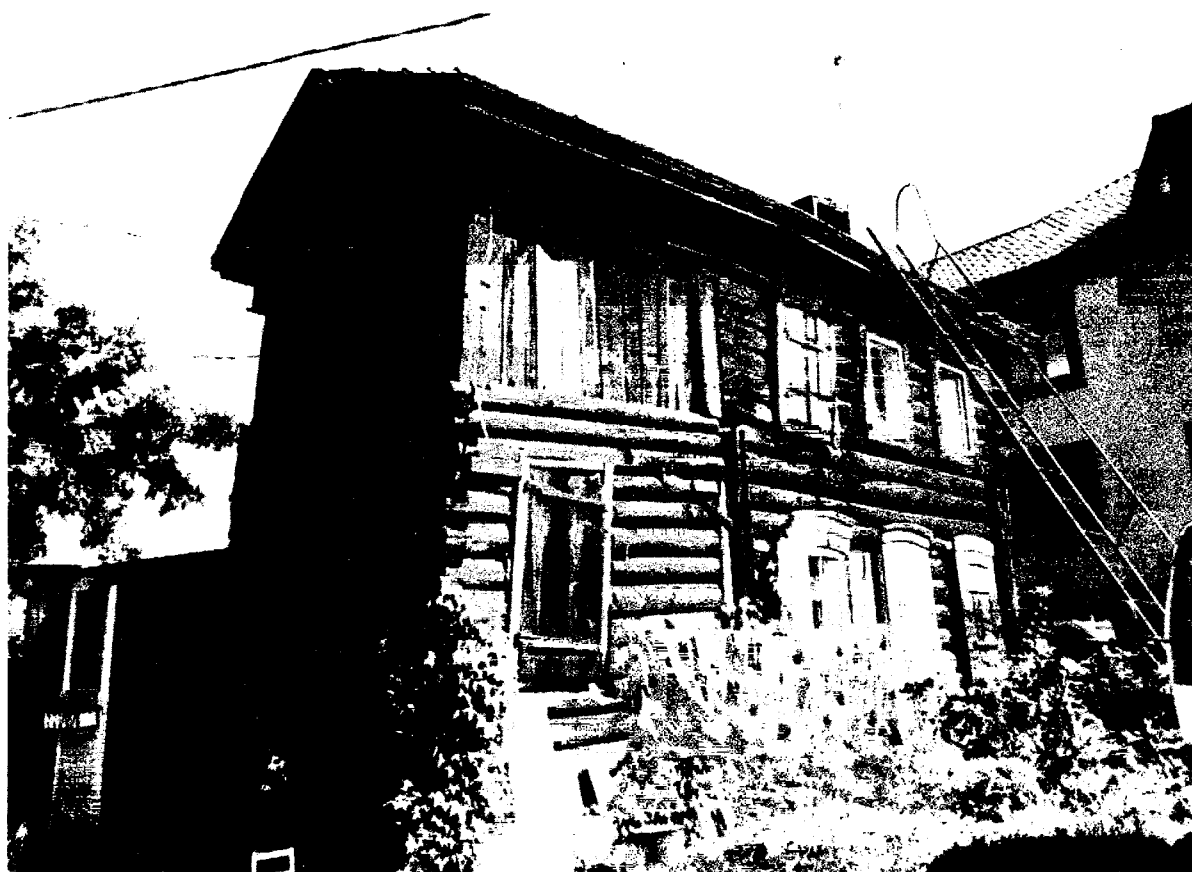
Фото 6 - Вид дома с западного угла. Юго-западный фасад
