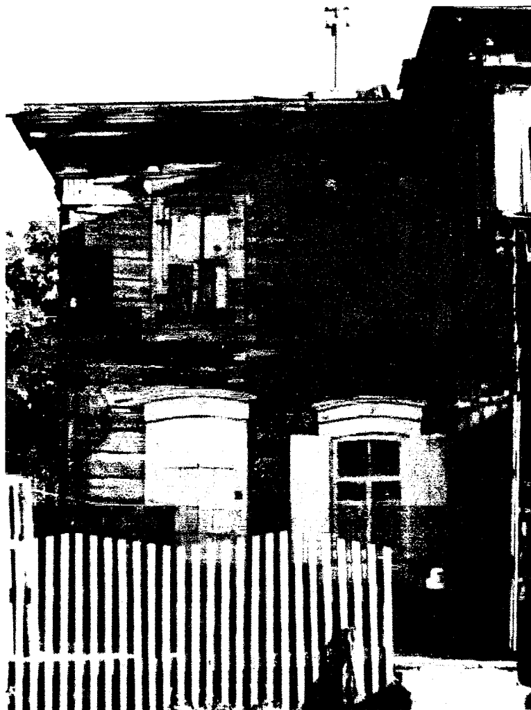
Фото 13 - Фрагмент северо-западного фасада (архив Службы)
