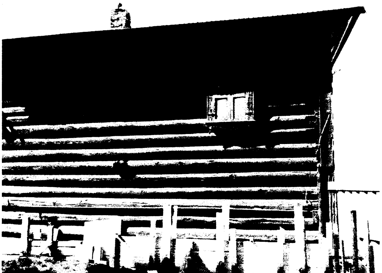
Фото 10 - Фрагмент юго-восточного фасада с прилегающей территории
