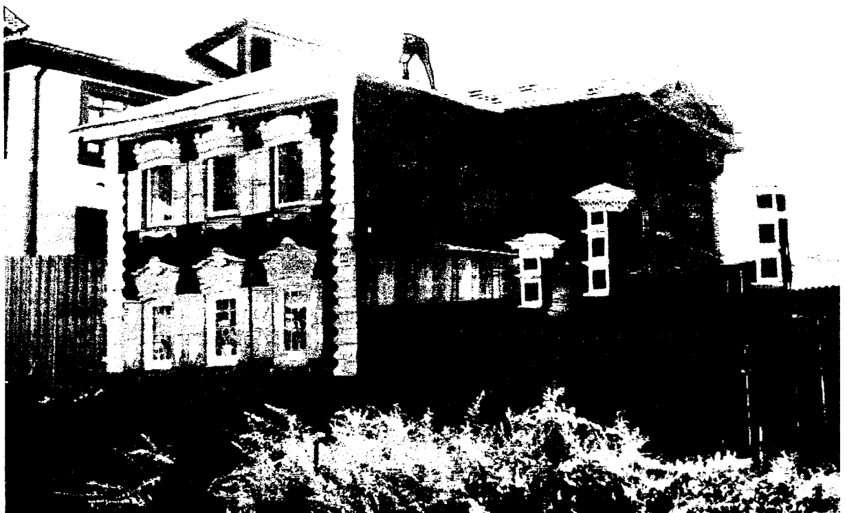
Фото 2 - Общий вид здания с северного угла
