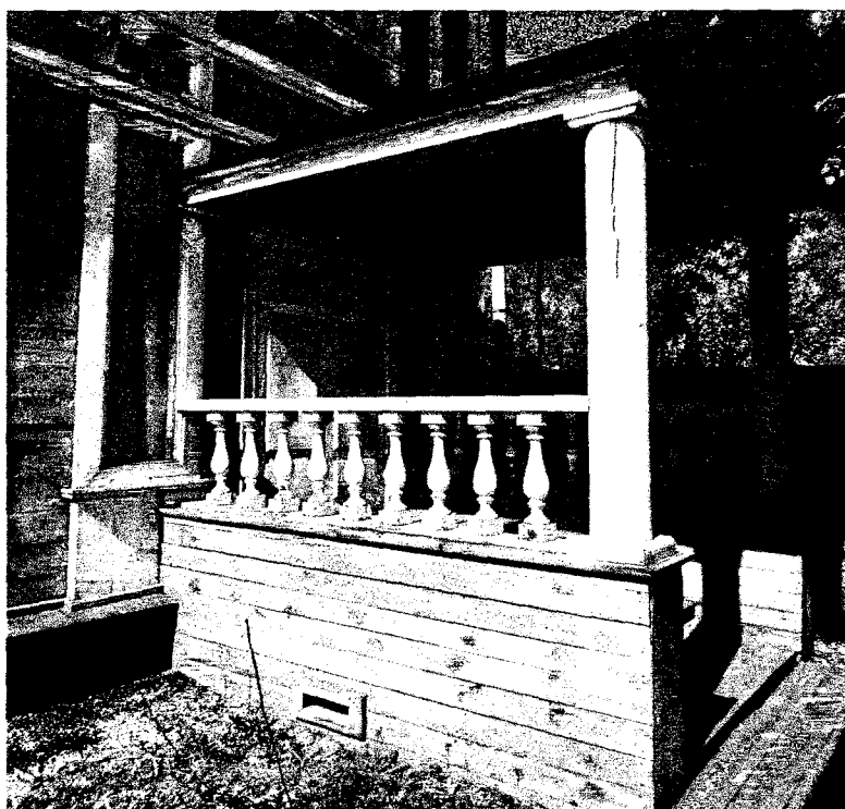
Северное крыльцо бокового фасада.
