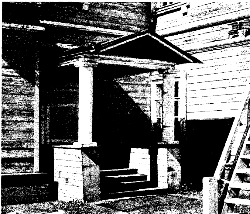
Крыльцо на юго-западном фасаде лит. А1.
