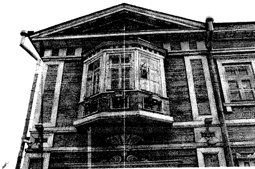
Фото 6. Эркер, левый ризалит Северо-западного фасада.
