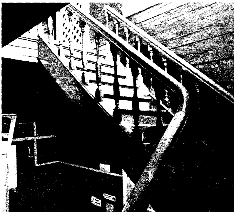
Лестница в пом. № 3 (1 эт).
