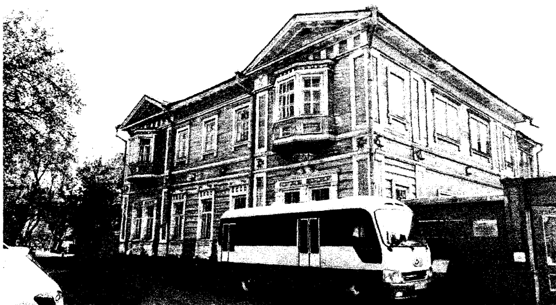
Вид на здание с запада.
