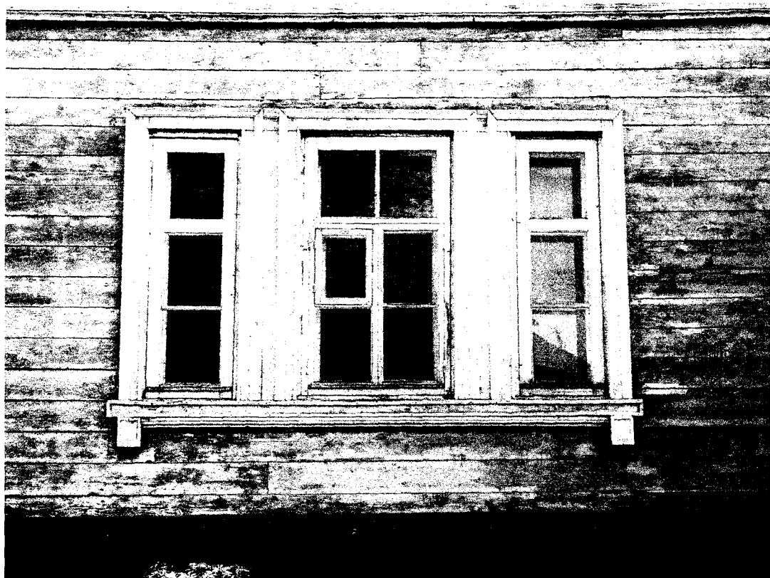
Наличник юго-западного фасада.
