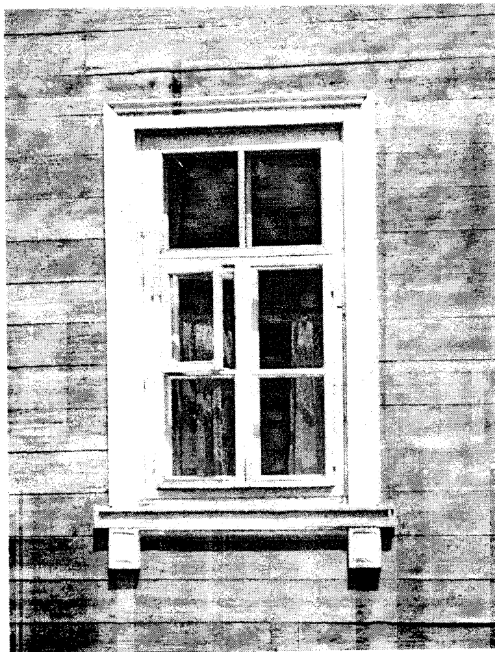
Фото 17. Наличник оконного проема первого этажа, Юго-западный фасад.
