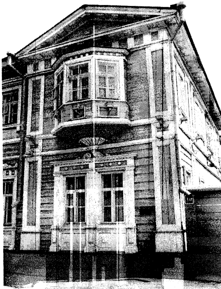
Фото 3. Фрагмент Северо-западного фасада, правый ризалит.
