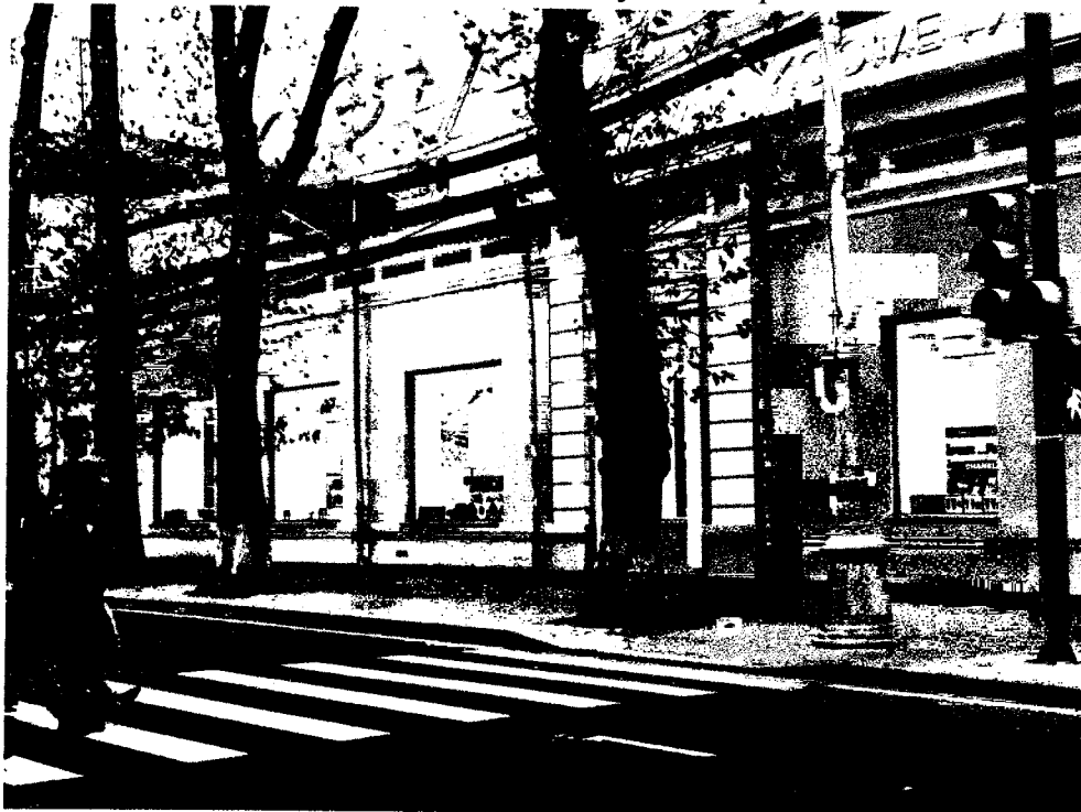
Северо-западный фасад по ул. К. Маркса.
