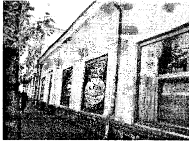
Фото 10. Фрагмент северо- западного фасада. Первоначальный дверной проем заложен до оконного. Сохранившийся фрагмент декоративного убранства фриза.
