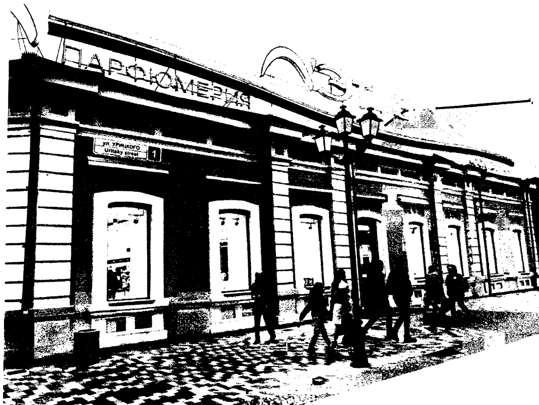
Юго-западный фасад по ул. Урицкого.
