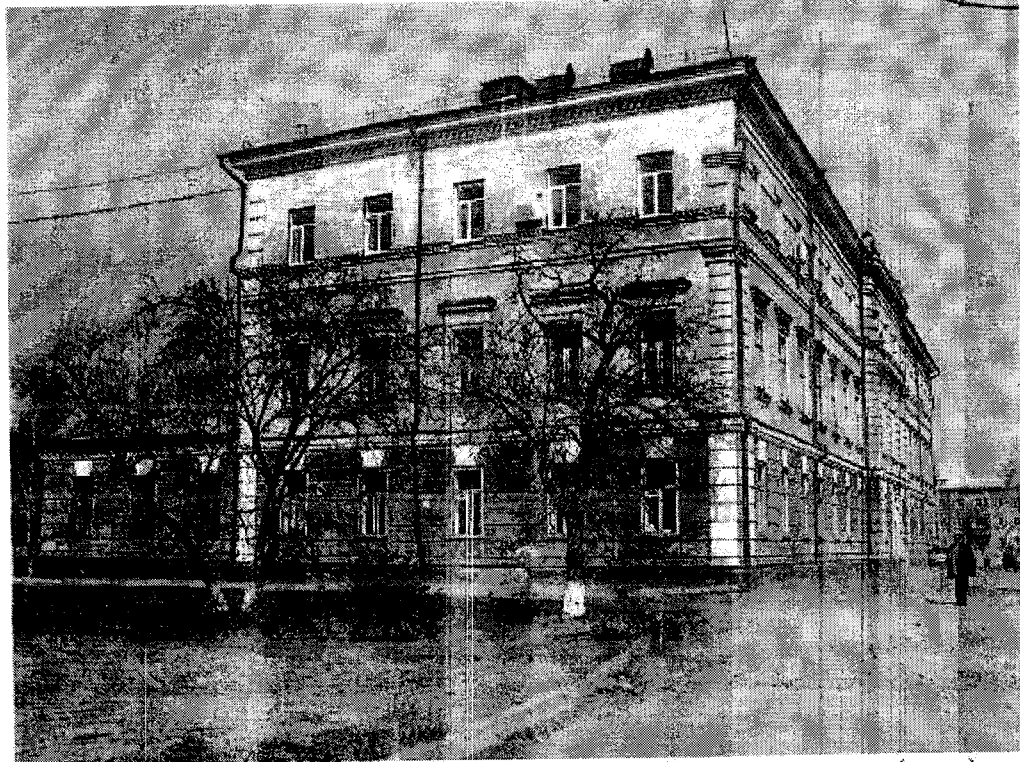
1. Общий вид здания (с юга)
