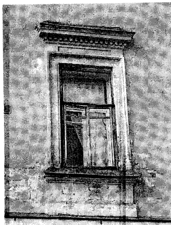
8. Оформление окна второго этажа на главном фасаде
