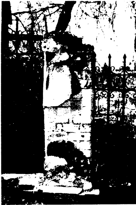
Утраты элементов ограды. Вывалы штукатурного слоя (с ул. Аэрофлотской)
