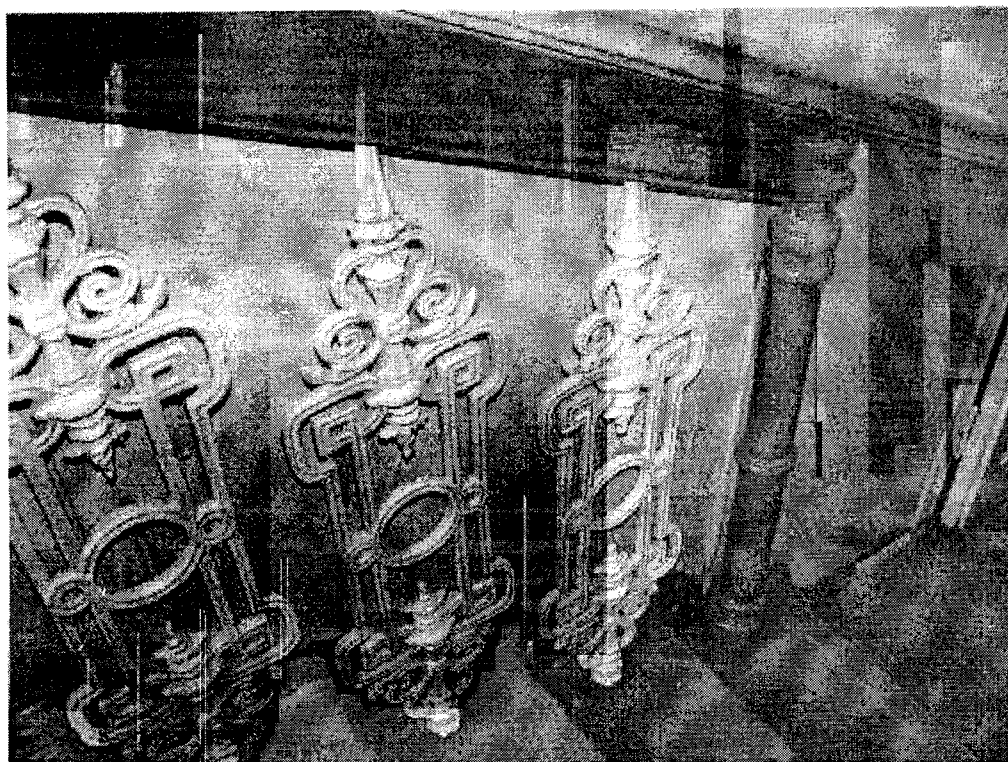
20. Ограждение лестницы правого крыла (первый этаж)
