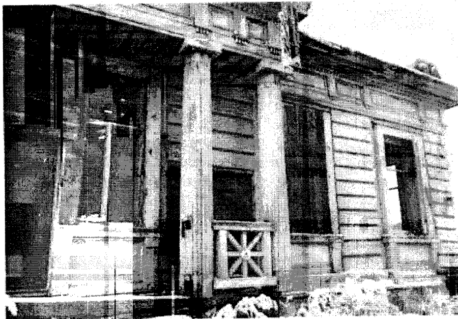
Фото 5 - Фрагмент (северо-восточного) фасада дома
