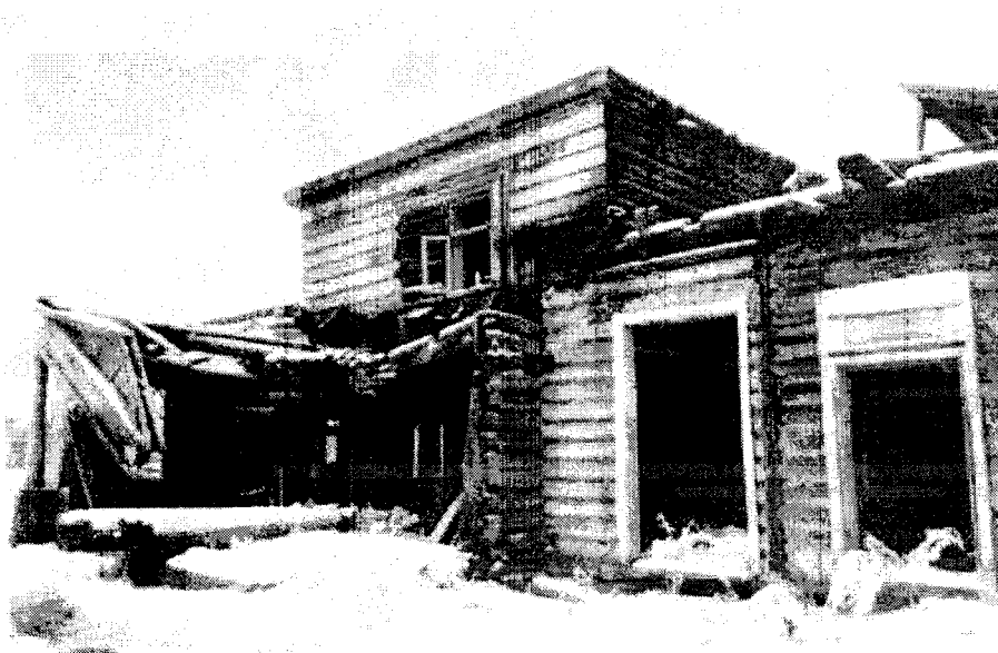
Фото 22 - Фрагмент дворового (юго-восточного) фасада
