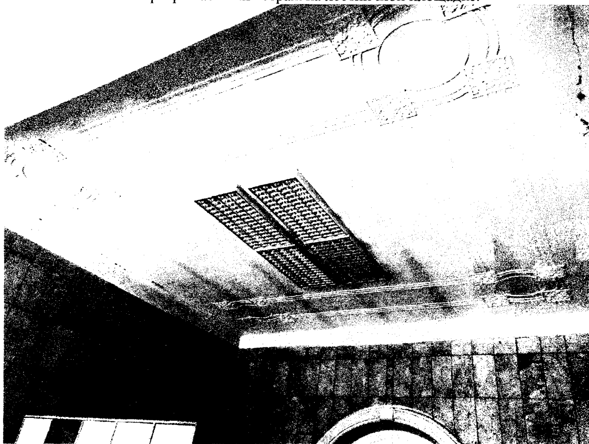
Интерьер. Геометрический рельеф потолка второго этажа лестничной клетки.
