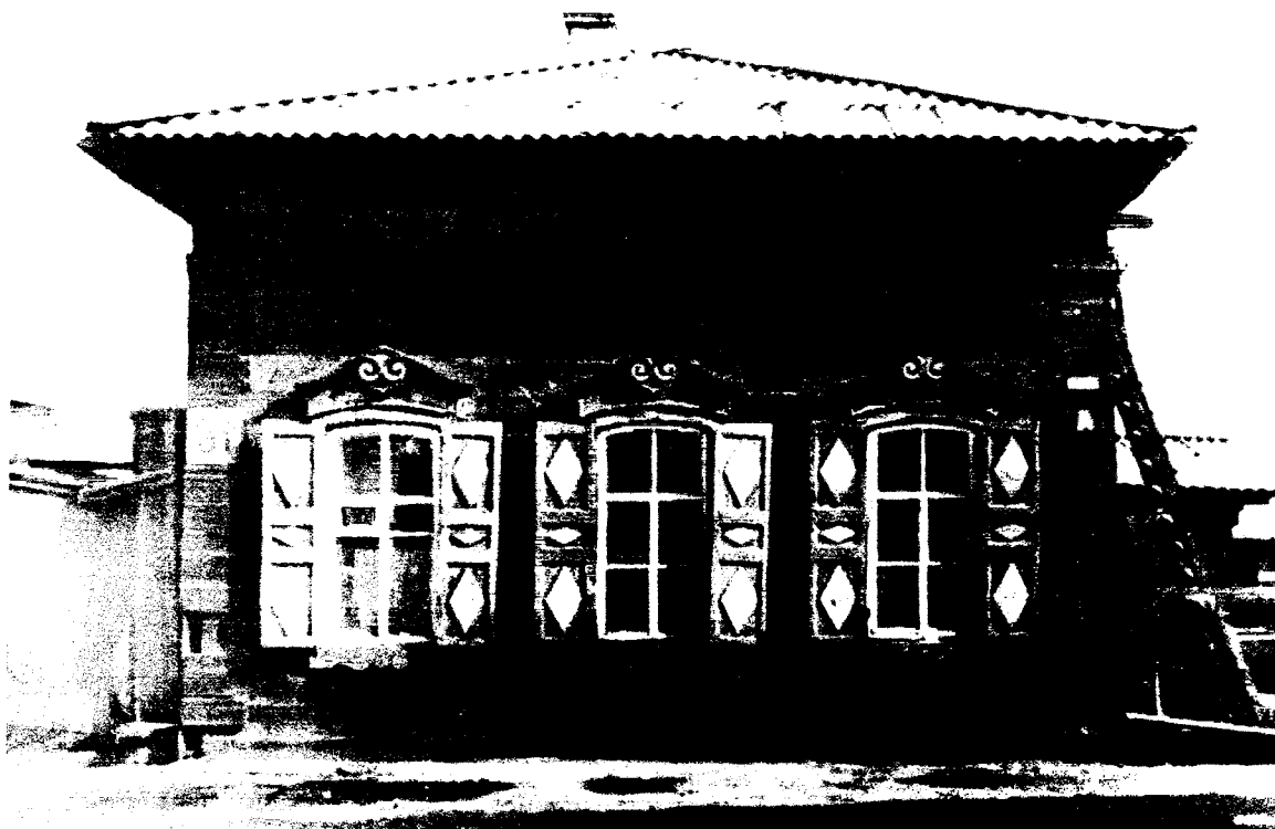
Главный (юго-западный) фасад. Фото 1983 г. (архив службы).
