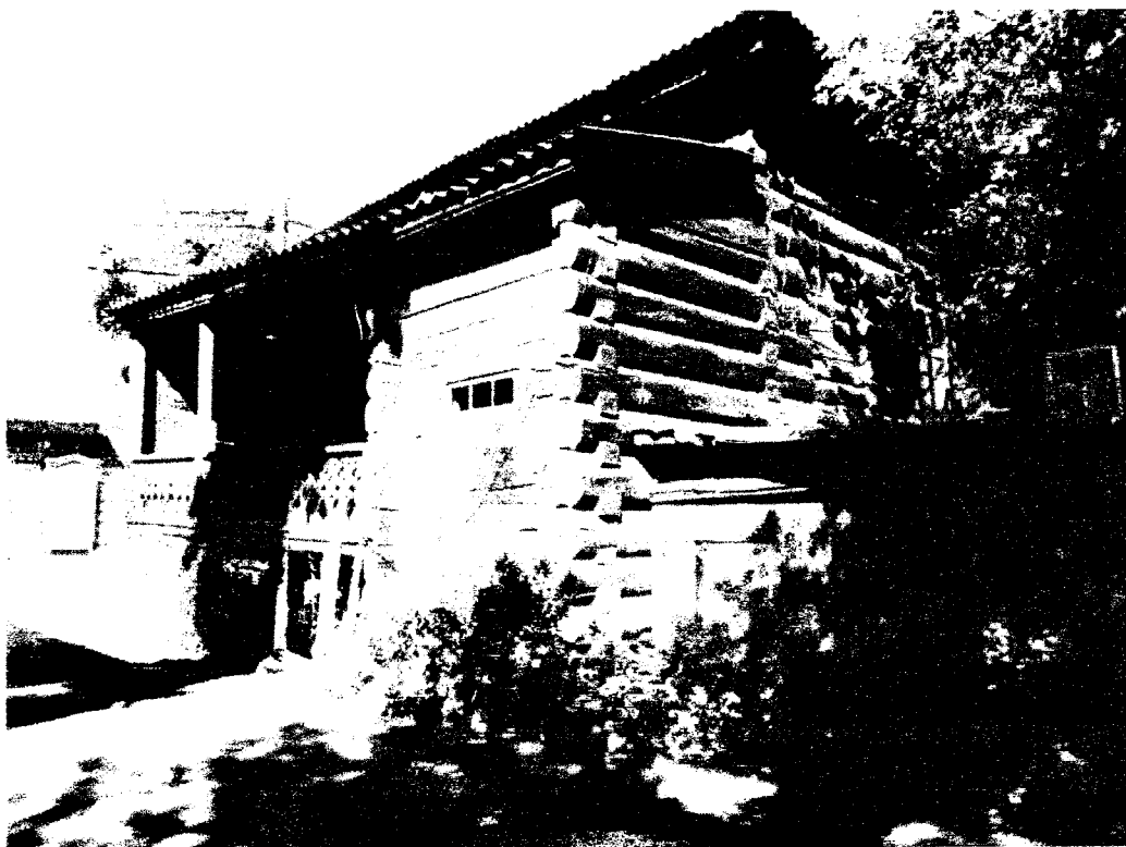
Фото 5. Общий вид на юго-восточный и северо-восточный фасады.
