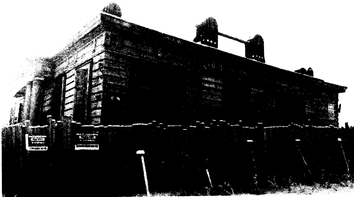
Фото 7 - Общий вид дома с перекрестка ул. Мира и Краснофлотская
