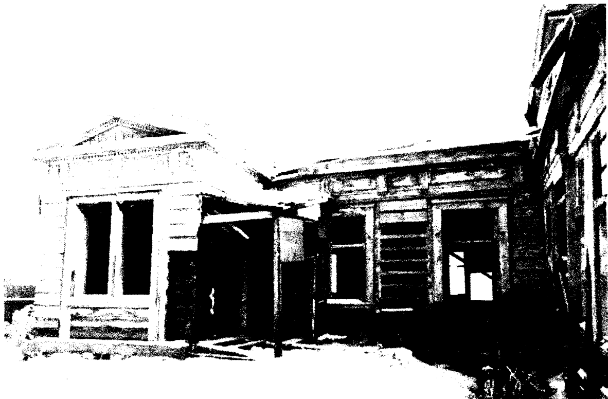
Фото 13 - Фрагмент (левой половины) дворового (юго-западного) фасада дома
