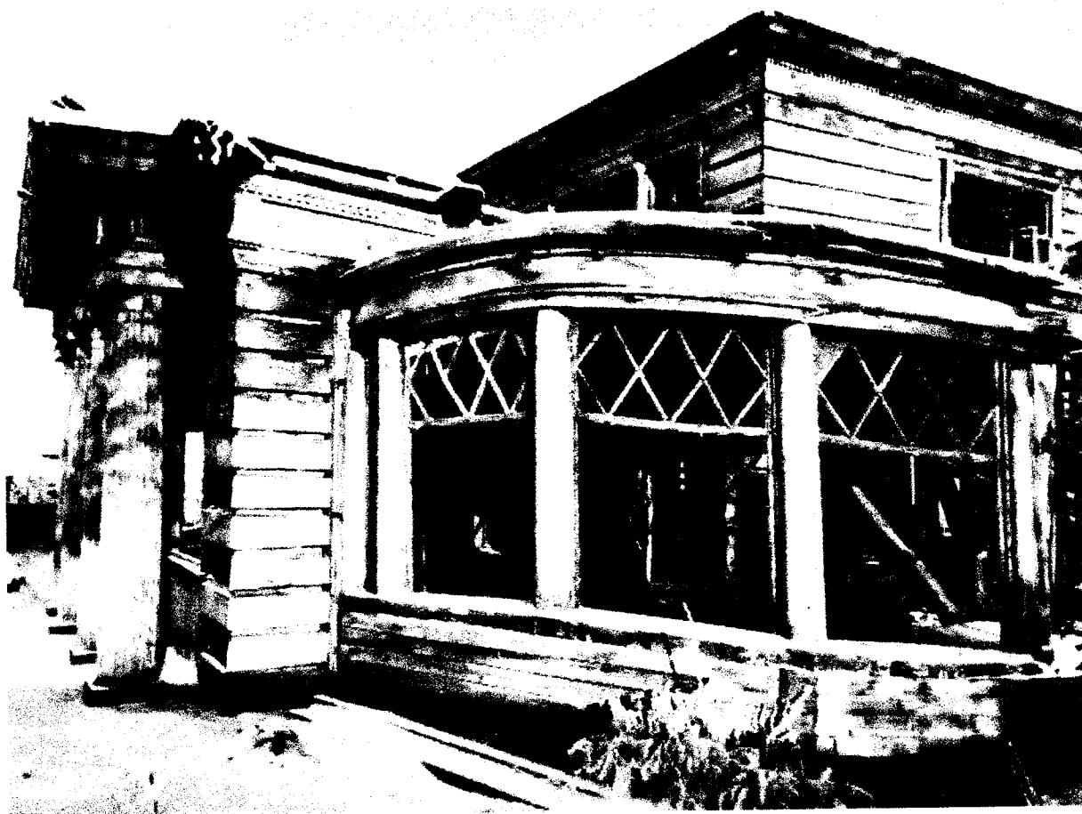
Фото 18 - Фрагмент дворового (юго-западного) фасада. Вид с южной стороны
