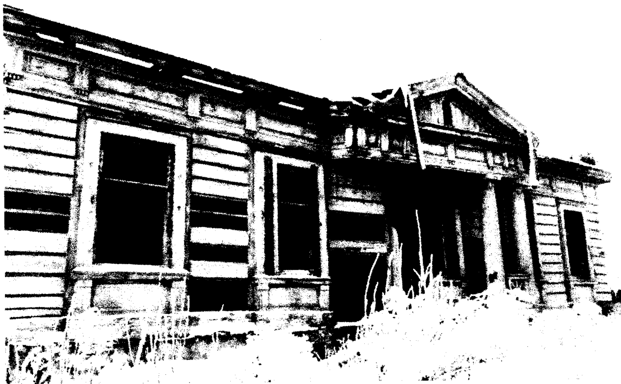
Фото 2 - Главный (северо-восточный) фасад дома. Вид с территории усадьбы
