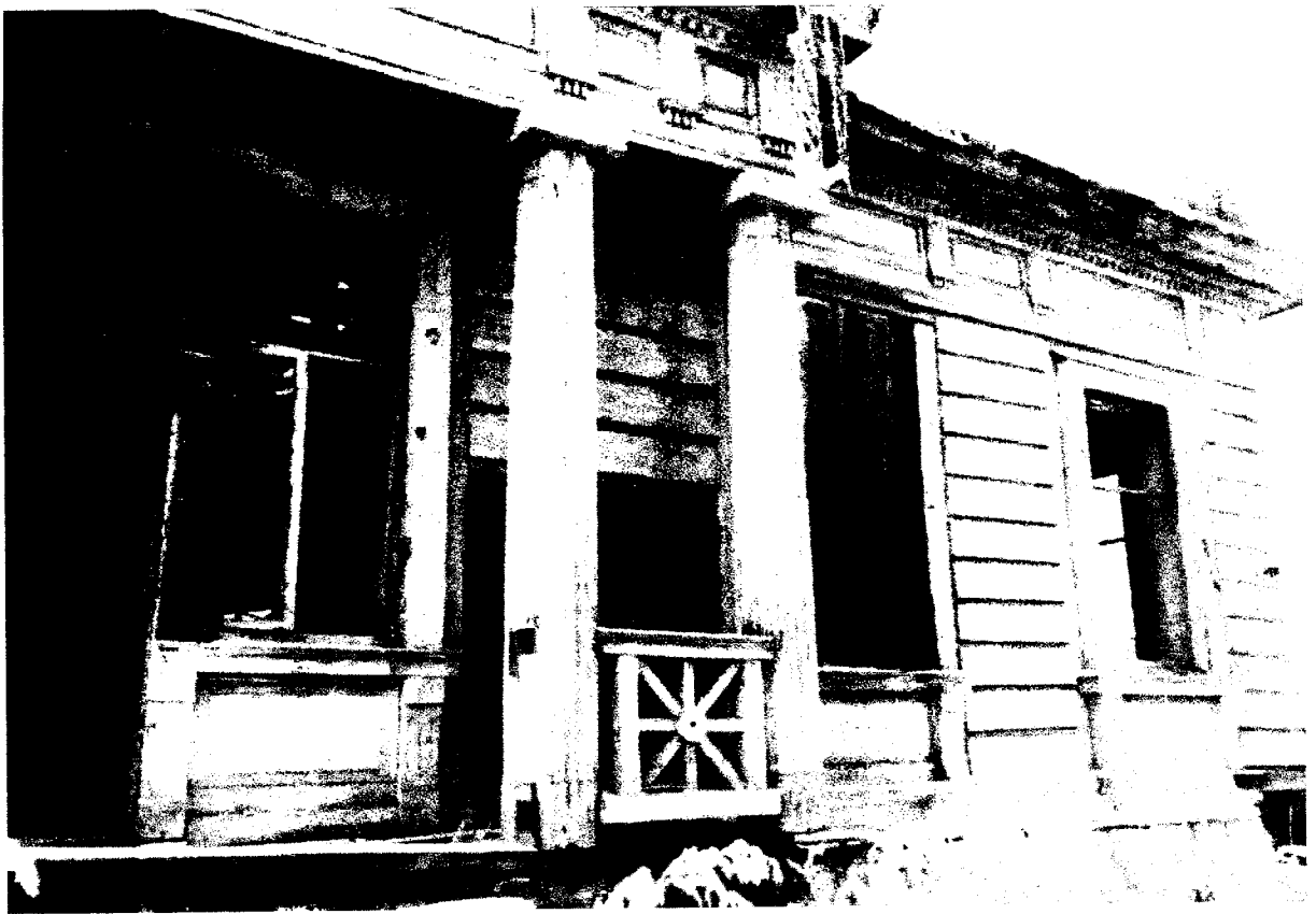
Фото 5 - Фрагмент (северо-восточного) фасада дома
