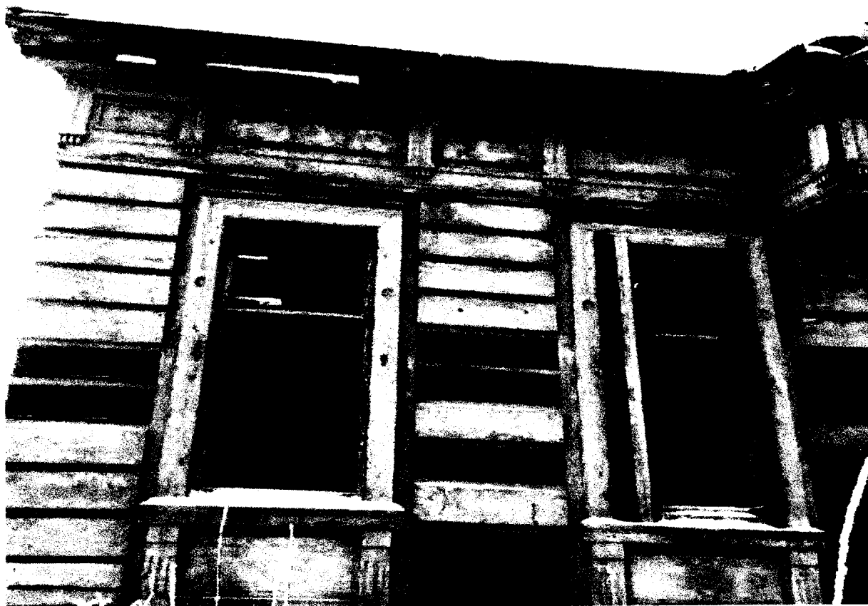
Фото 3 - Фрагмент левого фланга главного (северо-восточного) фасада дома
