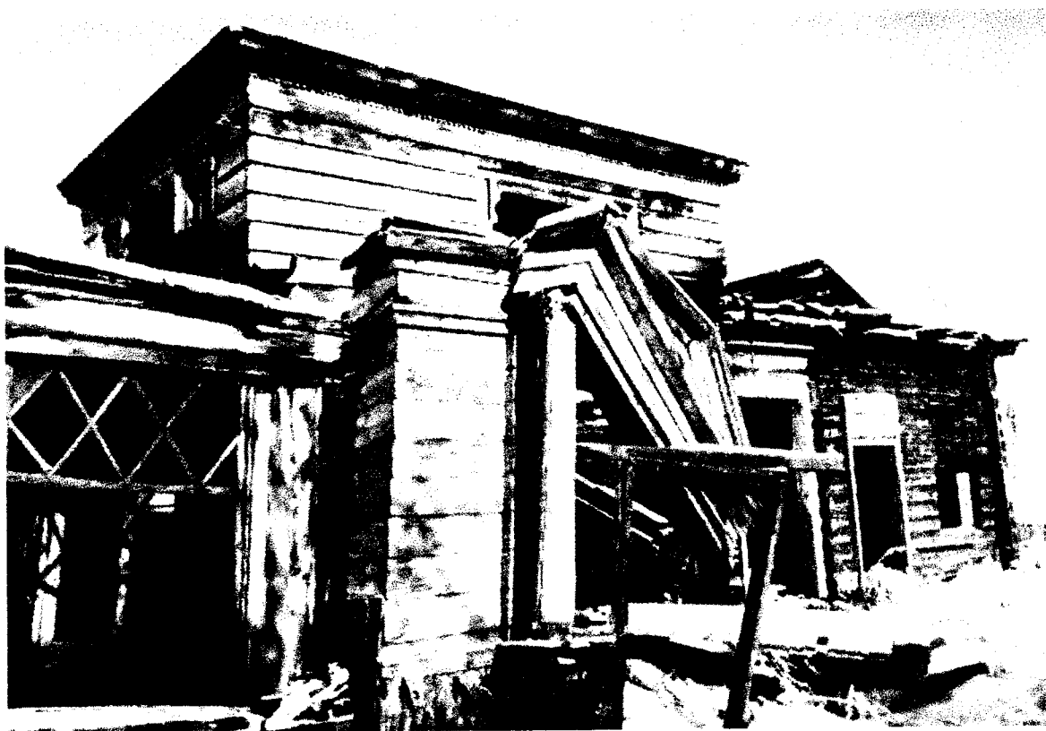
Фото 20 - Фрагмент дворового (юго-восточного) фасада. Вид с юга
