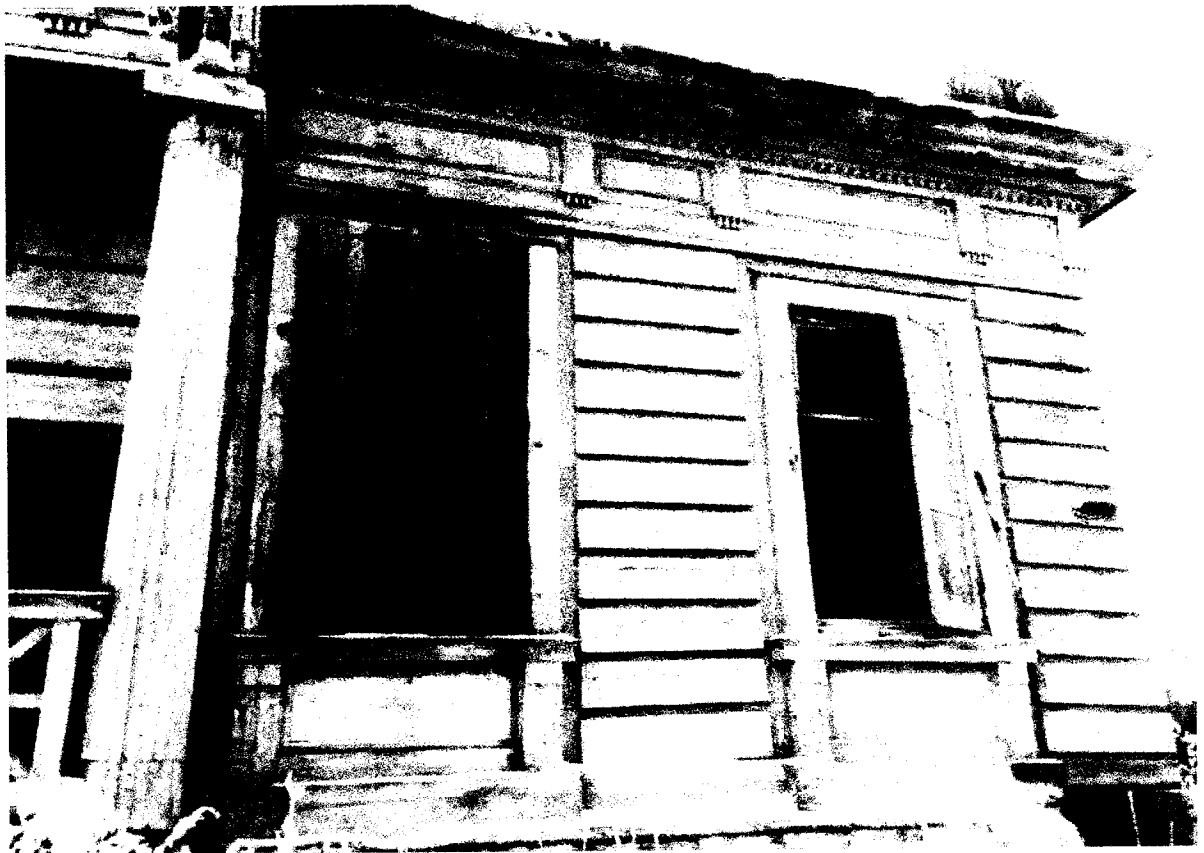
Фото 6 - Фрагмент правого фланга главного (северо-восточного) фасада дома
