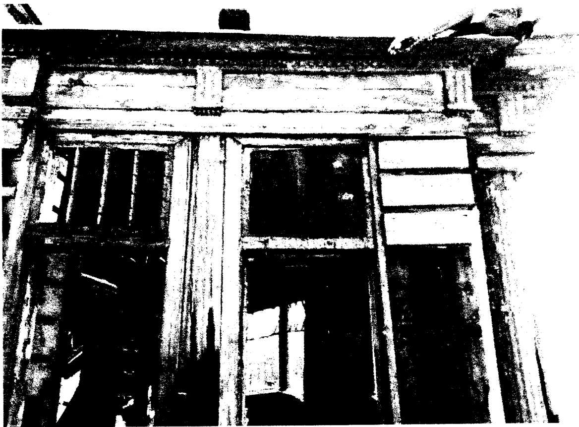
Фото 15 - Фрагмент (северо-западной) стены прируба на дворовом (юго-западном) фасаде
