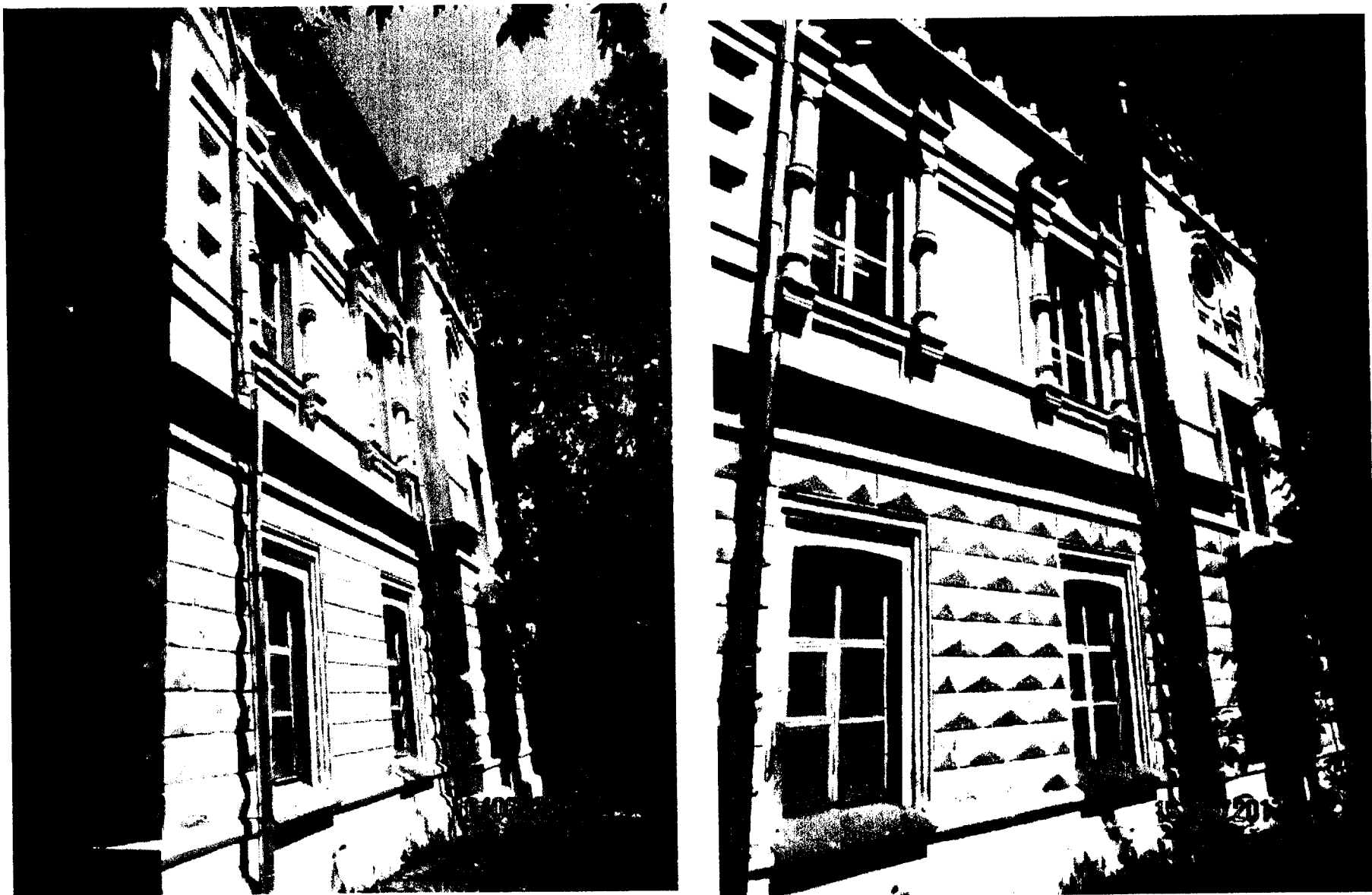
Фото 11 - Юго-восточный (торцевой) фасад
