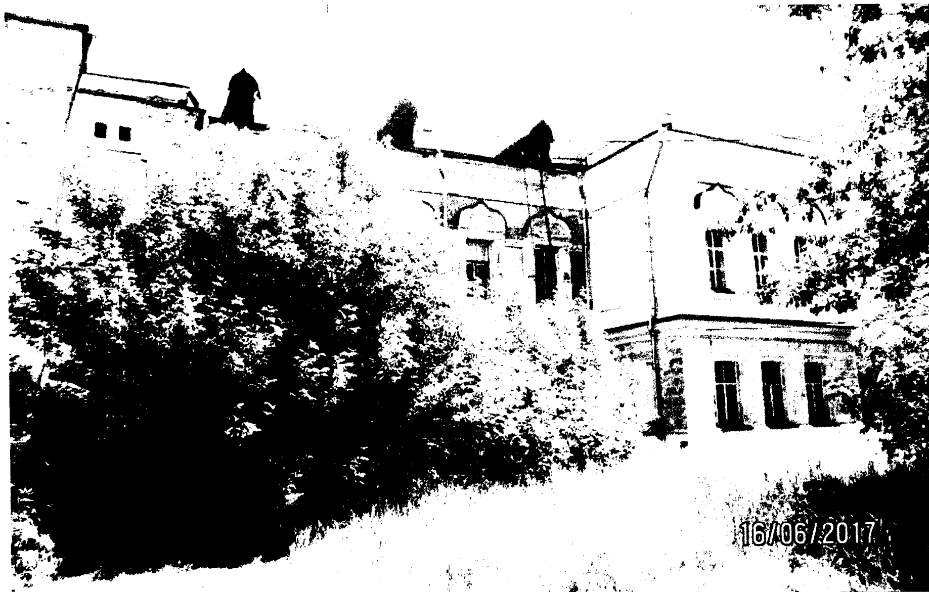
Фото 9 - Юго-западный (дворовой) фасад
