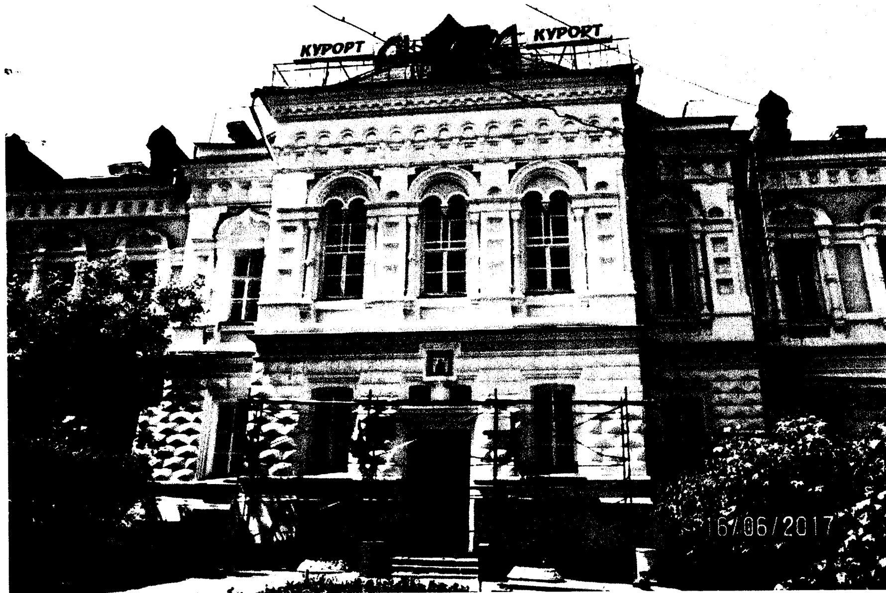
Фото 3 - Центральный ризалит главного северо-восточного фасада
