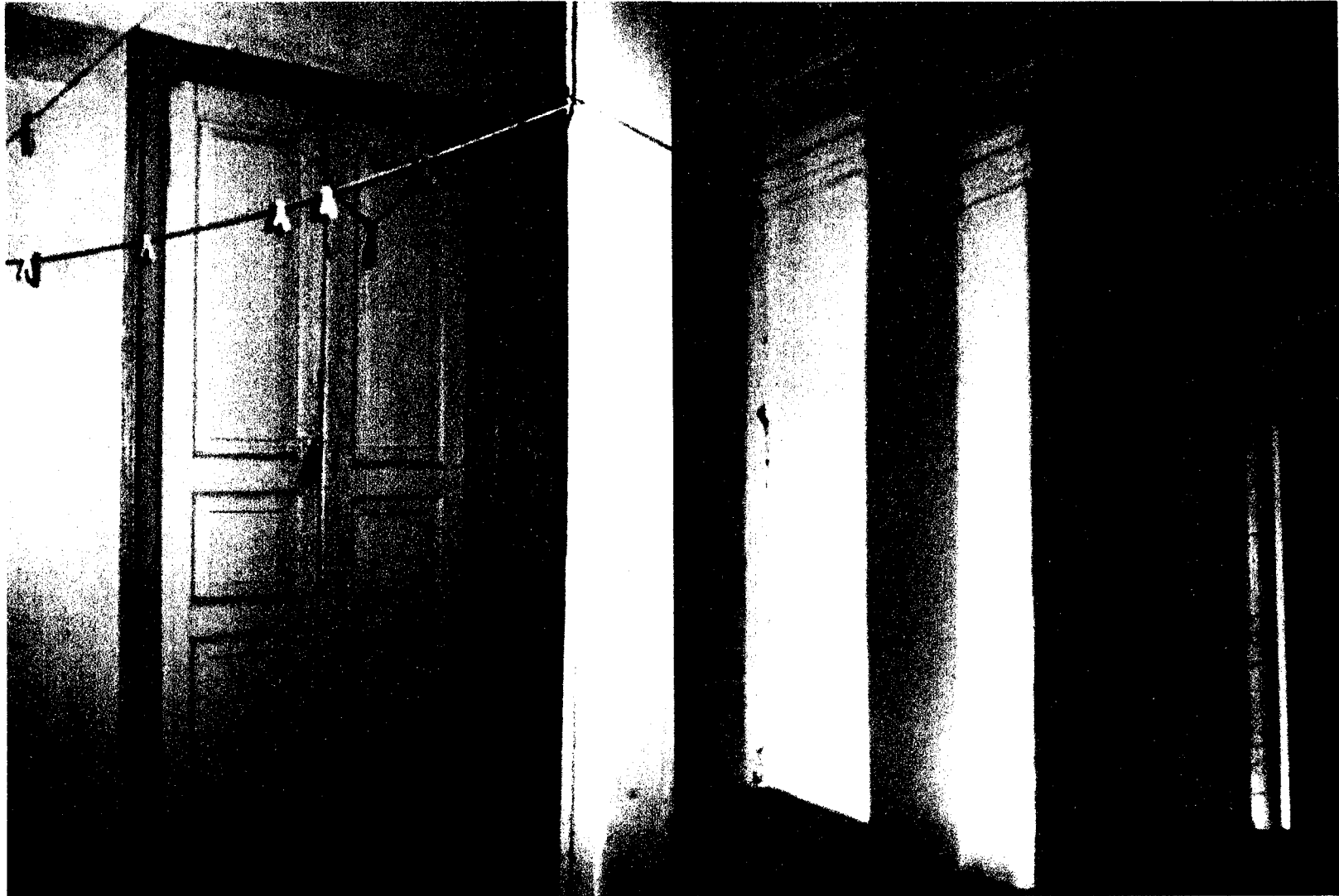
Фото 11 - Дверной проем в кв.№3, ком.8
