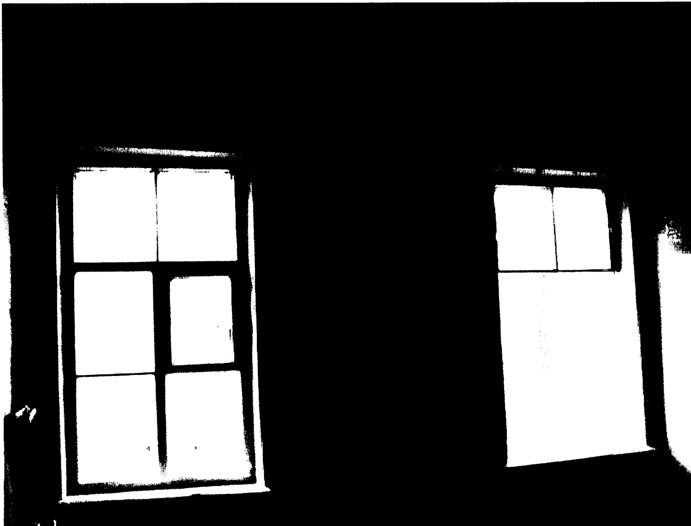
Фото 10 - Окна в кв.№3, ком.8
