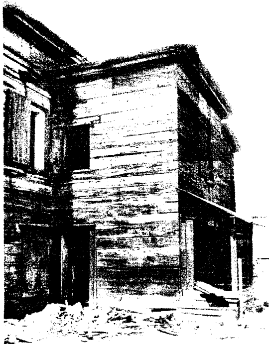
13. Юго-восточный (боковой) фасад здания с 2-этажными прирубями, фото Барановского Е.Ю., 1991 г.
