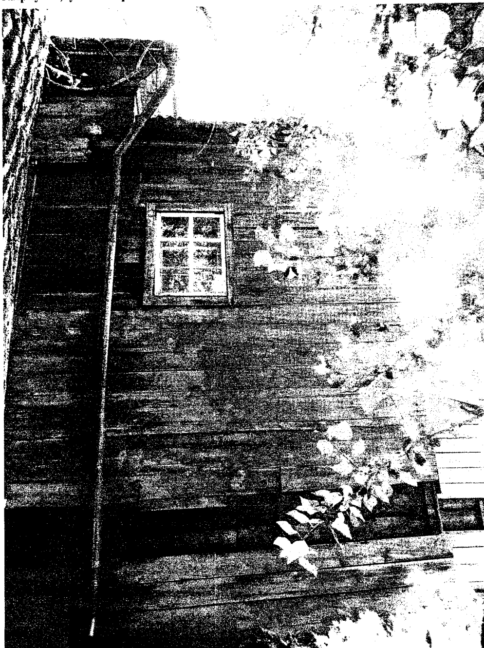
20. Фрагмент северо-восточного фасада, северный угол (место примыкания 2-этажного пониженного лестничного прируба), июль 2014 г.
