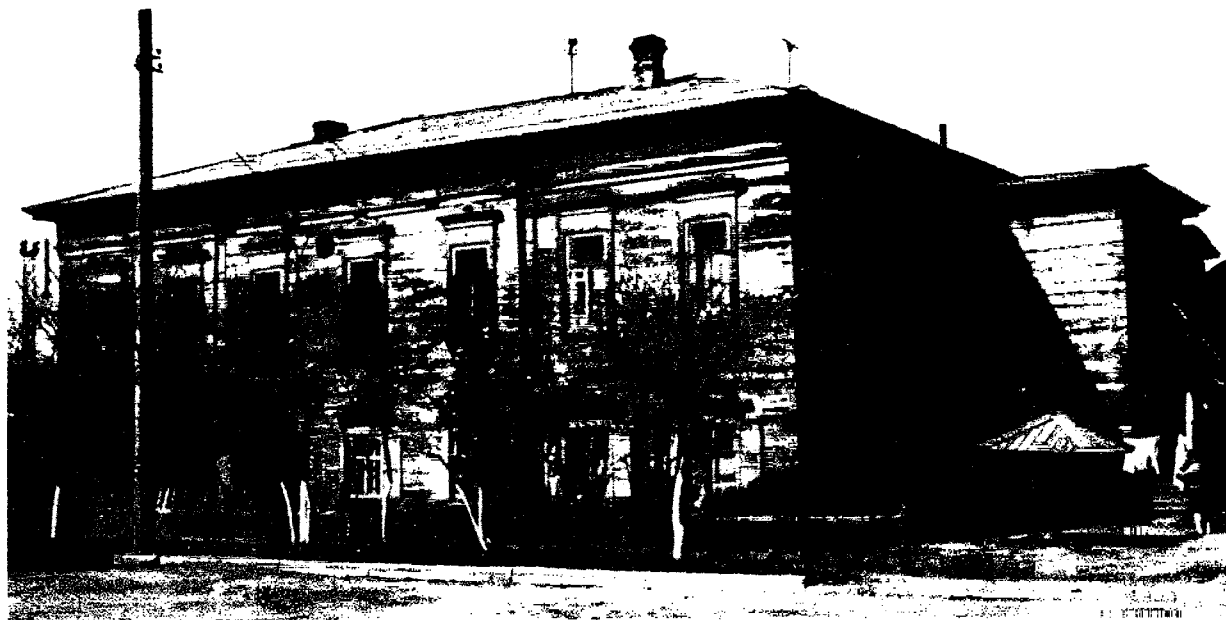
Общий вид здания. Фото 1973г. (архив службы)
