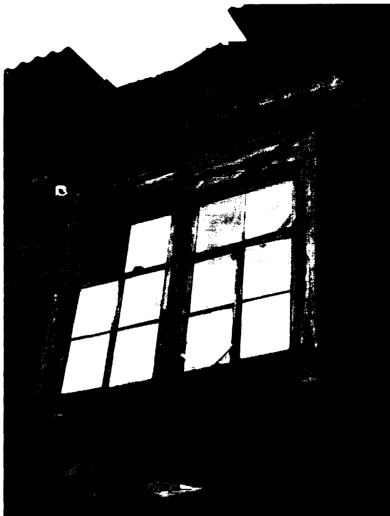
Фото 9 - Наличник 2 этажа северо-восточного фасада.
