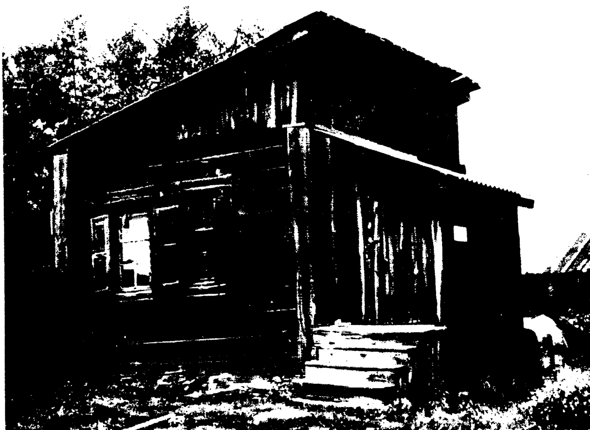
Фото 1989г. Общий вид с юга., арх. Л.Г. Басина.
