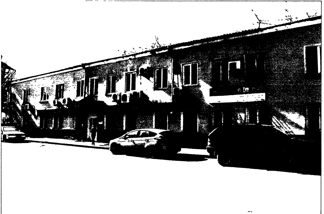
Фото А.А. Жильцов, июнь 2018 г. Степана Разина, 42, Лит. Б. Юго-восточный фасад.
