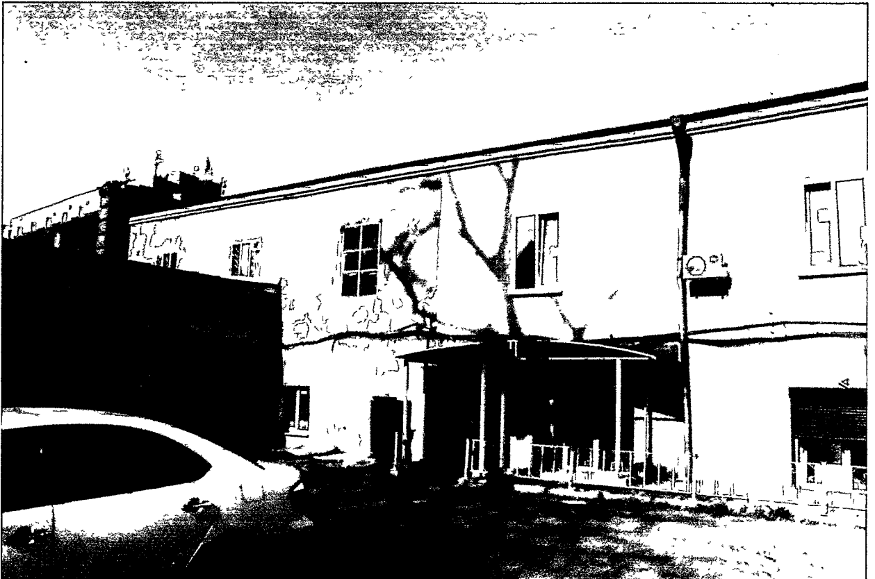
Фото А.А. Жильцов, июнь 2018 г. Лит. В. Фрагмент юго-западного фасада.
