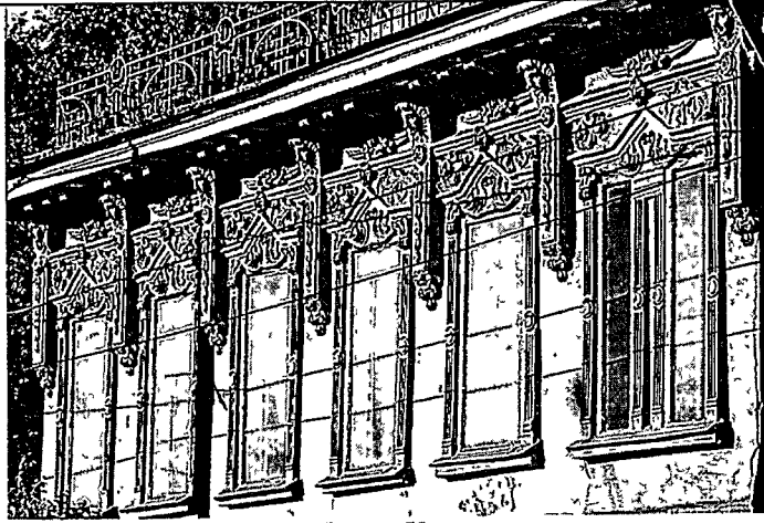
Северо-восточный фасад. Уровень второго этажа.
