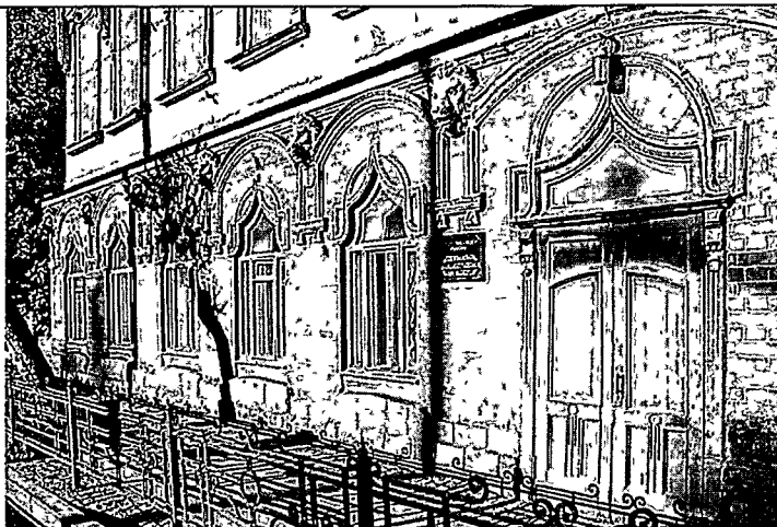
Северо-восточный фасад. Уровень первого этажа.
