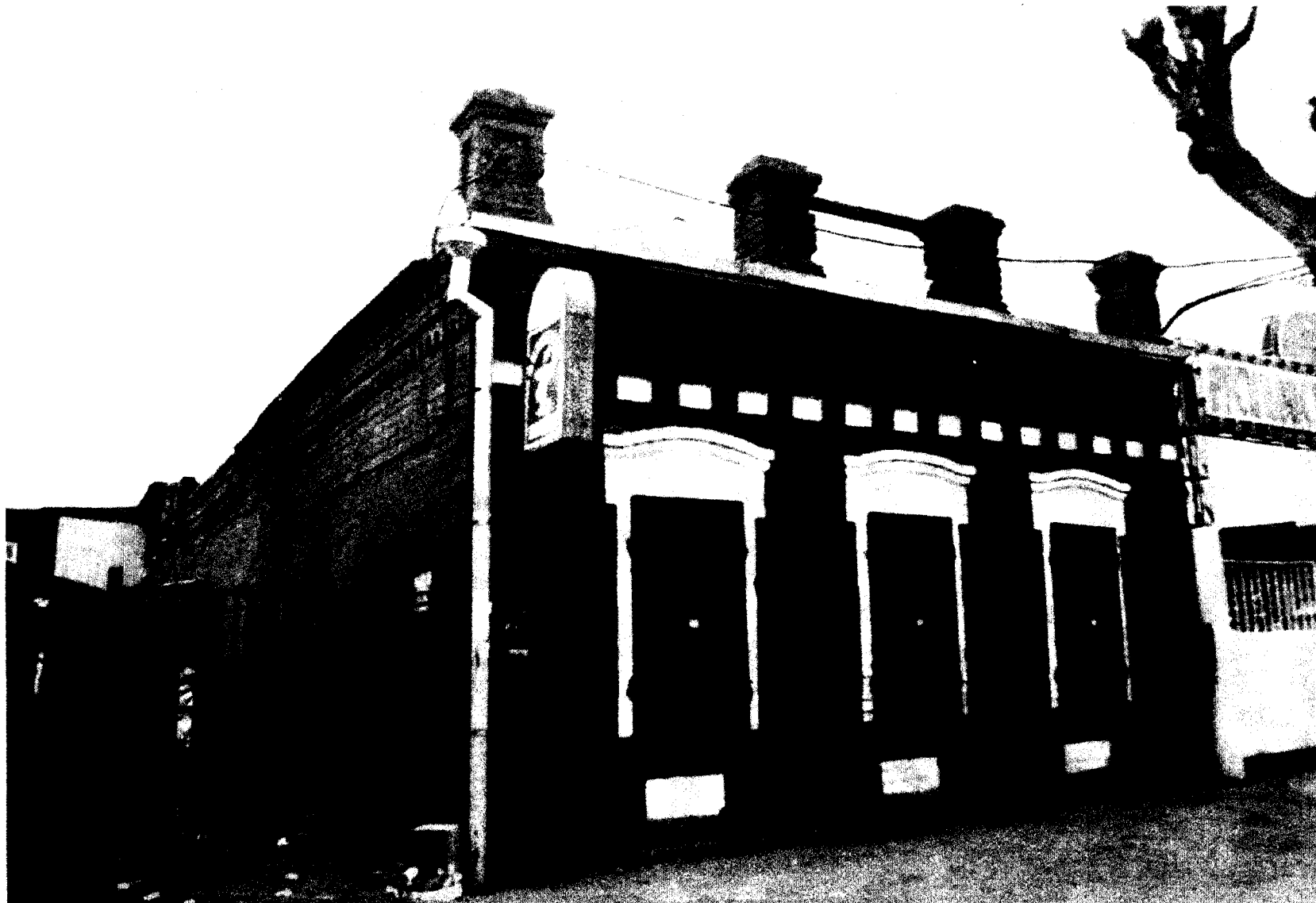
Фото №9 - Общий вид здания с ул. Байкальской до перестройки в 1999г. (с западного угла)
