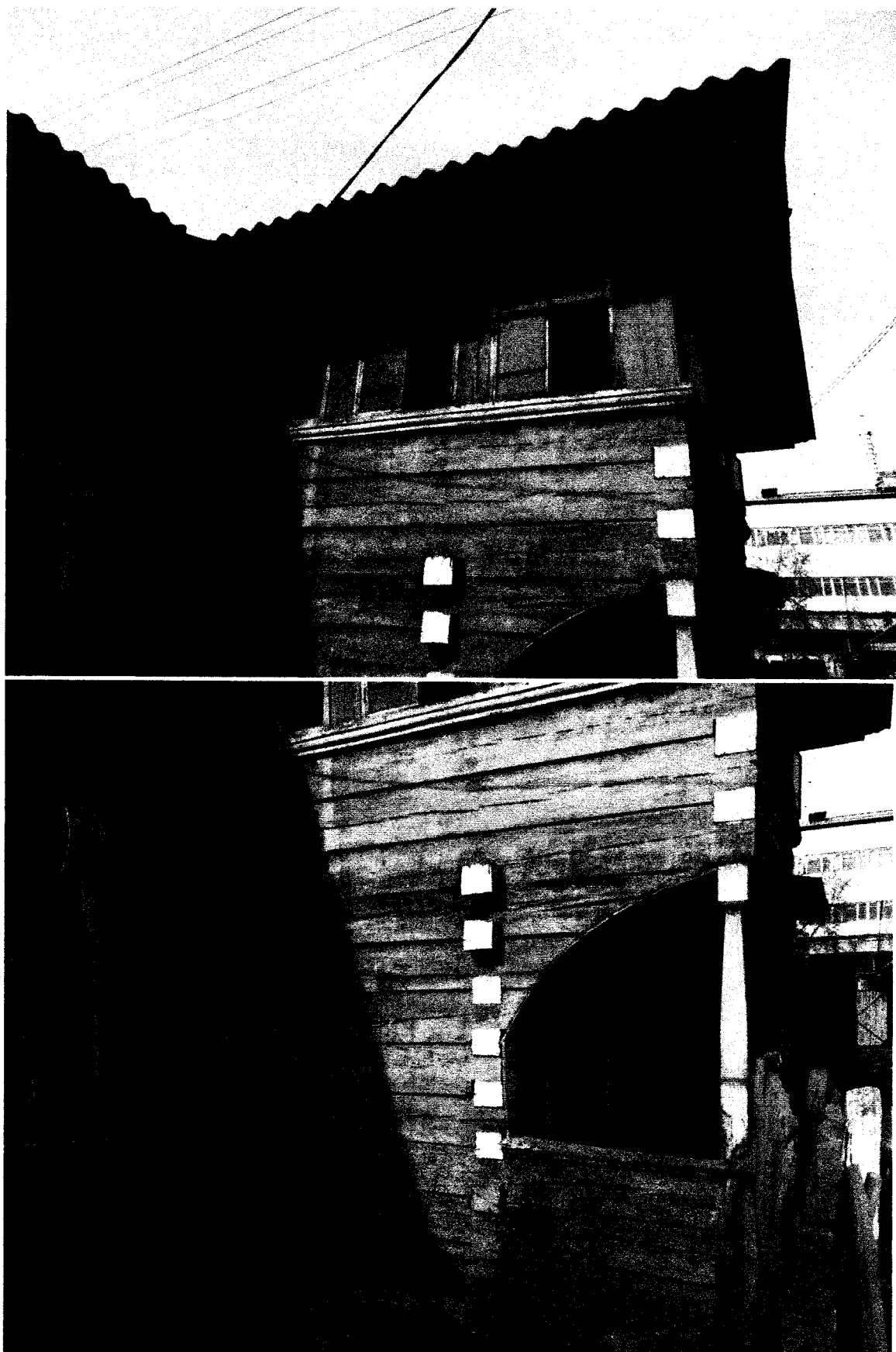
Фото №5 - Фрагменты юго-западной стены прируба сений.
