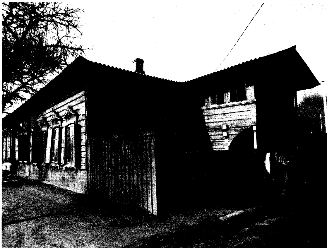
Фото №1 - Общий вид дома с южного угла, с улицы Баррикад.
