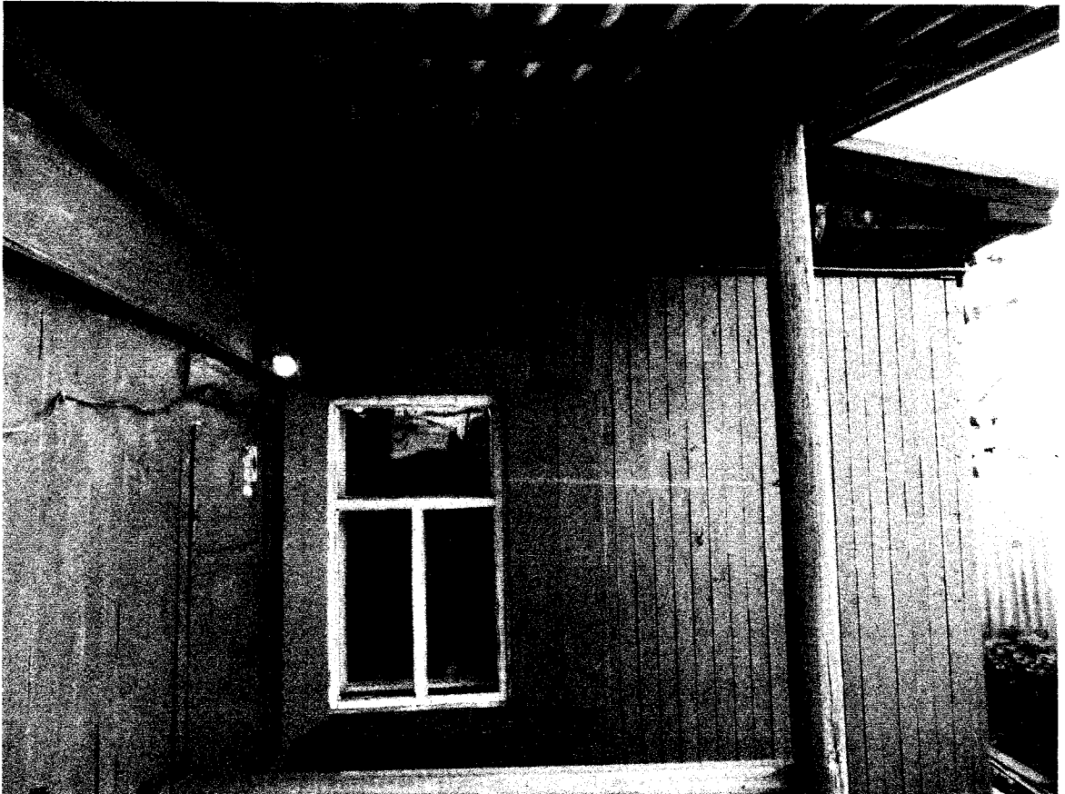
Фото №8 - Фрагменты бокового юго-восточного фасада (с правого фланга).
