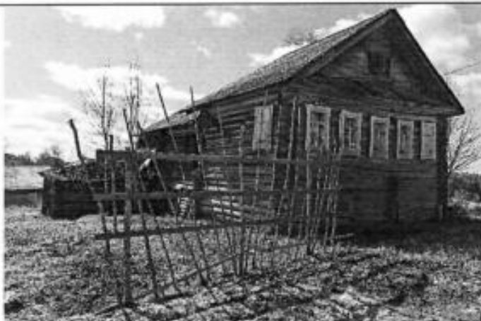
Жилой дом №2 -изба на высоком подклете, с фронтоном и прирубами. Цветовая гамма отделки фасадов: без покраски, наличники окон окрашены в белый цвет.
