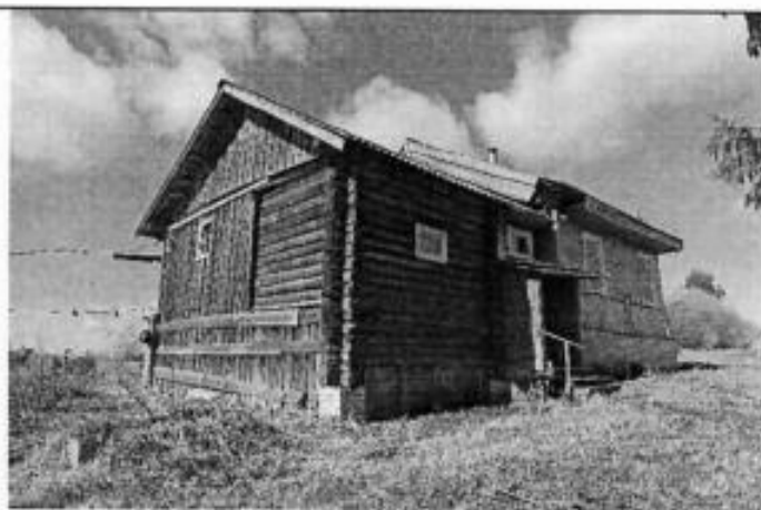
Дом родителей Белова, изба стены - сруб, отделка - тес; прируб стены - сруб, частичная отделка - тес
